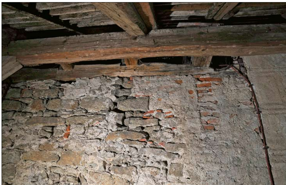
Obr. 19: Detail severní zdi lodi v podstřeší přístavky z 60. let 19. století. Vpravo zdivo věže, vlevo část zdiva pod vazbami č. 1–3. Cihelná vysprávka s otiskem konzoly vazby č. 1 byla zjevně vyždívána ze strany interiéru lodi. S dozdívkou souvisí i ostrůvky malty kolem stínů konzol vazeb č. 2 a 3 na vymytém kamenném zdivu. Vpravo nahoře ohořelá část pozednice.
