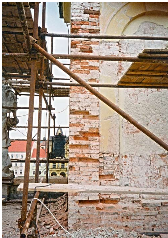
Obr. 18: Jižní boční věž radnice při rekonstrukci v 90. letech 20. století. Po odstranění omítky se ukázalo, že nároží jsou vyzděna klasicky, ale mezilehlé plochy pouze „auf halben Zügel dik“, jak to odpovídá rozhodnutí městské rady z 27. května 1729 (SOKA České Budějovice).
