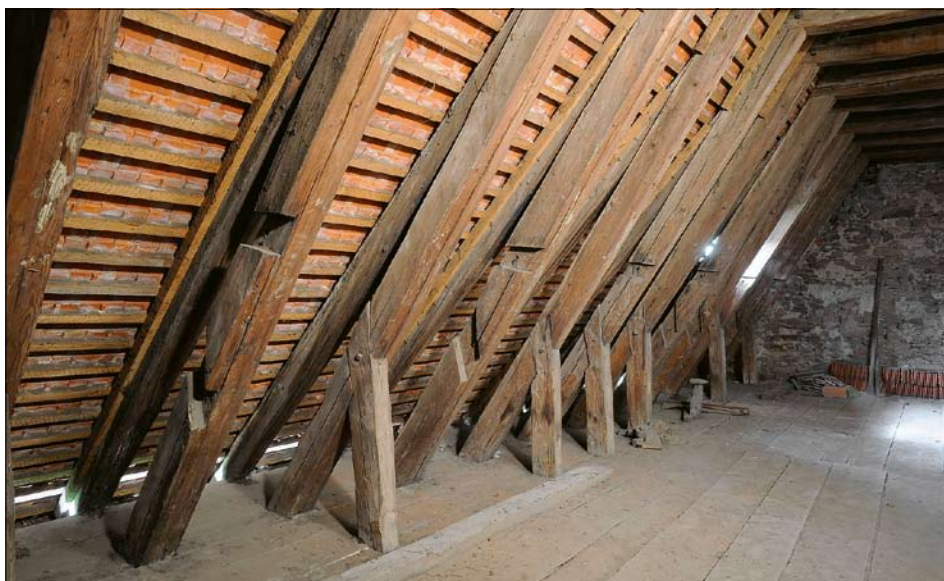
Obr. 20: Krov nad lodí, paty vazeb na jižní straně. Patrné jsou prázdné dlaby po vodorovných vazných prvcích zaniklého obranného ochozu. Pohled k západu.
