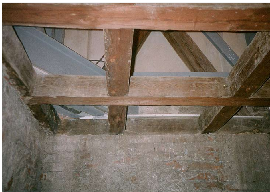
Obr. 15: Detail založení dřevěné ztužovací konstrukce na dřevěném roštu v patě prostřední věže. Pohled zdola na rošt, nad nímž jsou vidět vložené ocelové nosníky, 90. léta 20. století (SOKA České Budějovice).
