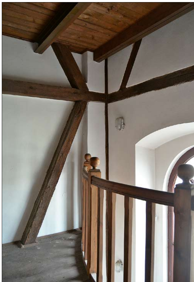
Obr. 17: Nosná a ztužovací dřevěná konstrukce prostřední věže v úrovni horní části východního okna. Pohled do severovýchodního rohu, stav 2021.
