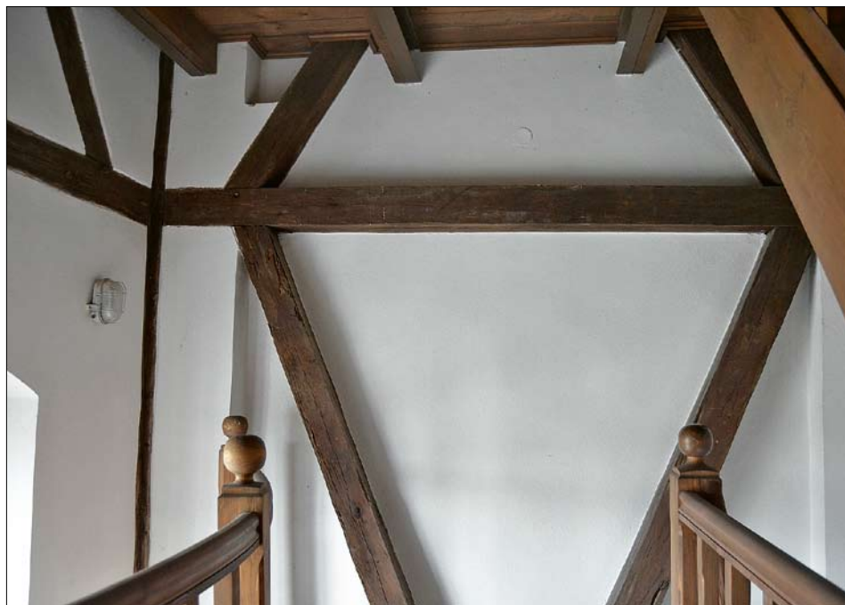
Obr. 16: Nosná a ztužovací dřevěná konstrukce prostřední věže v úrovni horní části východního okna. Pohled na jižní stěnu, stav 2021.
