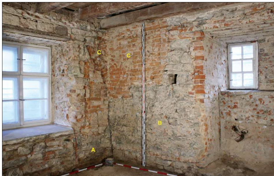
Obr. 41: Opava, Müllerův dům čp. 1, operativní průzkum a dokumentace 2016–2017. Dochovaný průběh městské parkánové hradby (A) v místě styku s přiloženou jižní obvodovou zdí hradních kuchyní (B), pozůstatky cihlového náběhu druhotně odsekaného vynášecího pasu dymníkového komínu (C), místnost 008, pohled od severozápadu (foto F. Kolář, 2016).
