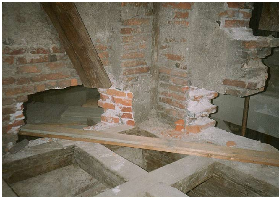
Obr. 14: Detail založení dřevěné ztužovací konstrukce na dřevěném roštu v patě prostřední věže. Odřezáním šikmého zavětrovacího trámu a proražením otvorů ve zdivu vznikl prostor k provlečení ocelového nosníku, 90. léta 20. století (SOKA České Budějovice).
