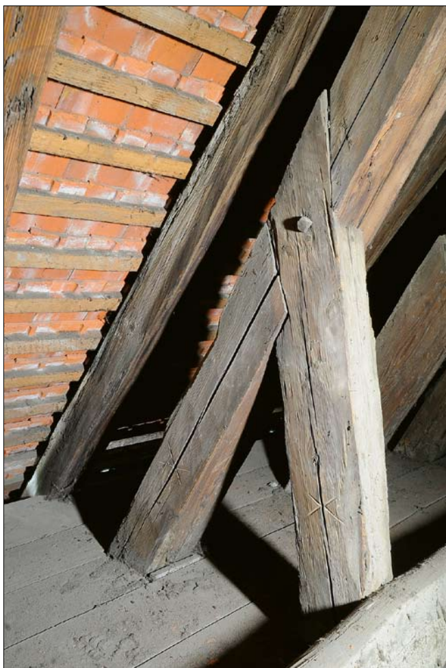
Obr. 13: Krov nad lodí, jižní pata vazby č. 10 se značkou vyseknutou sekýrou.
