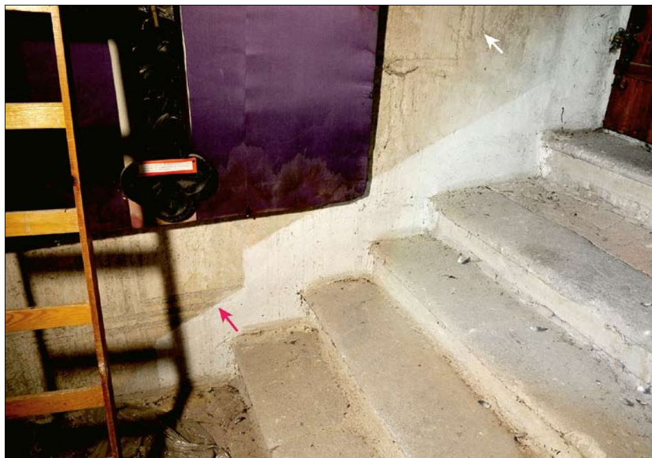
Obr. 27: Patro západní předsíně lodí; detail severní stěny s původně fasádní sgrafitovou omítkou věže. Šipkami vyznačeno šikmé rozhraní rustiky a hladké omítky, značí otisk střechy starší předsíně (srov. obr. 3:o; 24:o).
