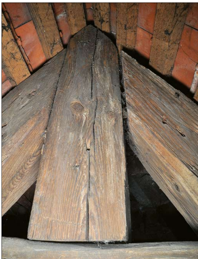
Obr. 9: Krov nad lodí, způsob napojení krokvi a sloupku ve vrcholu vazby č. 1. V pravé spáře je partný dřevěný hřeb, jímž je krokev přibita ke sloupku.
