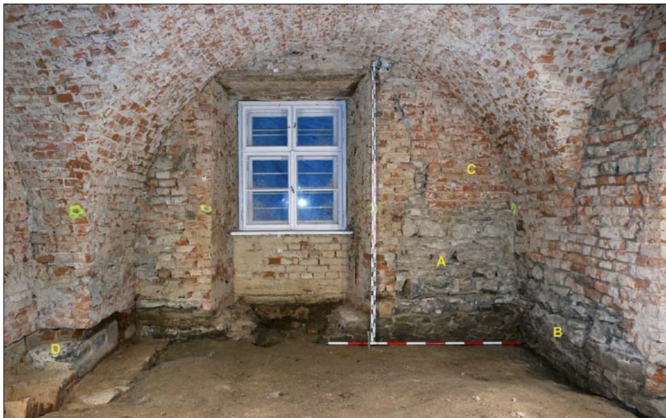
Obr. 40: Opava, Müllerův dům čp. 1, operativní průzkum a dokumentace 2016–2017. Dochovaný průběh spojovací hradby městského opevnění a hradu (A) v místě provázání s městskou parkánovou hradbou (B), pozůstatky cihlového náběhu druhotně odsekaného vynášecího pasu dymníkového komínu (C), fragment středověkého okenního ostění (původně patrně z hradního paláce) druhotně užitý ve spodní partii barokního pilíře vynášejícího klenbu, místnost 005, pohled od jihu (foto F. Kolář, 2016).
