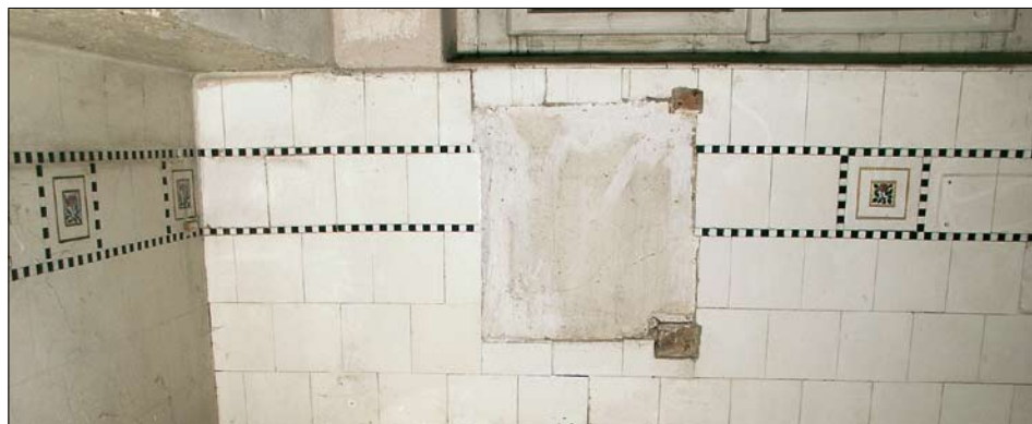
Obr. 32: Libodřice (okres Kolín), Bauerova vila z r. 1914, detail poškozeného keramického obkladu koupelny (foto J. Veselý, 2005).
