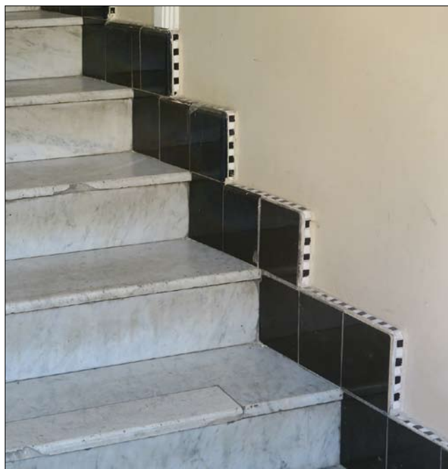
Obr. 22: Praha, Smíchov, keramický obklad prostoru vstupního schodiště v nájemném domě čp. 1278/XVI z roku 1911, Náměstí 14. října 1. Úsporné řešení s pouhou jednou řadou obkládaček je zde pohledově zvýrazněno úzkými černobílými pásy.
