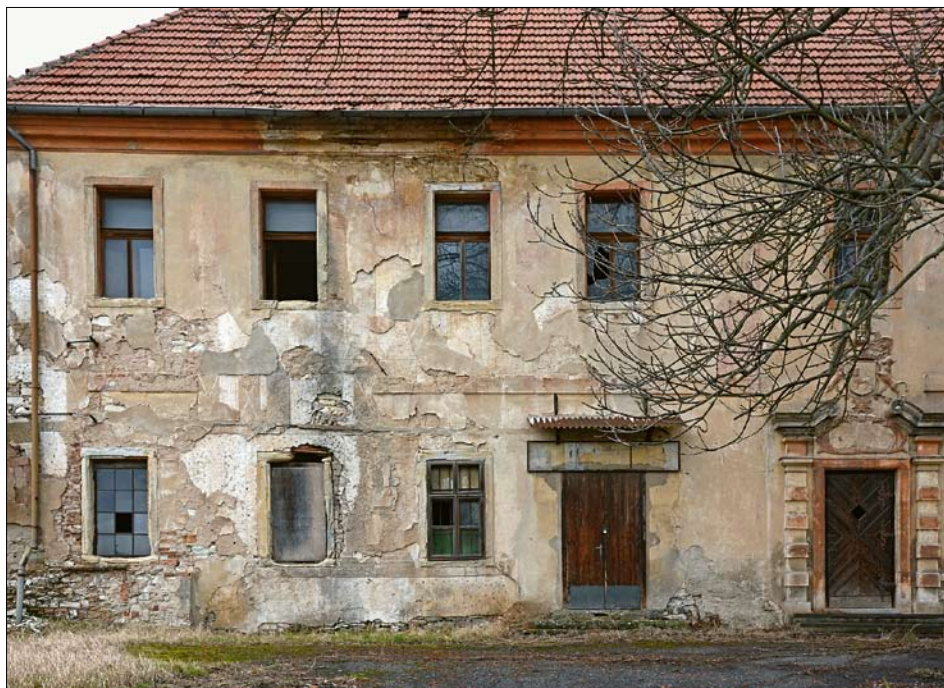
Obr. 13: Jižní průčelí středního rizalitu jižního křídla zámku v Zahořanech s pískovcovým okenním ostěním v parteru, odkud byly odebrány vzorky Z2 a Z9 (foto J. Adamovič, 2021).
