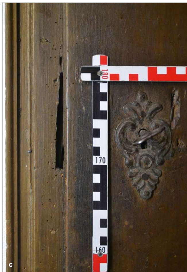
Obr. 10: Dobřív čp. 5, obytné stavení: a – dveře ve vstupu ze síně do zadní světnice, detail rozvilinového závěsu s přikovanými ozdobnými konci, se zdobením rýhami a tvarováním; b – svlaková dvířka odkládací niky v síni, detail vnějšího esovitého závěsu zdobeného ornamenty a tvarováním při okrajích; c – svlaková dvířka odkládací niky v síni, detail dekorativního plechového klíčového štítku zdobeného tvarováním (foto S. Plešmíd, 2019).
