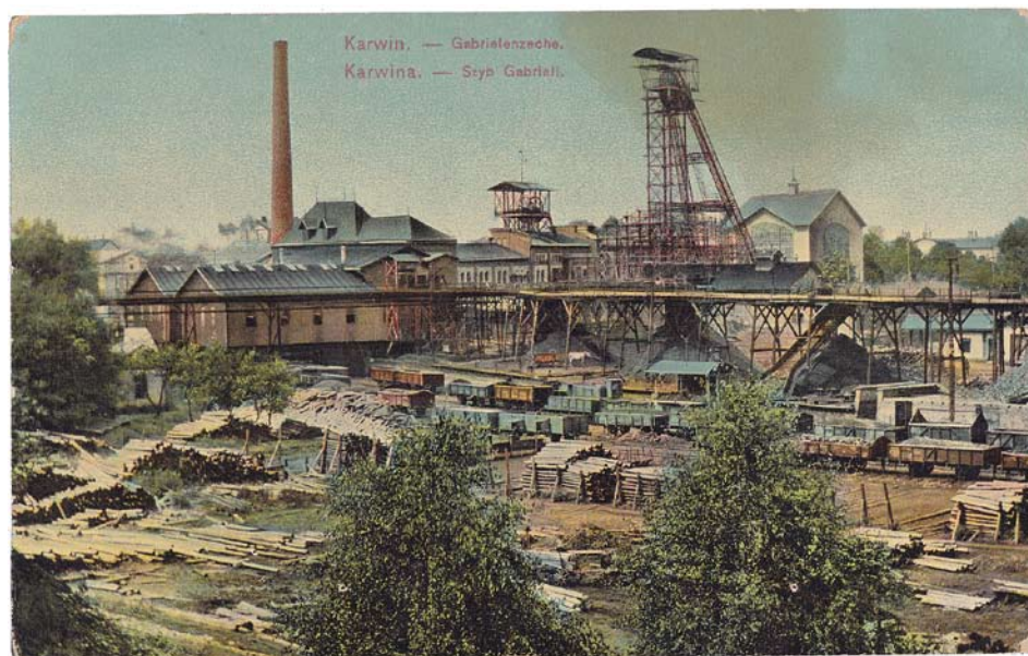
Obr. 10. Důl Gabriela, výstavba vzpěrové těžní věže a jámové budovy č. II, za ní se nachází již dokončená první fáze výstavby společné strojovny (pro těžní stroj jámy č. II), 1911, dobová pohlednice (Muzeum Těšínska, Sběrka pohlednic, H 34701).
