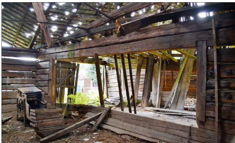
Obr. 16: Dobřív čp. 16, roubená stodola, stav po propadnutí střechy a destrukci krovu. Pohled severovýchodním směrem ze západní perny přes mlat do perny ležící na východě (foto K. Fouď, 2018).
