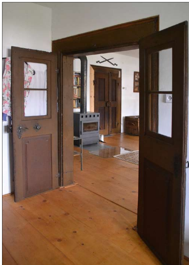
Obr. 7: Dobřív čp. 5, obytné stavení, vstup z přední světnice do přístěnku, rámové dveře s podříznutými křídly a kovářím barokního typu (foto S. Plešmíd, 2019).
