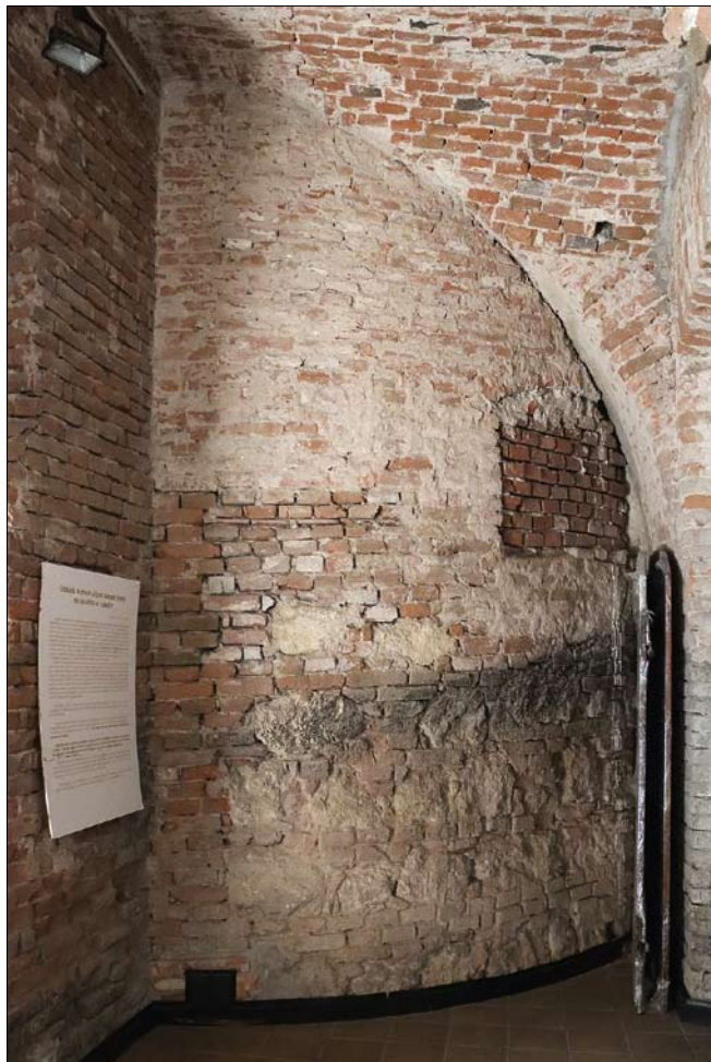
Obr. 3: Vnější zeď kaple, zde je patrné vezdění vnější severovýchodní obiloukové stěny do staršího prostoru (všechny snímky D. Chadim, není-li uvedeno jinak).
