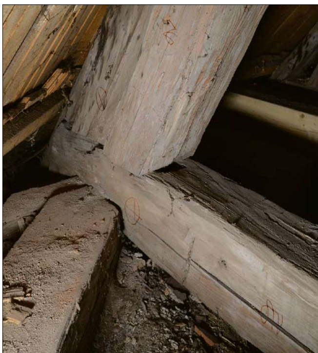
Obr. 9: Miličín, kostel Narození Panny Marie, krov nad presbytářem, pohled od jihu na sloupek druhotně redukované plné vazby č. 10. Patrné je zkrácení příčné rozpěry ležaté stolice a prvky zvalbení nad závěrem. Zřetelné jsou nepřesnosti ve spojích patních vzpěr s nárožními krokvi.
