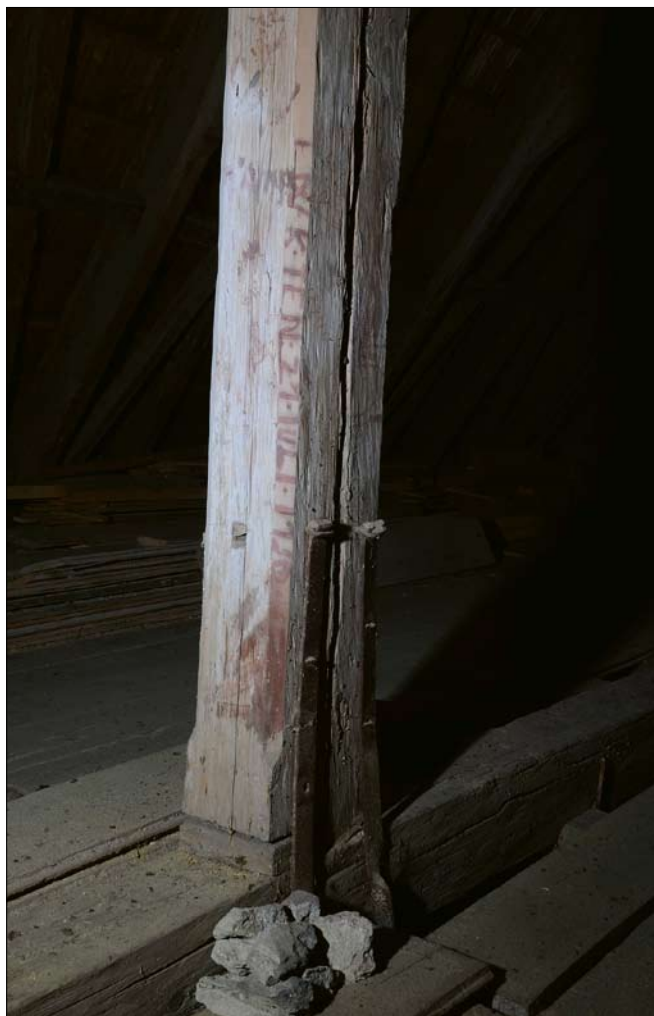
Obr. 18: Miličín, kostel Narození Panny Marie, krov nad lodí, detail věšadla plné vazby č. 13 s datovacím nápisem z roku 1750.
