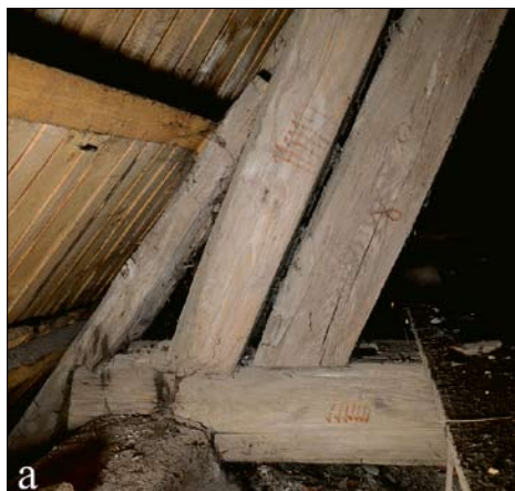
Obr. 6: Miličín, kostel Narození Panny Marie, krov nad presbytářem, detaily pat plných vazeb; a – jižní pata vazby č. 7 se zvláštní úpravou zhlaví vazného trámu pro zadrápnutí krátčete; sloupek plné vazby nese piktogram podobající se řeckému písmenu gama; b – severní strana vazby č. 4, sloupek nese římskou číslici II.
