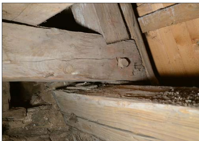
Obr. 12: Miličín, kostel Narození Panny Marie, krov nad presbytářem, detail severního konce prvního hambalku na styku s krokvi. Patrné je jak tesařské značení rudkou, tak tři závrtky od nebozezu s plochým břítem, dokládající, že první vazba sloužila též jako vzorová vazba pro výrobu vazeb následujících.
