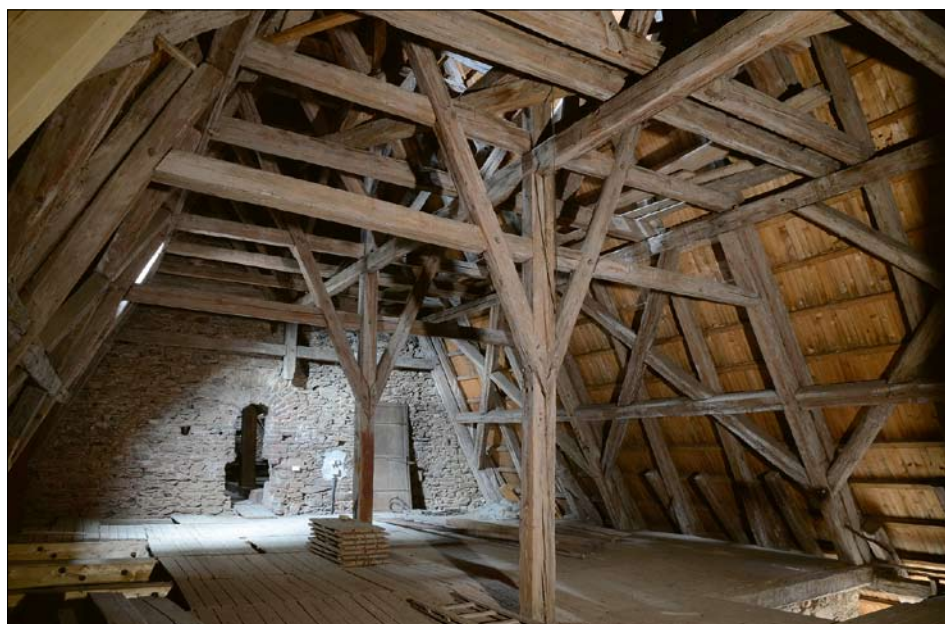
Obr. 3: Miličín, kostel Narození Panny Marie, krov nad presbytářem, celkový pohled od jihovýchodu (všechny snímky J. Veselý, 2023, není-li uvedeno jinak).
