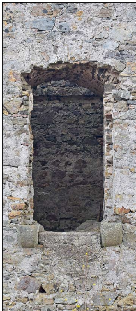
Obr. 9: Cornštejn, předsunutá fortifikace hradu. Vstup na severozápadní straně věže.
