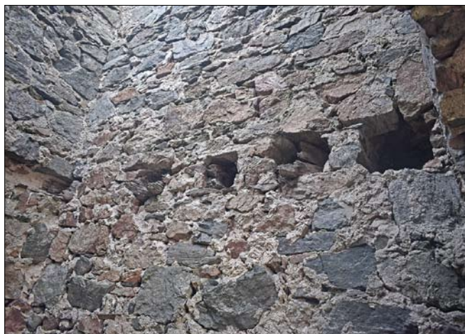
Obr. 12: Cornštejn, předsunutá fortifikace hradu. Jihozápadní stěna věže s kapsami trámů stropu prvního patra.
