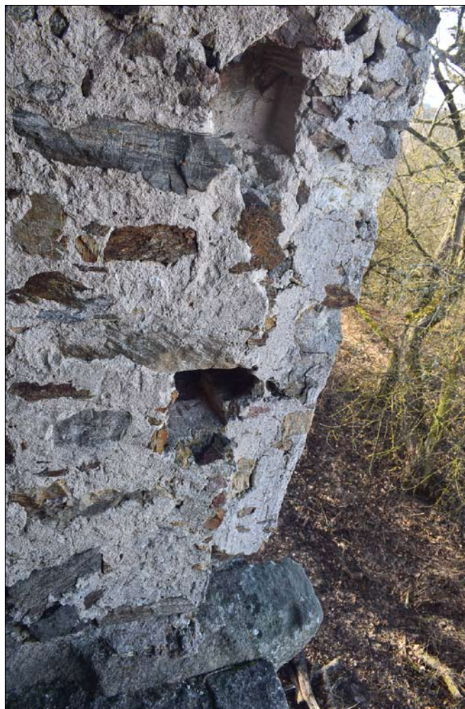
Obr. 10: Cornštejn, předsunutá fortifikace hradu. Vstup do věže, negativ zárubně s dvojicí kapes po závorách.
