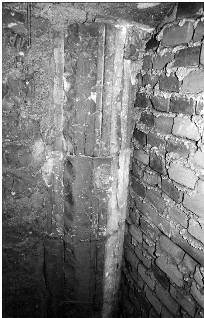
Obr. 38: Žatec, kostel Nanebevzetí P. Marie. Detail levé (západní) části okenního ostění výše zmíněného okna, které bylo druhotně využito pro vstup do patra zvonice. V levé části snímku lomové pozdně středověké zdivo západní stěny „chodbičky“, ukončené ostěním okna, vpravo novodobá zazdívká z konce 19. století, kdy byla odstraněna kruchta v jižní boční lodi.
