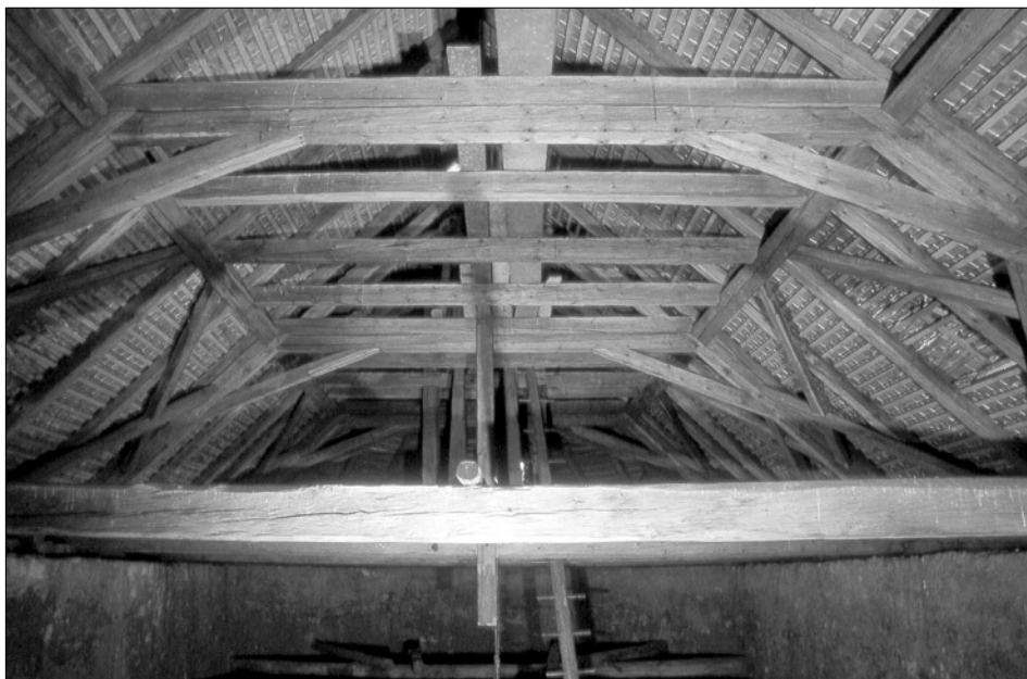
Obr. 43: Žatec, kostel Nanebevzetí P. Marie. Pozdně klasicistní krov hambalkové konstrukce s ležatými stolicemi v polygonálním závěru presbyteria. Krov plynule probíhá nad střední lodí až k pozdně barokním věžím západního průčelí. Dendrochronologicky byl datován do roku 1837 (doklad naskladnění dřeva asi ve formě polotovaru velkého objemu, neboť požár zničil střechu kostela až v roce 1840 – jistě zde šlo o „pojišťovací podvod“).
