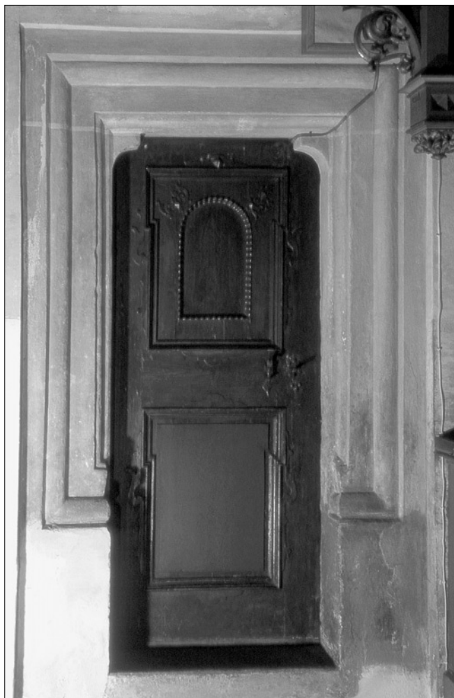
Obr. 35: Žatec, kostel Nanebevzetí P. Marie. Pozdně gotický portál ve východní části jižní stěny lodi. Zpřístupňuje přízemí jižní zvonice. Původně se zde nacházely železné plátované dveře, dnes osazené v severní věži západního průčelí (srov. obr. 39). Stávající dveře raně barokní ze 2. poloviny 17. století, rámové konstrukce.
