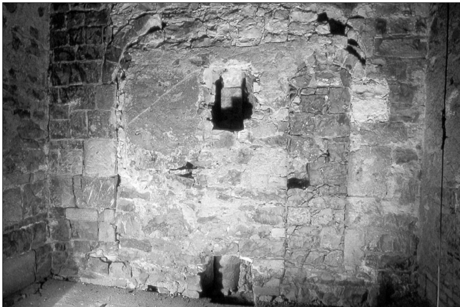
Obr. 40: Žatec, kostel Nanebevzetí P. Marie. Zazděné sdružené románské okno ve východní stěně jižní věže západního průčelí v úrovni 4. patra. Fragment okna, zazděného při přístavbě síňového trojlodí. Na černobílém snímku příliš nevynikne efektní barevný kontrast, který vzniká prostřídáním bloků původně žluté opuky a červeného pískovce dvojího druhu (viz příslušná část textu a obr. 46). Zdivo nad oknem je gotické.
