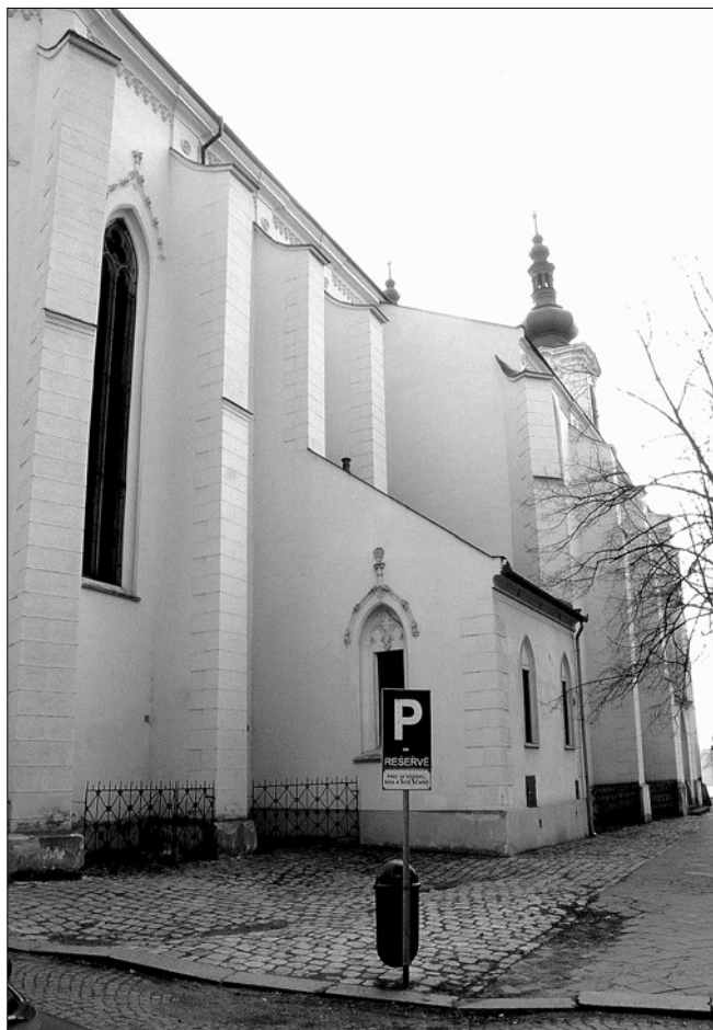
Obr. 17: Žatec, kostel Nanebevzetí P. Marie. Šikmý pohled od východu na severní stěnu presbytáře s přilehlou sakristií. Sakristie je přiložena k opěrákům presbyteria i diagonálnímu opěráku severní boční lodi, přičemž pohltila nízký okosený sokl, obíhající po obvodu presbytář s opěráky. Okno v čelní stěně je gotické, pouze s vnější historizující štukovou úpravou. Původní hrotitý záklenek vnitřního světlého otvoru byl vezdívkou upraven do obdélného tvaru (asi v barokním období).
