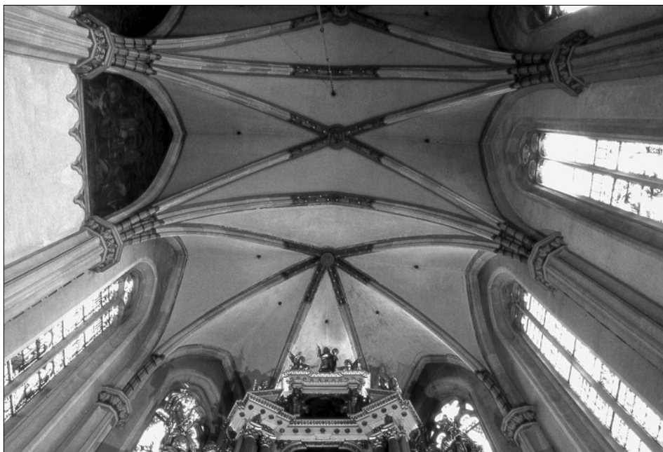
Obr. 24: Žatec, kostel Nanebevzetí P. Marie. Pohled do šestidílné klenby závěru presbytáře. Svazkové přípo-ry jsou v patě klenby oddělené novodobými sádrovými hlavicemi polygonálního tvaru. Příložka přípor obíhá klenební čela jednotlivých polí klenby. Presbytář je zaklenut trojicí nestejně širokých obdélných polí křížové žebrové klenby. Průřez žebry po novodobé úpravě převrstvení štukem má vejčitý tvar, jejich autentickou profilaci však torčí stíhlý hruškovce (ověřeno sondáží v místech s narušenou omítkou nad patou výběhu klenby v závěru presbyteria).
