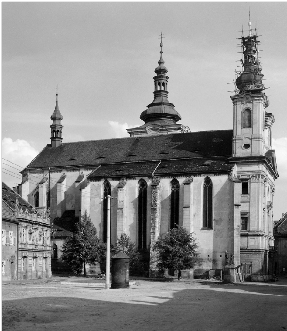
Obr. 18: Žatec, kostel Nanebevzetí P. Marie. Pohled na kostel od severu. Snímek V. Hyhlíka z roku 1961 (NPÚ – ústřední pracoviště, sbírka fotodokumentace, Žatec, inv.č. 92.073). Na snímku je v místech s opadanou omítkou patrné armování nároží opěráků lodí kamennými kvádry.
