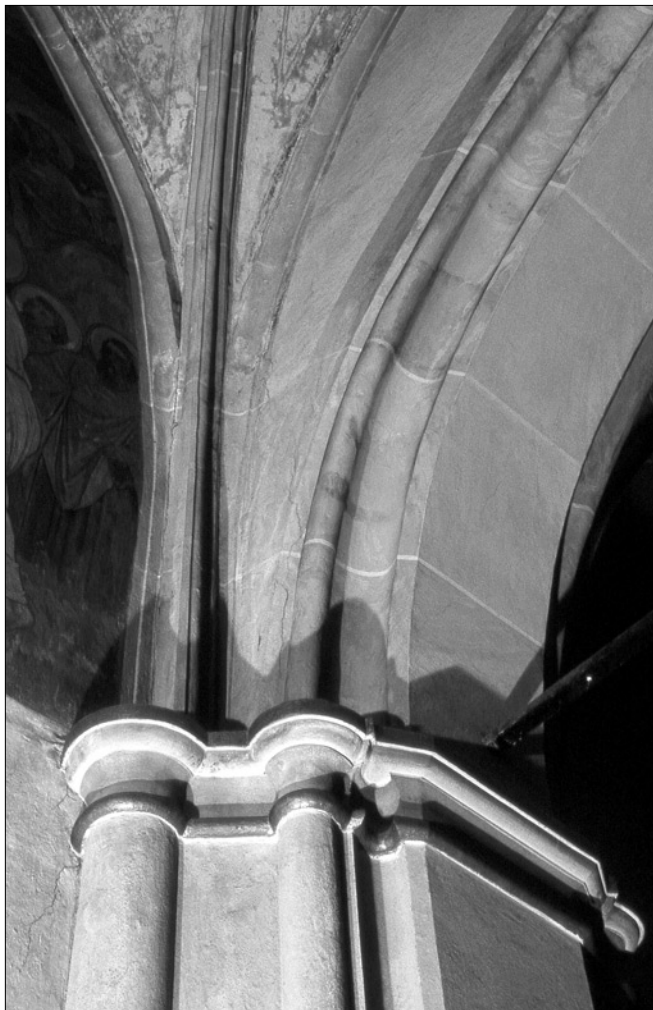
Obr. 30: Žatec, kostel Nanebevzetí P. Marie. Detail zakončení polopilíře, jižní mezilodní arkády při západní stěně lodi v úrovni novodobé kruchty (jižní románská věž západního průčelí). Profilace je autentická, pouze jemně přestukovaná.
