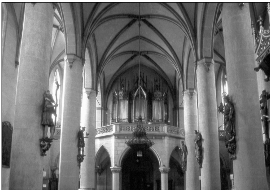
Obr. 29: Žatec, kostel Nanebevzetí P. Marie. Pohled do lodi západním směrem od vítězného oblouku. V čele novodobá zděná kruchta, přiložená k románskému západnímu dvouvěžovému průčelí. Střední loď je přesně dvakrát širší než loď boční, což spolu s mohutností válcových podpor do jisté míry potlačuje prostorovou celistvost síňové dispozice a při pohledu opačným směrem akcentuje podélnou osu kostela (srov. obr. 22).
