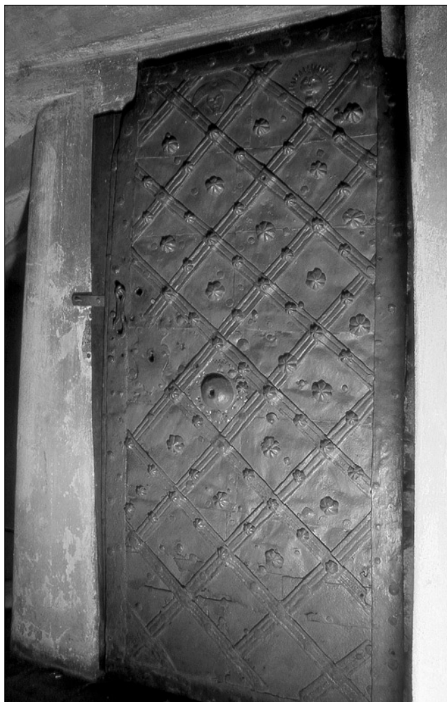
Obr. 39: Žatec, kostel Nanebevzetí P. Marie. Železné plátované dveře, původně osazené v portálu vstupu do přízemí jižní zvonice, dnes na horním konci novodobého schodiště v severní věži západního průčelí, v úrovni kruchty. Vedle řemeslného provedení dveří a pozůstatku nekrytého zámku lichoběžného tvaru na rubové straně stojí za pozornost zejména z plechu vystříhané motivy slunce a měsíce na lící straně dveří (husitský motiv, patrně lze klást do souvislosti s existencí literátské tribuny v jižní boční lodi).
