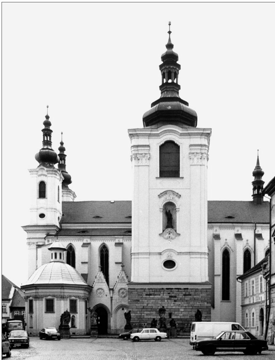
Obr. 4: Žatec, kostel Nanebevzetí P. Marie. Celkový pohled od jihu (foto V. Razín, 1995).
