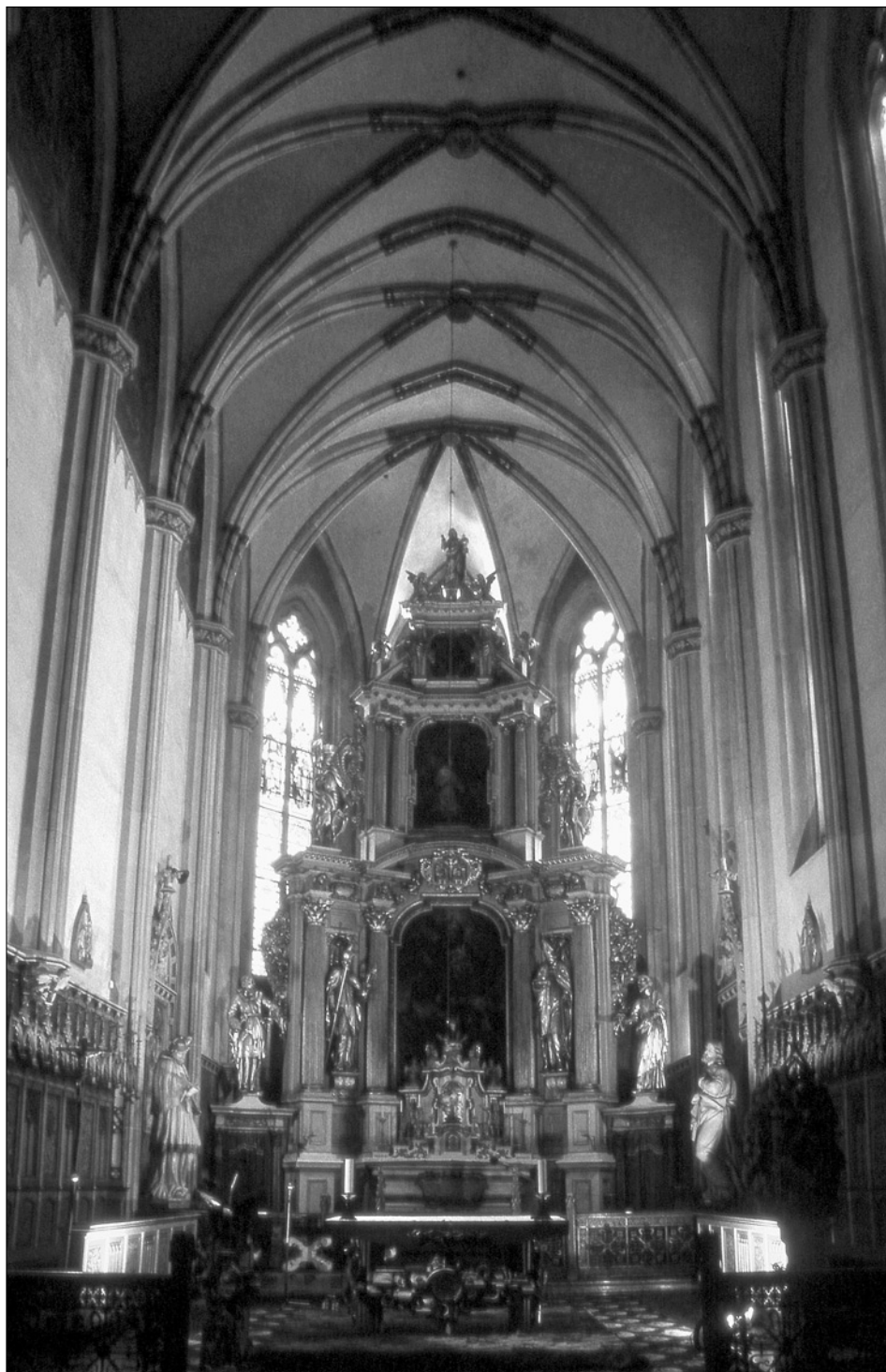
Obr. 23: Žatec, kostel Nanebevzetí P. Marie. Pohled do presbytáře kostela. Od jihu jej osvětlují 4 vysoká hrotitá okna s kružbami, v trojbokém závěru trojice oken, od severu pak jediné. Stěny presbytáře člení svazkové přípory tvořené trojicí hruškovců s příložkou, která je na hraně vyžlabena. Přípory sbíhají až k podlaze, kde jsou ukončeny nízkými odsazenými sokly shodné profilace. Přípory jsou přeštukovány silnou vrstvou omítky, která do značné míry deformuje jejich původní tvar (hruškovce jsou v současnosti silně zploštělé). Nad podlahou je tato vrstva narušena a je obnažen původní materiál přípor, asi opuka nebo jemnozrnný pískovec (petrografický rozbor nebyl dosud proveden).
