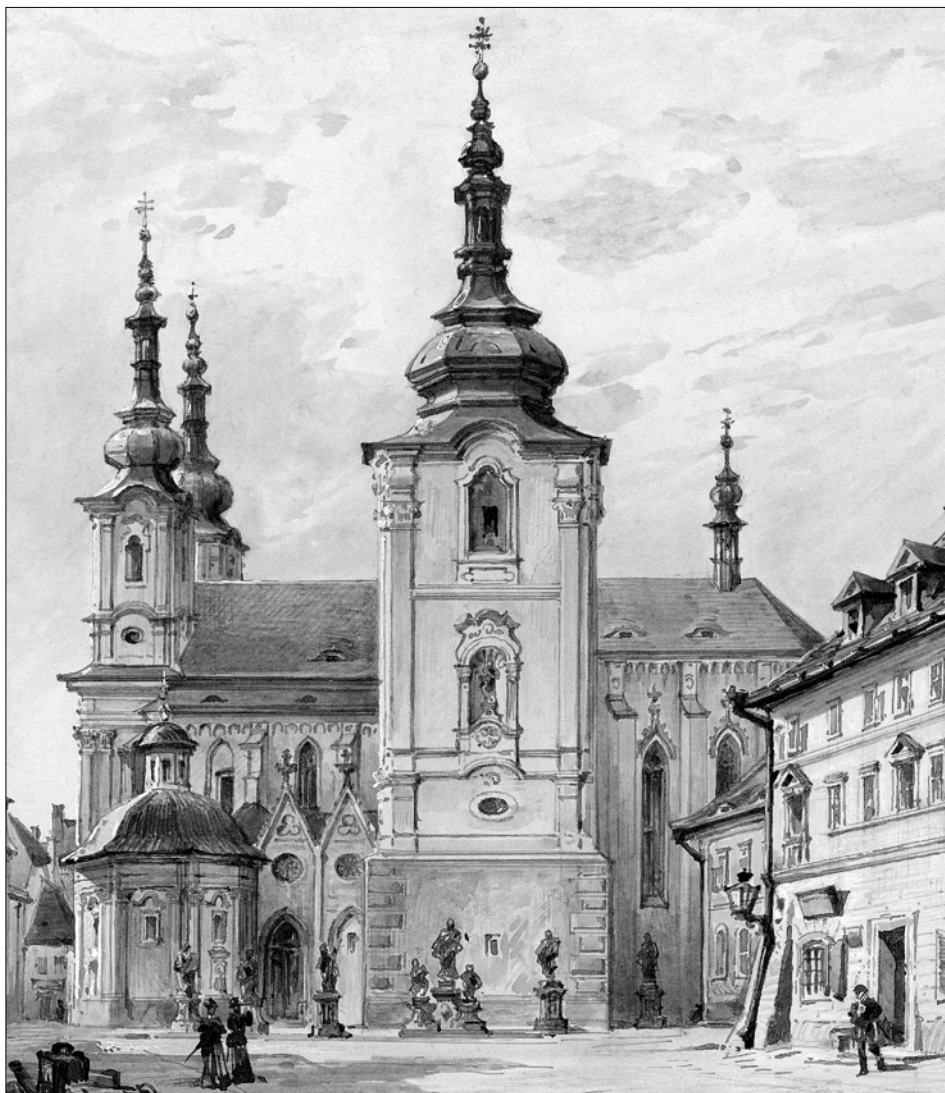
Obr. 11: Žatec, kostel Nanebevzetí P. Marie. Pohled na kostel od jihu, A. Liebscher, který zachytil podobu kostela někdy na konci 19. století, avšak ještě před dokončením regotizace vnitřku a vnějšku. Jižní vstupní předstíh má již historizující podobu, odlišnou od oné, kterou na svém snímku zachytil C. L. Koch (srov. obr. 10). Nižší západní okno lodi je dosud zakončeno segmentovým záklenkem a parter jižní zvonice má barokní členění. Západní okno bylo upraveno v souvislosti s vestavbou zděné kruchty k západní stěně lodi, barokní plenta spodních dvou podlaží zvonice byla odstraněna až na kvádrový pozdně středověký obklad (Regionální muzeum Žatec).
