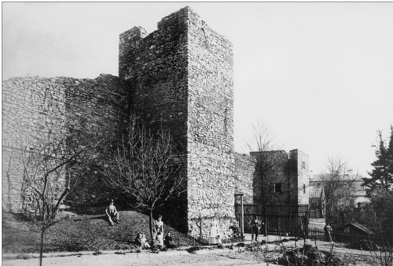
Obr. 26: Tachov, věž č. 4, pohled od severozápadu. Věž a vlevo navazující kurtina dochovány takřka v původní výšce. V hlavním průčelí věže v 1. patře klíčová střílna s rozšířenou dolní částí. Zahradky v popředí byly zřízeny na místě zasypaného příkopu. V pozadí věž č. 3 přestavěná na obytný dům, zcela vzhledu zámek. Snímek kolem roku 1900 (Muzeum Českého lesa Tachov).
