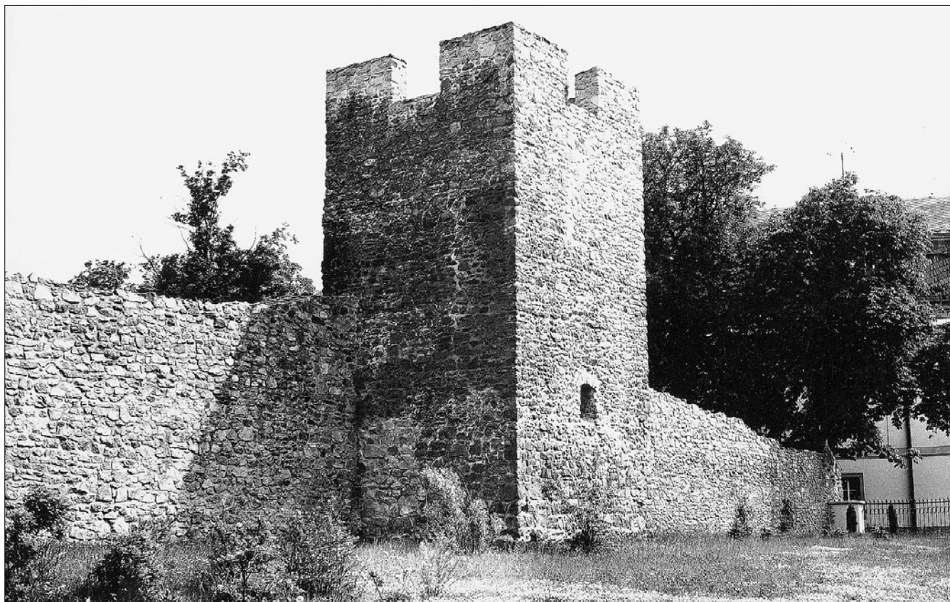
Obr. 23: Tachov, věž č. 1, pohled od severozápadu, z prostoru zasypaného městského příkopu. Původní stav věže po dílčí rekonstrukci, s dodatečným okénkem v hlavním průčelí. Vlevo rekonstruovaná kurtina městského opevnění, vpravo zeď, která přepažovala dnes zaniklý příkop oddělující hrad – zámek (vpravo v pozadí) od města (snímek z roku 1996, V. Razím).
