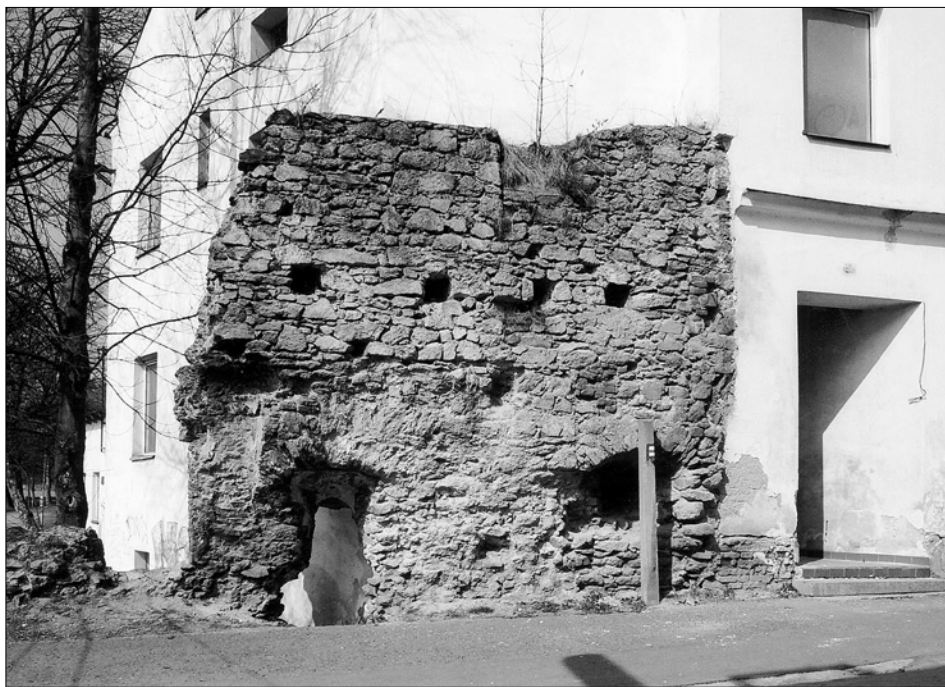
Obr. 52: Tachov, dochovaná část západní boční zdi předbrani Rýšské brány, pohled od jihovýchodu. V přízemí dvě střilny, nad otvory stropních trámů spodní část výklenku střilny 1. patra (snímek z roku 2000, V. Razím).
