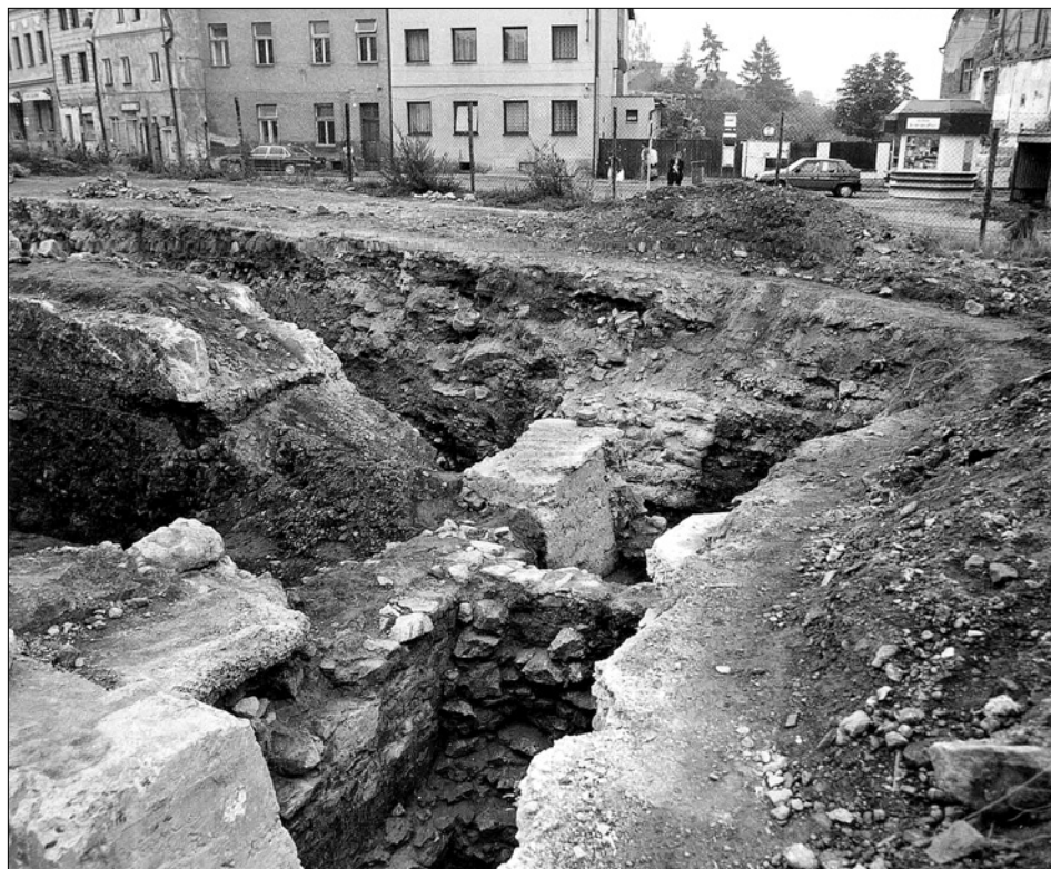
Obr. 13: Tachov, ppč. 379, pohled od západu na východní část sondy I během výzkumu silně porušené hradební zdi (1992, foto E. Kamenická).
