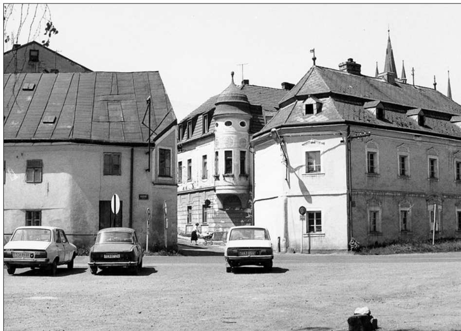
Obr. 51: Tachov, domy čp. 476 (vlevo) a 477 (vpravo) obsahují pozůstatky předsunuté (tedy třetí) Dolní brány. Na osvětlené části fasády čp. 477 zbytek stojiny portálu brány (snímek z roku 1987, V. Razím).
