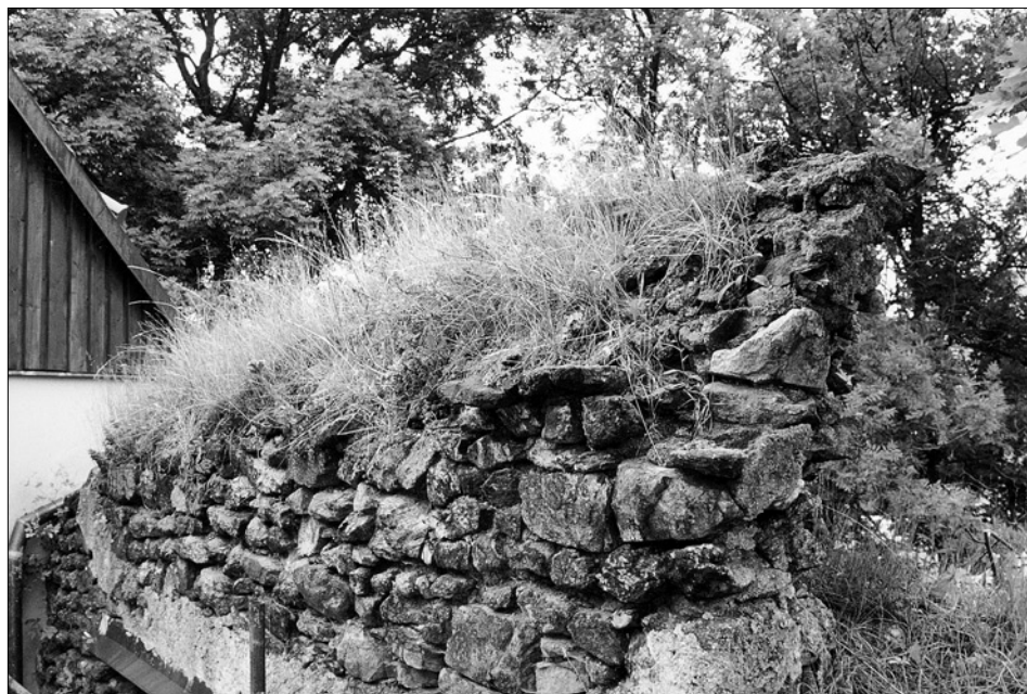
Obr. 40: Tachov, detail původní koruny kurtiny ve východním sousedství věže č. 24, pohled z městské strany. Horní část kurtiny se i po snížení věže dochovala díky tomu, že byla od věže oddělena konstrukční spárou. Původní povrch pultové stříšky, skloněné směrem do města, zanikl. Na předělu mezi stříškou a svislým lícem kurtiny předstupuje fragment původní okapní římsy, tvořené plochými lomovými kameny – uprostřed snímku (snímek z roku 2000, V. Razím).
