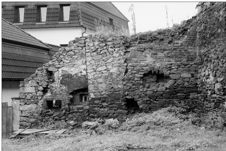
Obr. 48: Tachov, zbytek věže č. 19 (uprostřed), s navazující kurtinou (vpravo) a dodatečně přiloženou boční zdí předpokládané bašty (vlevo). V této zdi jsou dole prolomeny dodatečné otvory, nad nimi původní střílna. Pohled od severovýchodu (snímek z roku 2004, V. Razím).
