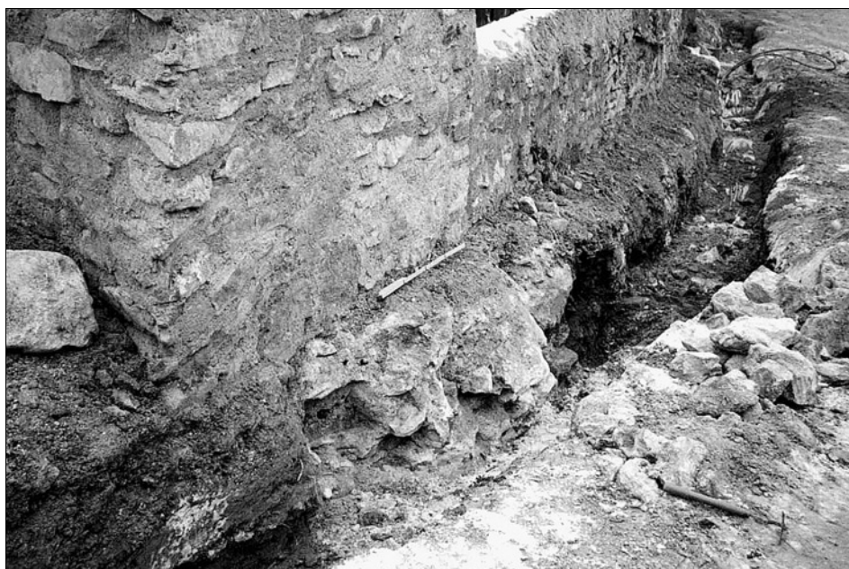
Obr. 10: Tachov, Hradební ul., pozůstatek hradby v kabelové rýze od severozápadu (foto K. Nováček).
