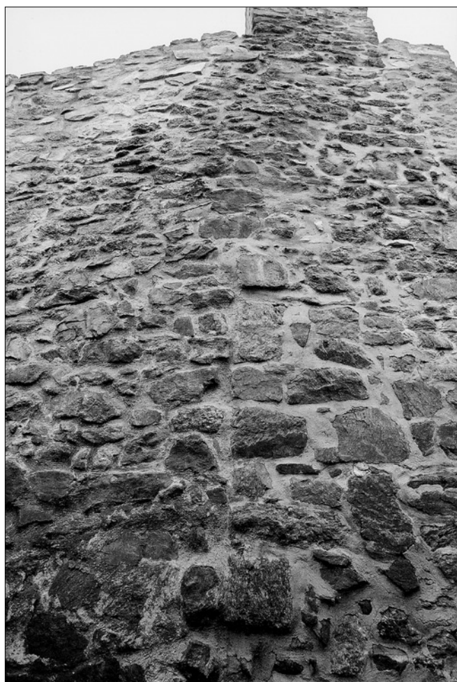
Obr. 25: Tachov, detail vztahu věže č. 1 (vpravo) ke zdi, která přepažovala dnes zasypaný příkop mezi městem a hradem (vlevo). Věž od zdi odděluje svíslá spára, teprve v horní části je zdivo provázáno, nejspíše druhotně (snímek z roku 2004, V. Razím).
