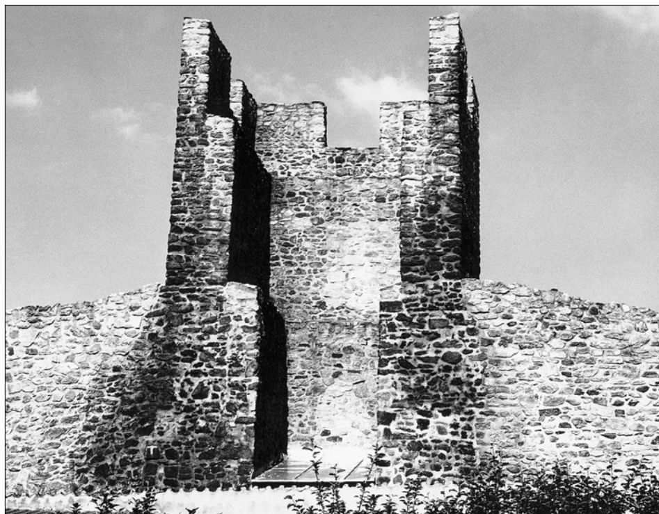
Obr. 24: Tachov, věž č. 1, pohled z městské strany. Původní stav věže po dílčí rekonstrukci (snímek z roku 1987, V. Razím).
