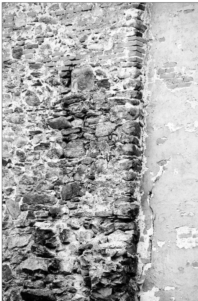
Obr. 39: Tachov, věž č. 23, detail návaznosti horní části kurtiny na východním průčelí. Dole část kurtiny ve zdivu provázaná s věží, výše část kurtiny přiložená k věži na spáru. Stopy pultové korunní stříšky zanikly při přestavbě věže na obytný dům – zcela nahore (snímek z roku 2004, V. Razím).
