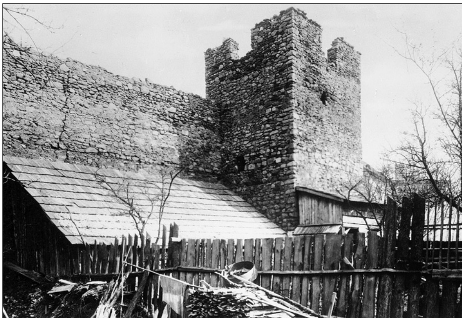
Obr. 33: Tachov, věž č. 21, pohled od jihozápadu. Dnes již zaniklá věž a navazující kurtina směrem k věži č. 22 byly dochovány v původní výšce. V úrovni 1. patra na boční straně a patrně také ve 2. patře na čelní straně stopy po druhotných střílnách. Snímek kolem roku 1900 (Muzeum Českého lesa Tachov).
