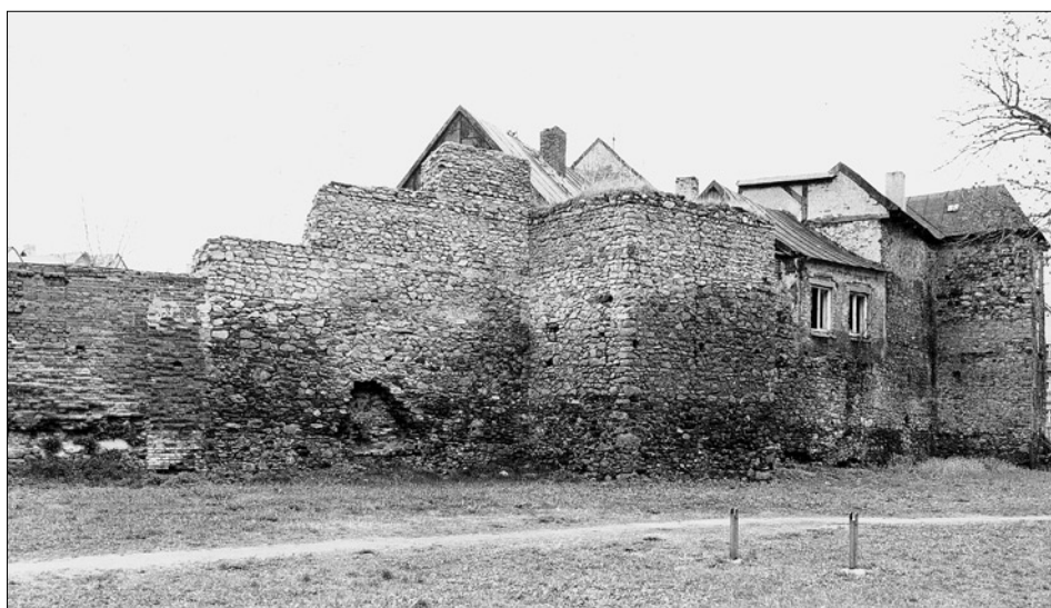
Obr. 36: Tachov, úsek jižní části městského opevnění, pohled od jihozápadu. Uprostřed věž č. 24, se stopami dodatečně střílny v bočním průčelí. Horní část kurtiny na levé straně byla k věži připojena na spáru. Vpravo v pozadí věž č. 23 (snímek z roku 1996, V. Razím).
