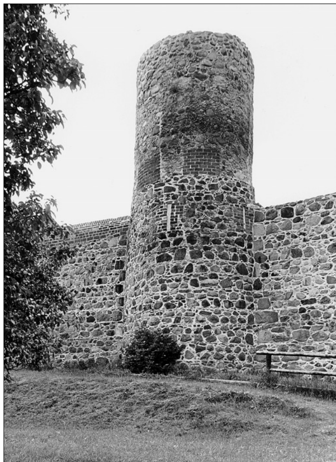
Obr. 53: Templin (Braniborsko). Ukázka vnější strany mělké segmentové věže, která byla součástí hradebního systému stejného typu jako v Tachově (vlevo opravená část původní koruny kurtiny). Věž byla v 1. patře vybavena třemi původními šterbinovými střelnami, nad nimi předprsní zídka s cihelným cimbuřím (dochovalo se v dodatečné nástavbě věže). Kolem roku 1300 (snímek z roku 1996, V. Razím).
