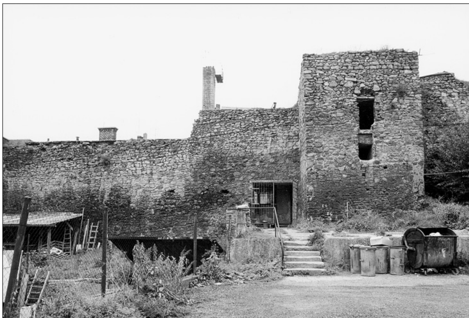
Obr. 32: Tachov, věž č. 17 (dochována do úrovně neúplného 2. patra) s navazujícími kurtinami, pohled od východu. Na levé kurtině a na hlavním průčelí věže jsou dobře patrné vrstvy zdiva, probíhající šikmo v souladu s původní úrovní terénu. V horní části věže tyto vrstvy přecházejí do vodorovného směru (snímek z roku 2000, V. Razím).
