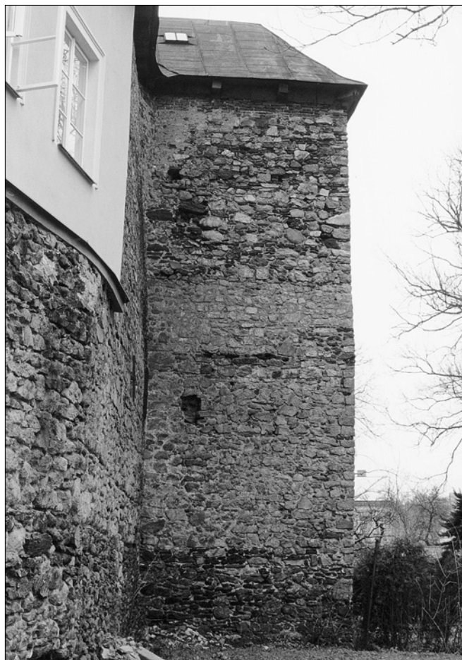
Obr. 35: Tachov, západní boční průčelí věže č. 23. Dobře je patrný kónický tvar horní části věže i kurtiny v popředí (snímek z roku 2000, V. Razím).
