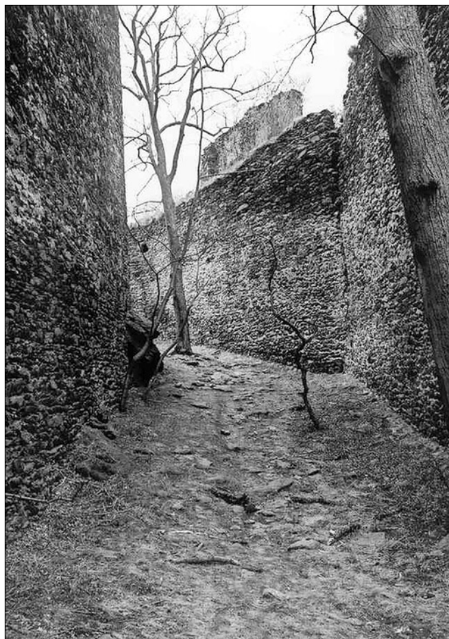
Obr. 13: Nový Hrádek, „Starý hrad“, severozápadní úsek parkánu.
