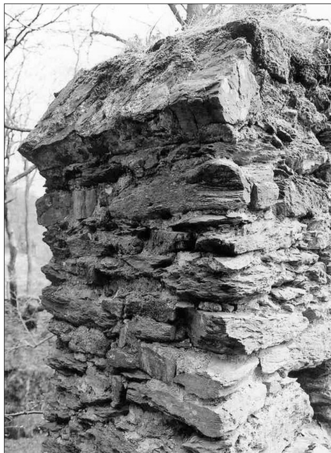
Obr. 28: Nový Hrádek, „Starý hrad“, čelní hradba, v nárožích stávajících ozubů poprsní zdi jsou pozůstatky někdejších záklenků.
