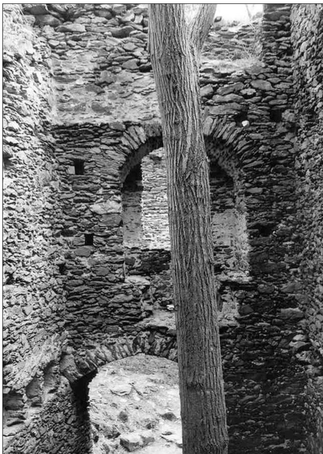
Obr. 21: Nový Hrádek, „Starý hrad“, interiér menšího traktu paláce, pohled na jižní stěnu, dole vstup, v patře okenní nika se sedilem.
