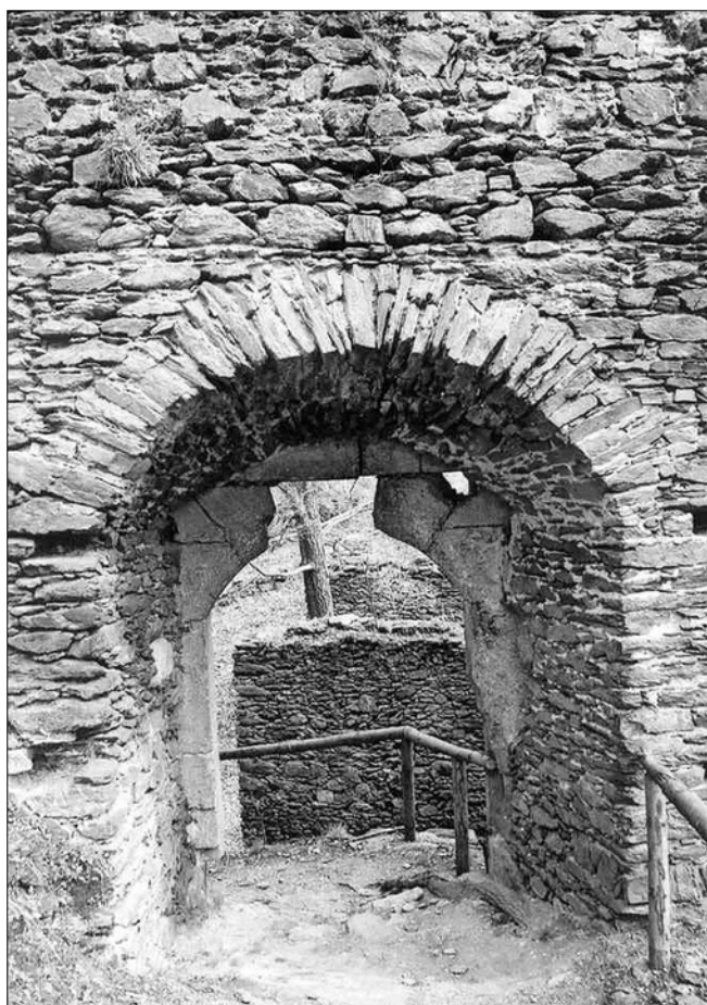
Obr. 26: Nový Hrádek, „Starý hrad“, vnitřní strana portálu čelní hradby.
