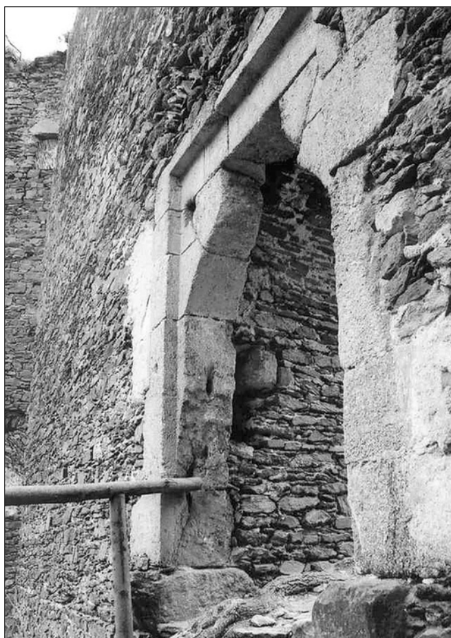
Obr. 25: Nový Hrádek, „Starý hrad“, vnější strana portálu čelní hradby (prostřední klenák oblouku chybí).
