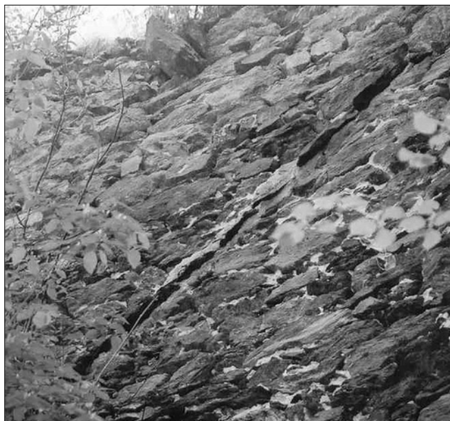
Obr. 23: Nový Hrádek, „Starý hrad“, otisk pultové střechy s kamennou krytinou nad západní vestavbou ve vnitřním oválu.
