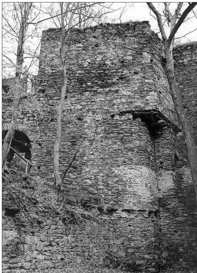
Obr. 30: Nový Hrádek, „Starý hrad“, čelní hradba pokračuje jižně od vstupního portálu ve výšce dovnitř otevřené hranolové věže.
