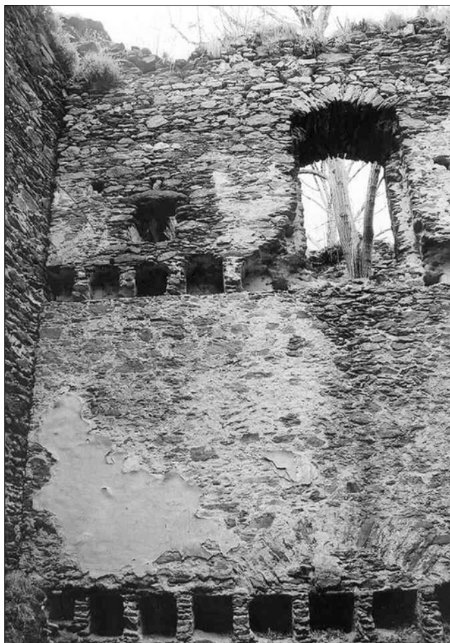
Obr. 20: Nový Hrádek, „Starý hrad“, interiér většího traktu paláce, stěna sousedící s menším traktem; spodní trámy nesly přízemí nad polozahlobeným sklepem, patro bylo nasazeno výše než v sousední místnosti menšího traktu; vlevo nahoře nad lůžky stropních trámů otvor z krbu v sousední místnosti a na stěně otisk (neomítnuté místo) někdejších kamen.
