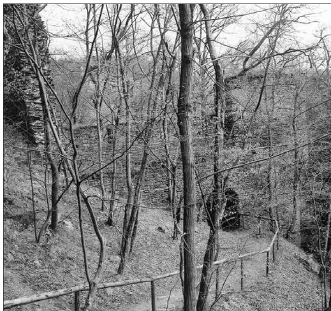
Obr. 24: Nový Hrádek, „Starý hrad“, pohled z nádvoří na jižním svahu na čelní hradbu s otevřenou hranolovou věží a patrovou budovou.
