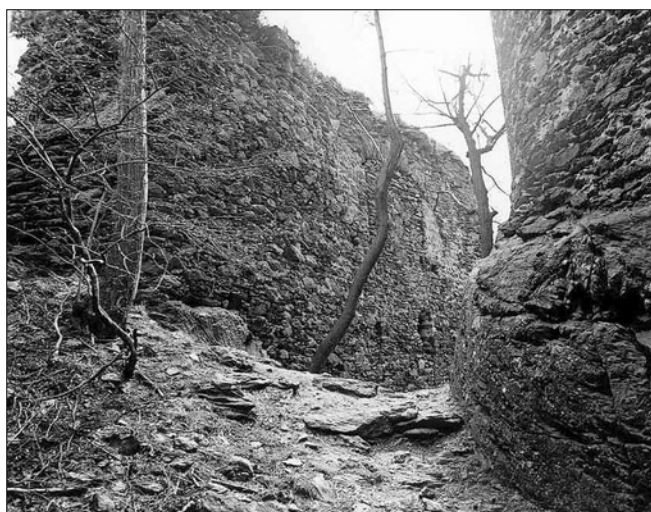
Obr. 8: Nový Hrádek, „Starý hrad“, severovýchodní úsek parkánu, ve vnější hradbě zazděný původní vstup.
