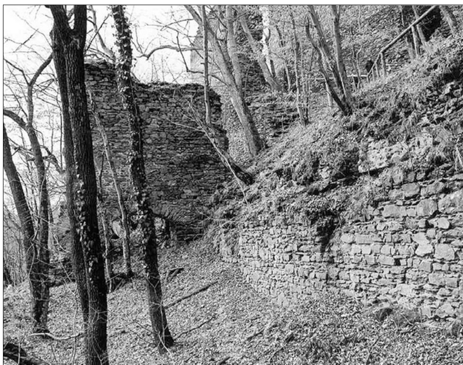
Obr. 32: Nový Hrádek, „Starý hrad“, interiér jižní budovy za dovnitř otevřenou hranolovou věží, přízemí bylo přístupno širokým vstupem v západní zdi (segmentově ukončená široká nika bez ostění) a přisvětleno malými světílkami v severní zdi (ve svahu).
