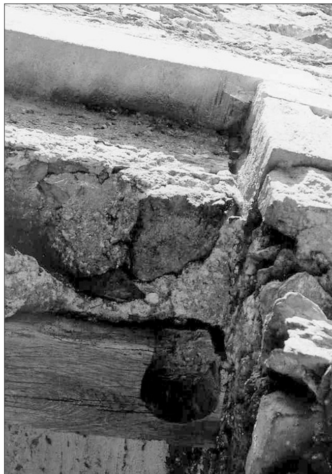
Obr. 16: Nový Hrádek, „Starý hrad“, detail nadpraží jižního, mladšího vstupu do vnitřního hradebního oválu, dubový trám na uchycení vrat dendrochronologicky určen do let 1424–26.
