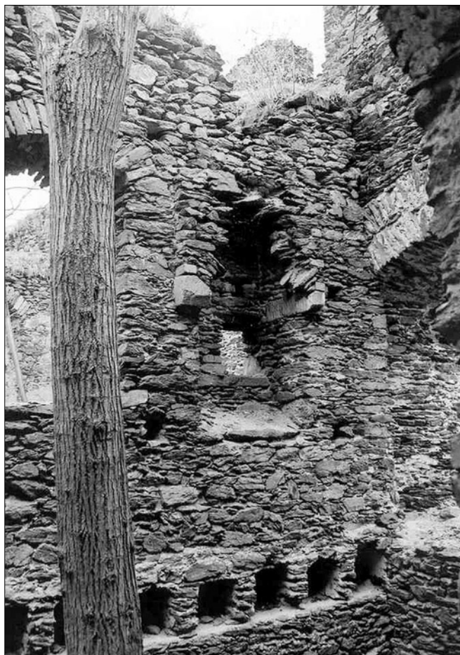
Obr. 19: Nový Hrádek, „Starý hrad“, interiér menšího traktu paláce, patro západní stěny; vlevo vstup do patra většího traktu, uprostřed krb (zvýšenou polohu vstupu a krbu si vynutila úroveň podlahy v patře většího traktu), upravo starší portál.
