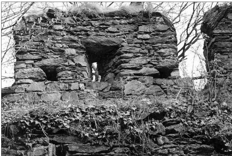
Obr. 27: Nový Hrádek, „Starý hrad“, ukončení čelní hradby ochozem a cimburím se střílnami.
