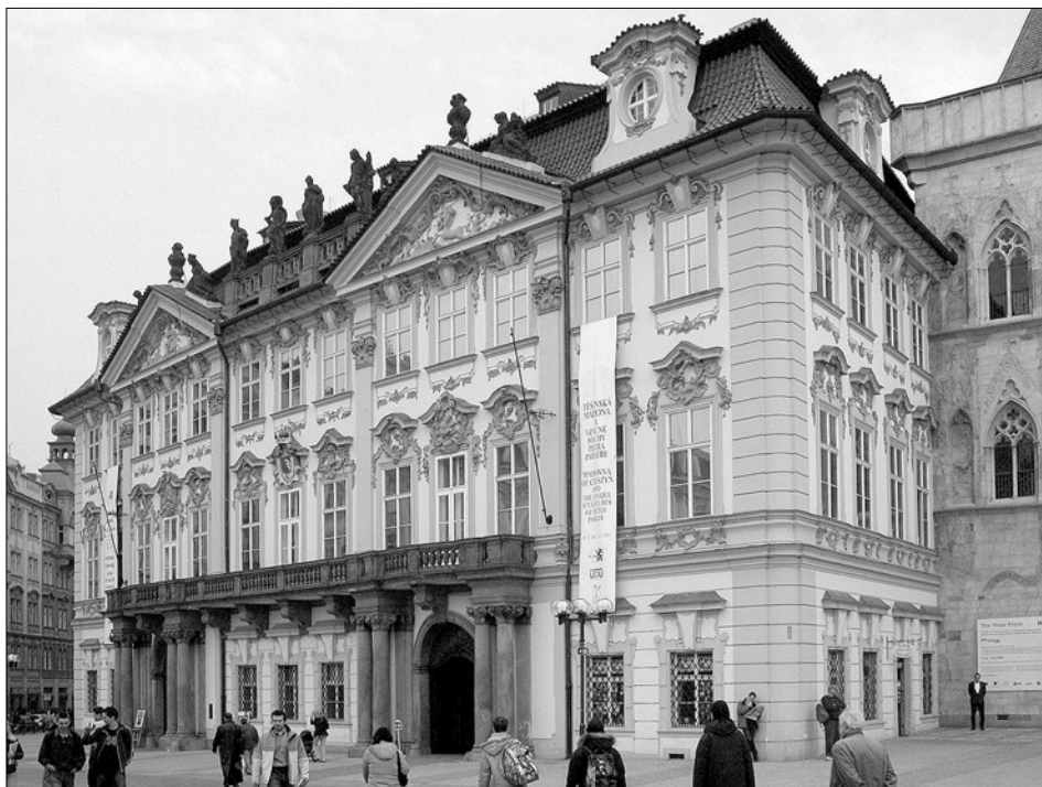
Obr. 38: Praha 1, Staré Město, palác Goltz-Kinských čp. 606-I; celkový pohled (foto autor).
