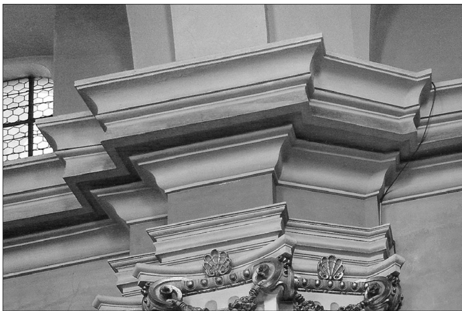
Obr. 13: Lysá nad Labem, kostel sv. Jana Křtitele; detail kladí pilíře lodi (foto autor).
