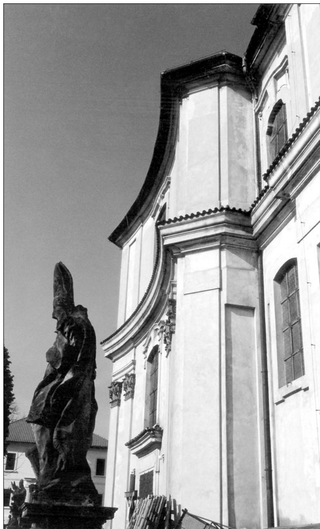
Obr. 14: Lysá nad Labem, kostel sv. Jana Křtitele; detail rizalitu jižního průčelí (foto autor).
