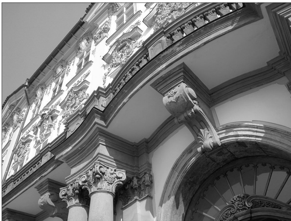
Obr. 39: Praha 1, Staré Město, palác Goltz-Kinských čp. 606-I; detail portálu (foto autor).
