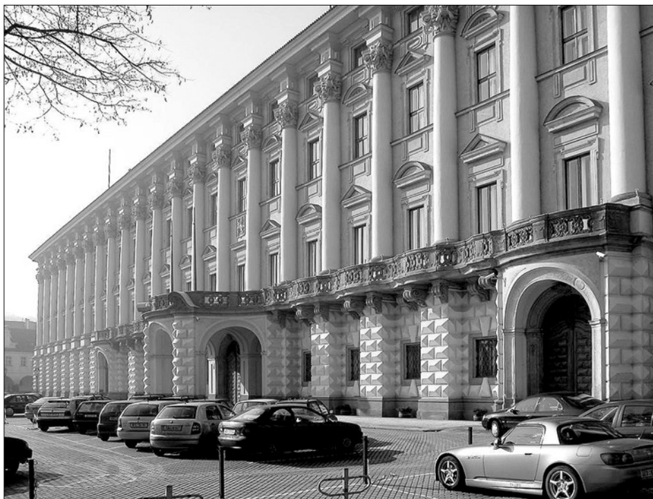
Obr. 21: Praha 1, Hradčany, Černínský palác čp. 101–IV; východní průčelí s portikem (foto autor).
