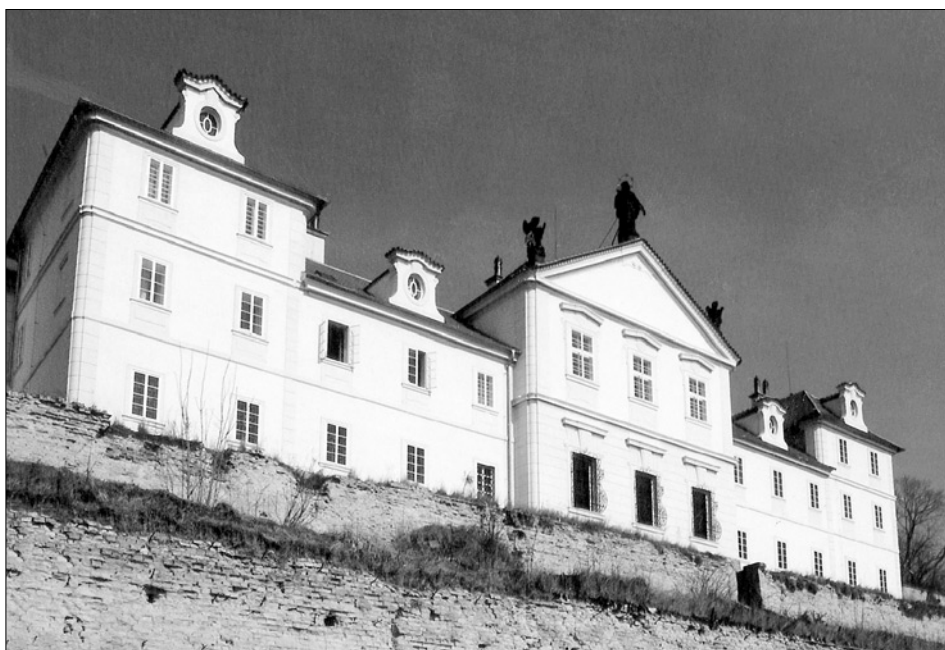
Obr. 9: Lysá nad Labem, klášter augustiniánů bosáků: západní průčelí konventu (foto autor).
