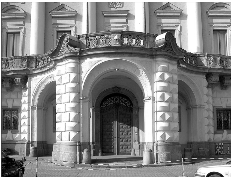
Obr. 22: Praha 1, Hradčany, Černínský palác čp. 101–IV; střední část vstupního portiku (foto autor).
