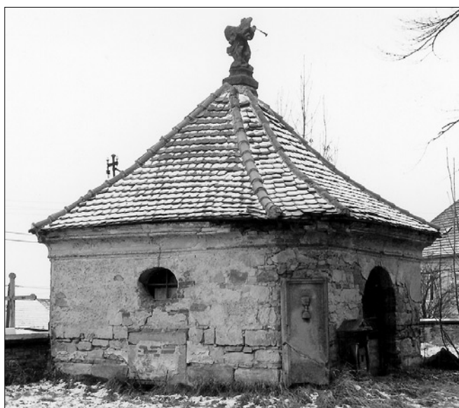
Obr. 30: Veliš, kostel sv. Václava; poutní kaple na terase před průčelím kostela se sochou anděla posledního soudu na špičce střechy (foto M. Mická).
