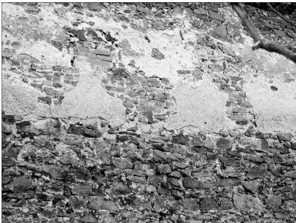
Obr. 16: Pardubice, zámek, valové opevnění, západní kurtina. Úsek zazděného cimbuří obvodní zdi na úpatí valu (foto J. Noll, 2003).
