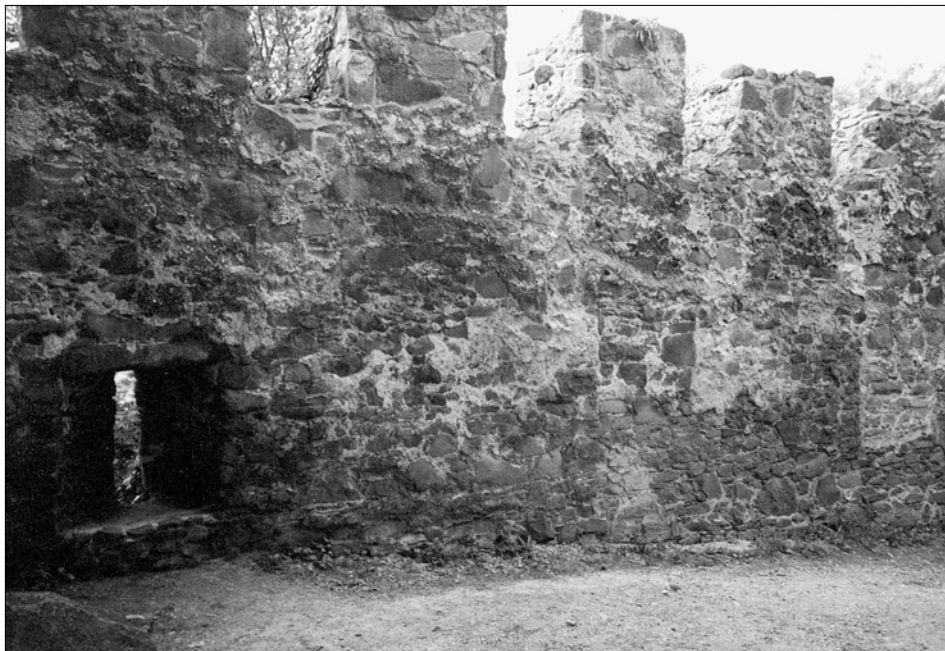
Obr. 11: Kunětická Hora, vnitřní líc hradby mezi 5. a 6. branou se starším zazděným cimbuřím (foto J. Noll, 2003).
