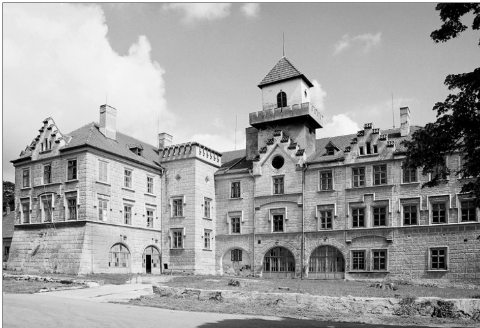
Obr. 3: Jirny, zámek, celkový pohled na zámeckou budovu od jihu. Nástavba věže je novodobá z období druhé světové války (všechny fotografie autor, 2003).
