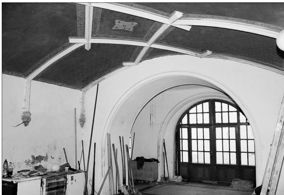
Obr.17: Jirny, zámek, bývalá kaple (č. 102) vzniklá snad na místě zrušeného průjezdu, pohled k východu.
