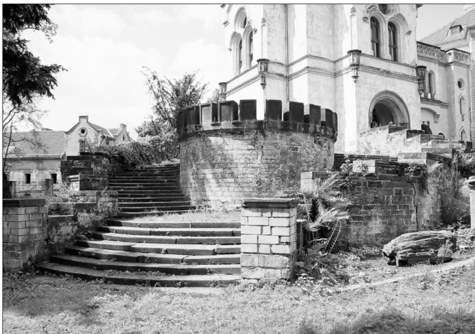
Obr. 37: Jirny, zámek, detail romantických teras před průčelím přístavby knihovny.
