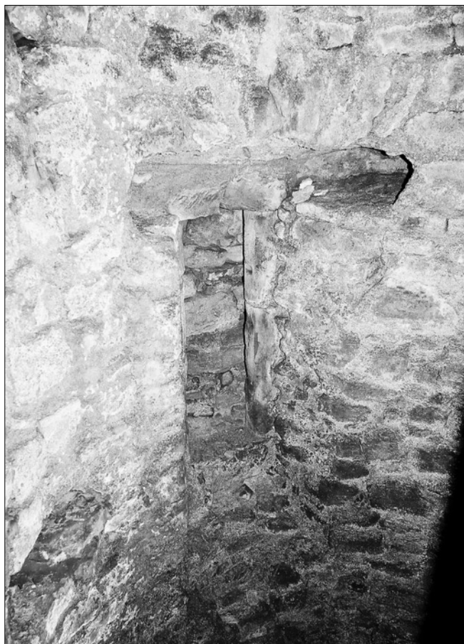
Obr. 23: Jirny, zámek, detail zazděného větracího okénka studny, opatřeného kamenným ostěním.
