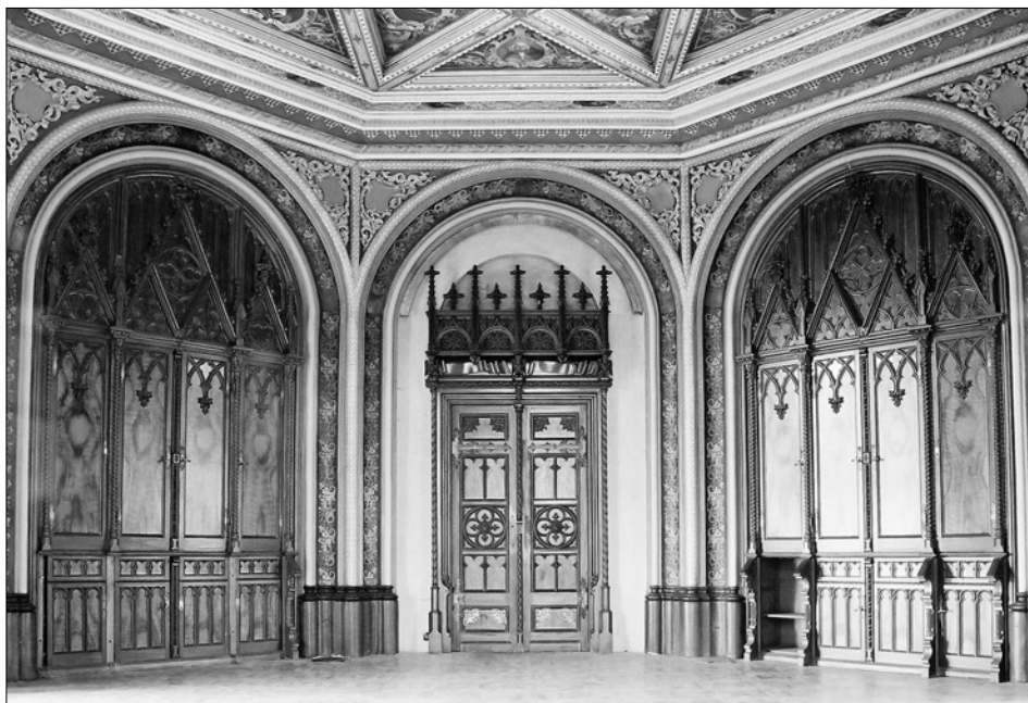
Obr. 38: Jirny (okres Praha – západ), zámek, knihovna (č. 221), celkový pohled na vstupní (severozápadní) stěnu.
