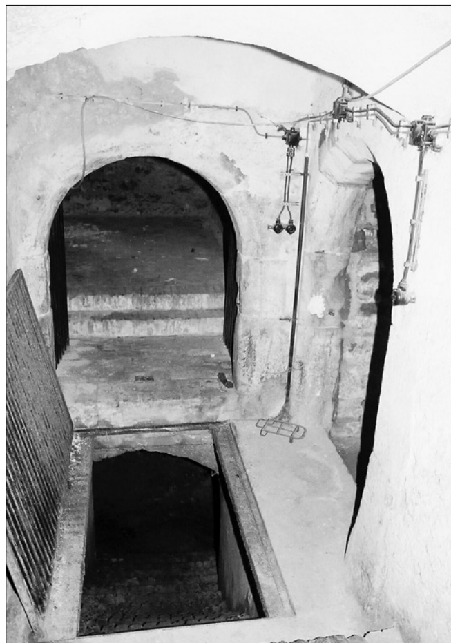
Obr. 19: Jirny, zámek, nástupní aparát sklepů v prvním suterénu. Nahoře dvojice gotických okosených portálků do sklepních místností č. 02 a 03, dole pokračování schodišťové špi do druhého podzemního podlaží.
