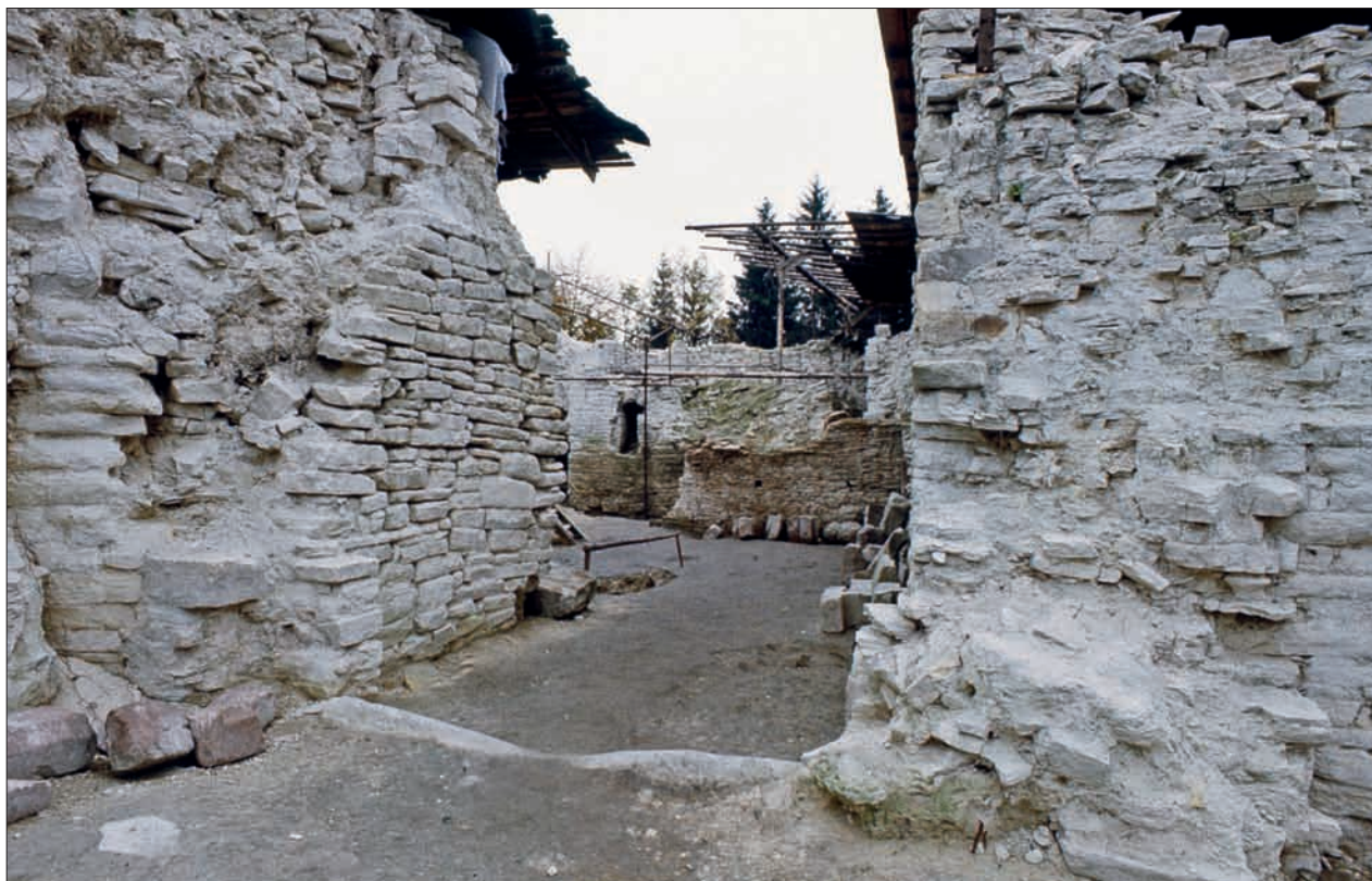
Obr. 189: Brána v pohledu z parkánu, směrem do nádvoří. Vlevo ještě intaktně dochovaná severní stěna brány, s reliktem ostění, jehož tesaná část však zanikla. Vpravo zbytky poměrně silné, s hradbou provázané zdi, jež vybíhala do popředí a v níž byla blíže neznámým způsobem osazena jižní stojka ostění. Dole se objevuje monolit prahu. Zcela vlevo zabíhá zkosený líc hradby pod dosud neodstraněnou stěnu sutě (snímek z archivu autora, asi 1978).
