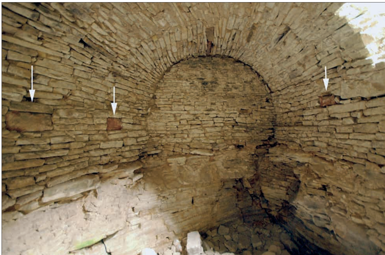
Obr. 72: Sklep pod jižní síní B, pohled k západu. Dole na obvodě vystupuje rostlá skála, do níž byl prostor velmi výrazně zahlouben. Šipky označují kvádry z červeného pískovce, patrně zbytky konzol, na něž bylo při stavbě založeno bednění valené klenby (snímek Václav Tutr, 2006).
