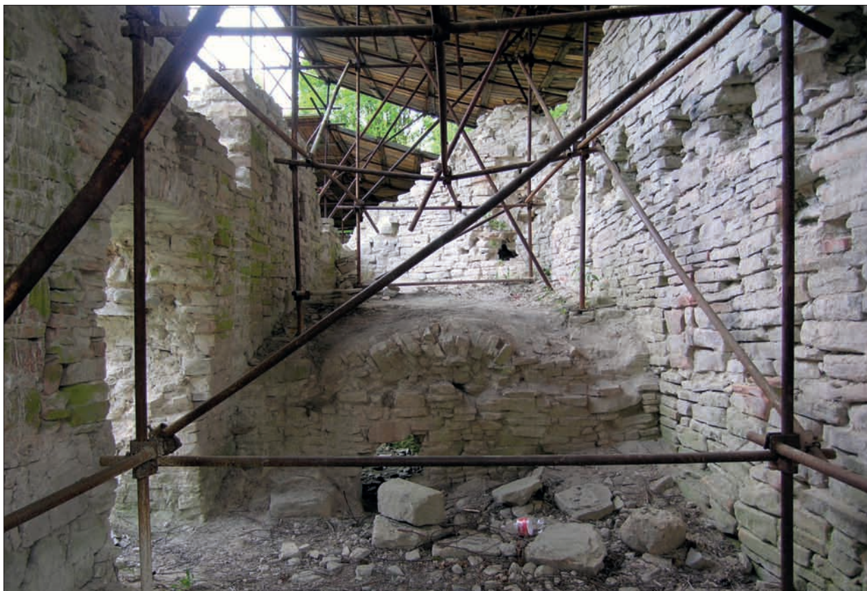
Obr. 159: Vnitřek západního křídla v pohledu k jihu. Uprostřed stěna a vrchol klenby druhotně vestavěného sklepa, vpravo otvory po stropních trámech, druhotně vložených do hrabdy (snímek autor, 2006).
