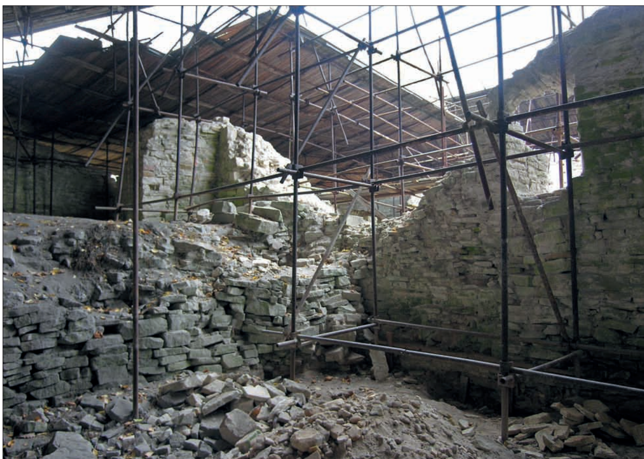
Obr. 123: Přizemí sektoru E v pohledu k jihozápadu. Vpravo nádvoří zeď, vlevo vyvýšené přízemí sektoru D. Stupeň mezi místnostmi není tvořen originálním lícem, ale jen novodobou rovnaninou z kamene přibližně na jeho místě (snímek autor, 2008).
