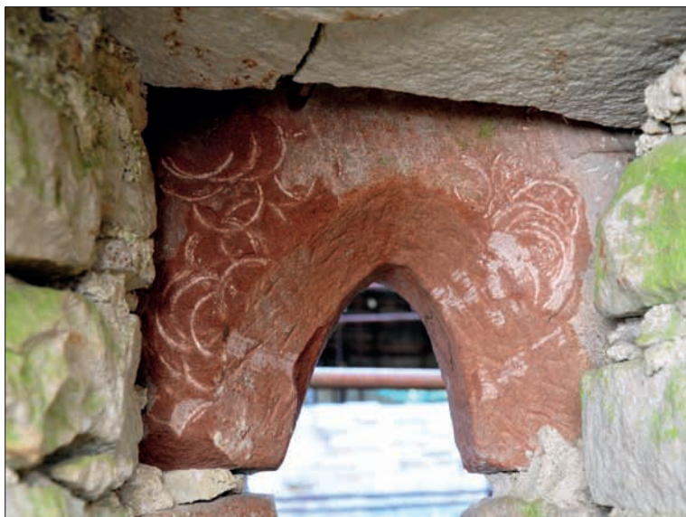
Obr. 5: Detail vnitřní strany ostění severního okénka nádvorní zdi západního křídla. Četná poškození kruhového tvaru způsobil vandal, když se pomocí železné trubky lešení snažil ostění vyrazit nebo zničit (snímek autor, 2006).
