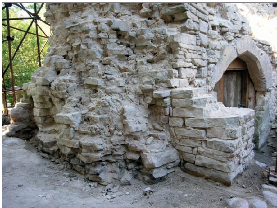
Obr. 152: Pohled na jihovýchodní část západního křídla. Vpravo vchod do sklepa, vlevo obnažené jádro zdiva na místě zaniklé severní stěny brány (srov. obr. 146). Uprostřed fragment pilířku, jenž byl na spáru přisazen k zakončení hradby, které tvořilo stěnu brány. Pilířek je založen do nižší úrovně než hradba (snímek autor, 2006).
