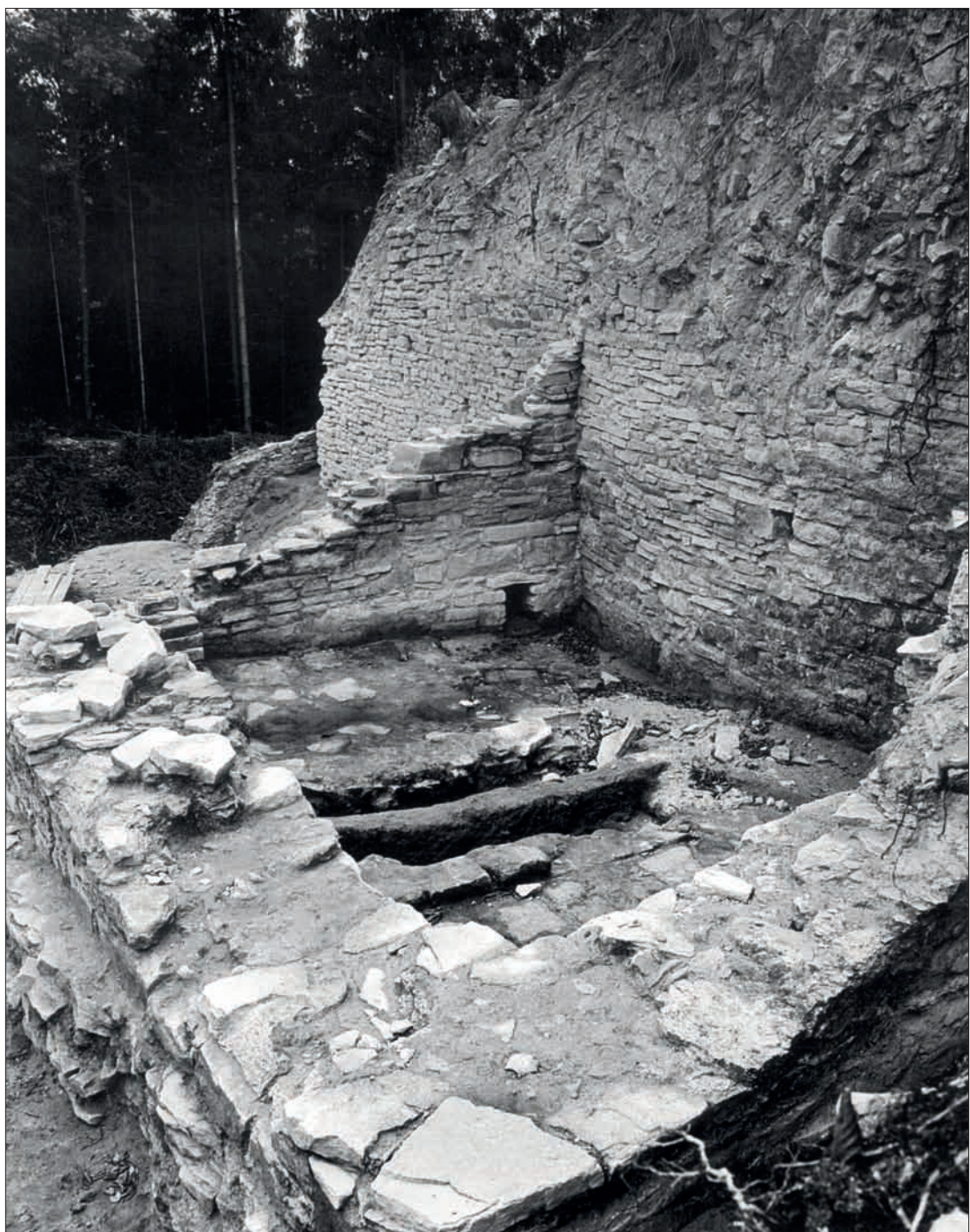
Obr. 179: Interiér tzv. kovářny od sz. Dobře je patný náběh zaniklé klenby v protilehlém rohu (snímek z archivu autora, asi 1976).
