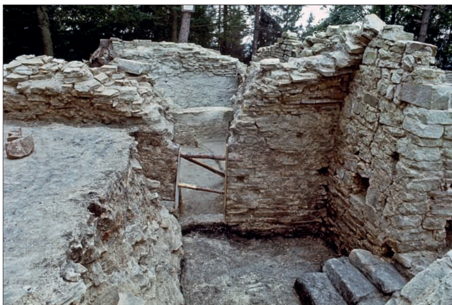
Obr. 103: Vytvářené přízemí sektoru D, pohled k jihu až jv. (vlevo část neodstraněné sutě). Průchod do sektoru C, vpravo schody ke vstupu z nádvoří (snímek z archivu autora, asi 1974).
