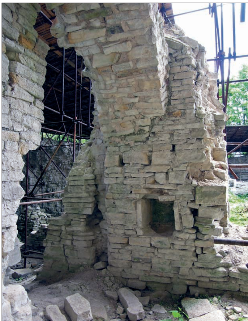
Obr. 171: Pohled z interiéru kuchyně na jihovýchodní pilíř dymníku, s odkládací nikou. Vlevo od pilíře visí drážka (negativ) po zaniklé stojce ostění vchodu do severní místnosti sektoru F (snímek autor, 2006).
