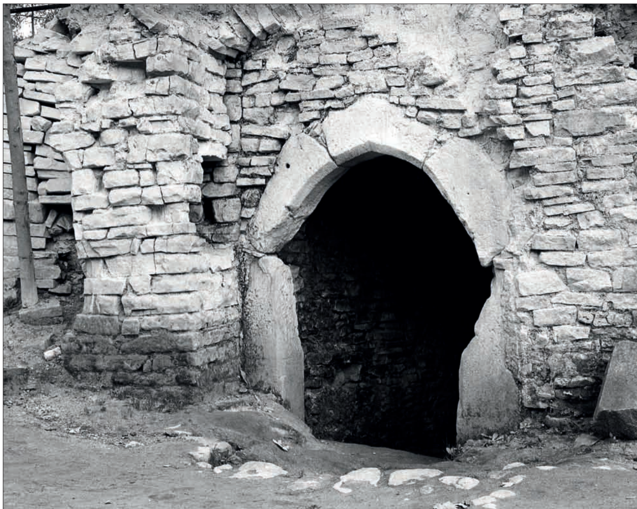
Obr. 153: Vchod do sklepa západního křídla, portálek s náznakem „oslího hřbetu“ (který však nemá datační význam) a druhotně upravenými stojkami. Vlevo od portálu pilířek s odkládací nikou, segmentový záklenek nad vchodem se již zřítíl. Valounová dlažba nádvoří ještě není odkryta (snímek z archivu autora, asi 1980).
