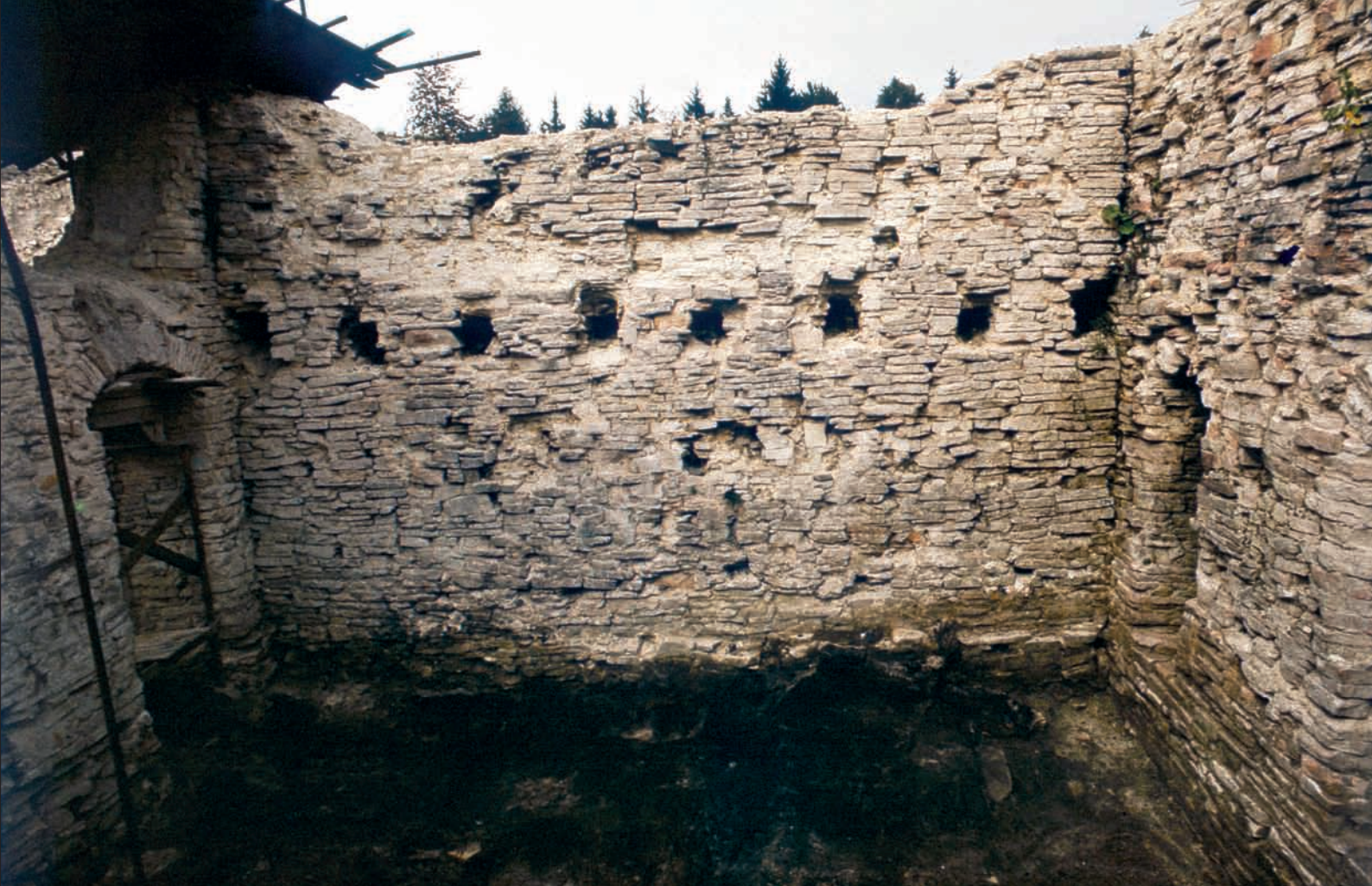
Obr. 120: Severní stěna přízemí sektoru E po dosažení úrovně se spálenými dřevy (snímek z archivu autora, asi 1979).
