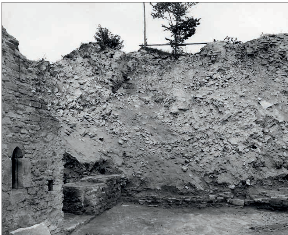
Obr. 40: Pohled od jihu na věž po úplném vyklizení přilehlé sutě z nádvoří. Dole několik řádků základové části zdiva (snímek ARÚ Praha, asi 1979).
