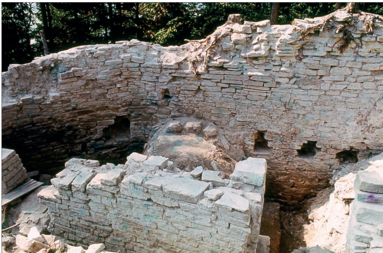
Obr. 156: Jižní část interiéru 1. patra západního křídla (nad sklepem) v pohledu z povrchu sutě v nádvoří (od východu). V nádvoří zdi zbytky dvou vstupů do patra, v obvodové hradbě dodatečné kapsy po stropních trámech přízemí (snímek z archivu autora, asi 1973).
