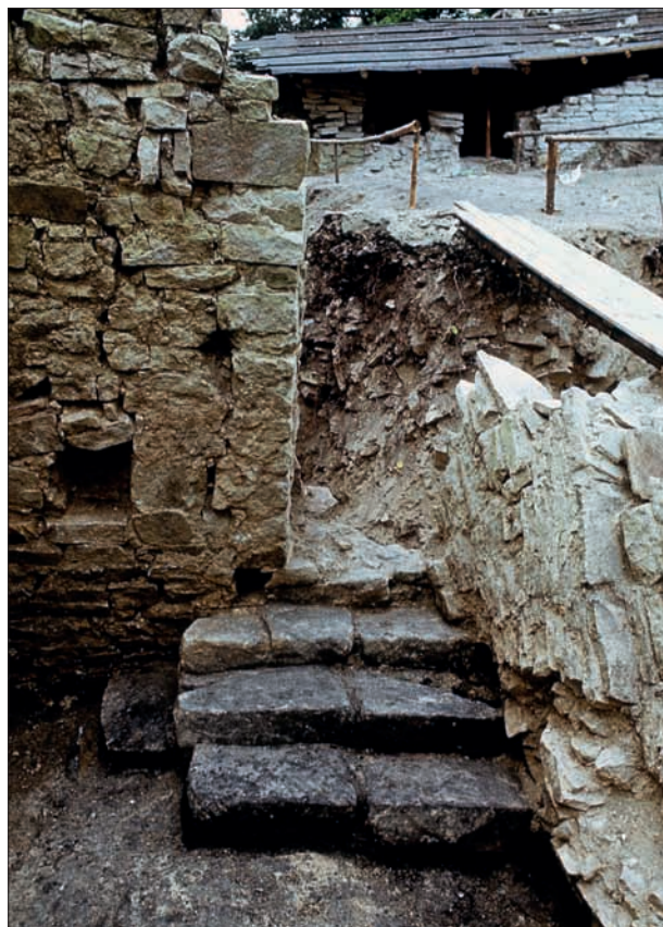
Obr. 105: Vyvýšené přízemí sektoru D, detail vstupu z nádvoří se schody, vlevo odkládací nika ve stěně. Vpravo sesutá špaleta vstupu, v pozadí suť v nádvoří (snímek z archivu autora, asi 1974).
