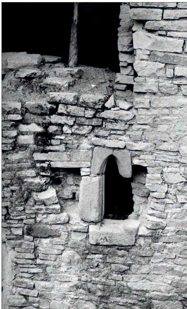
Obr. 150: Detail jižního okénka nádvořího průčelí západního křídla (srov. obr. 146). Z ostění dnes zbývá jen parapetní díl (snímek Dana Einhornová, asi 1979).
