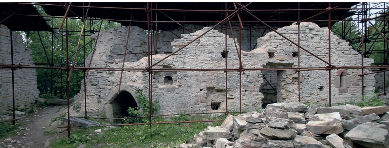
Obr. 145: Nádvorní průčelí západního křídla, vlevo proluka brány (snímek Václav Tutr, 2006).
