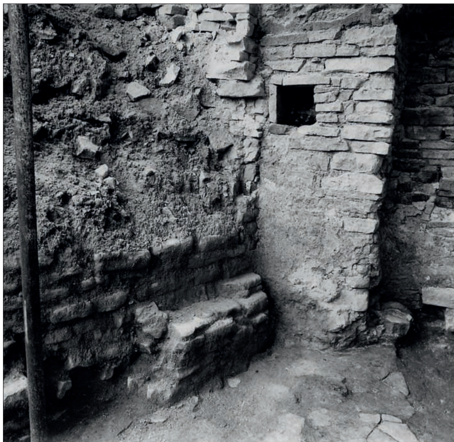
Obr. 165: Detail styku pláště věže (vlevo) a sz. pilíře dymníku kuchyně. Před plášť věže předstupuje blok zdiva, zřejmě mladší než pilíř (snímek ARÚ Praha, asi 1980).
