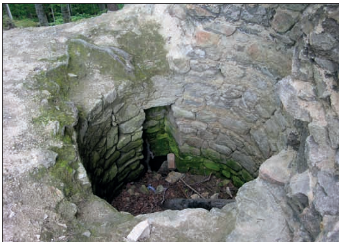
Obr. 235: Zajímavé srovnání nabízí válcová věž hradu Kaltenštejn v Rychlebských horách (srov. obr. 233/3), vybudovaná před koncem 13. století. Protože zanikla celá polovina věže, lze si na svislém řezu dobře prohlédnout její vnitřní utváření. Věž má v průměru 10,6 m, interiér vysokého přízemí, které mělo rovný strop, dosahuje pouze necelých dvou metrů. Hmoty zdíva je na rozdíl od vizmburské věže „jednotlivá“. Do kopolí klenutého 1. patra se vstupovalo průchodem, který bylo možno na obou stranách uzavřít. Z průchodu stoupalo schodiště v síle zdi do 2. patra, jež mělo podstatně prostornější interiér. Stejně jako na Vizmburku, je ze dna přízemí věže přístupná šachta, údajně vylámaná v podložní skále. I když je šachta jinak utvářená, je pravděpodobné, že měla podobný účel (snímky věže a šachty na jejím dně autor, 2005; zaměření Kouřil – Prix – Wihoda 2000, 214).
