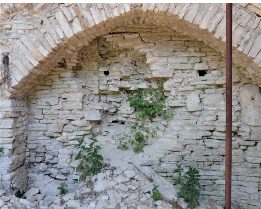
Obr. 167: Celkový pohled na severní stěnu kuchyně (srov. obr. 172 dole). Vlevo pod obloukem svislá spára v hradbě, vpravo obnažená část zazděného portálku do tzv. kovárny (snímek autor, 2011).
