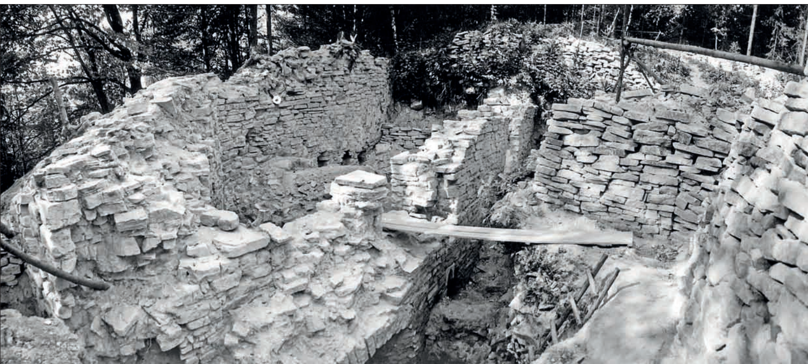
Obr. 154: Pohled od jv. na západní křídlo. Uprostřed jižní vchod do 1. patra, zcela vlevo severní stěna brány (snímek z archivu autora, 1973–1974).
