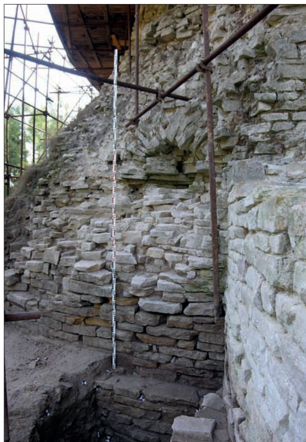
Obr. 48: Fragment vnějšího pláště věže s horním základovým stupněm (dole), nahoře v hloubce masy zdiva klenbička odlehčující strop skříše ve zdivu přízemí (srov. obr. 51). Vpravo čerstvě rekonstruovaný líc severního zakončení západní části hradby (OPD v závěru důlčitého archeologického výzkumu, snímek autor, 2008).
