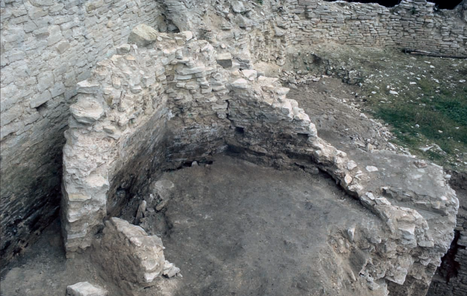
Obr. 162: Částečně obnažené torzo dymníku kuchyně v pohledu od jz. (snímek z archivu autora, asi 1976).
