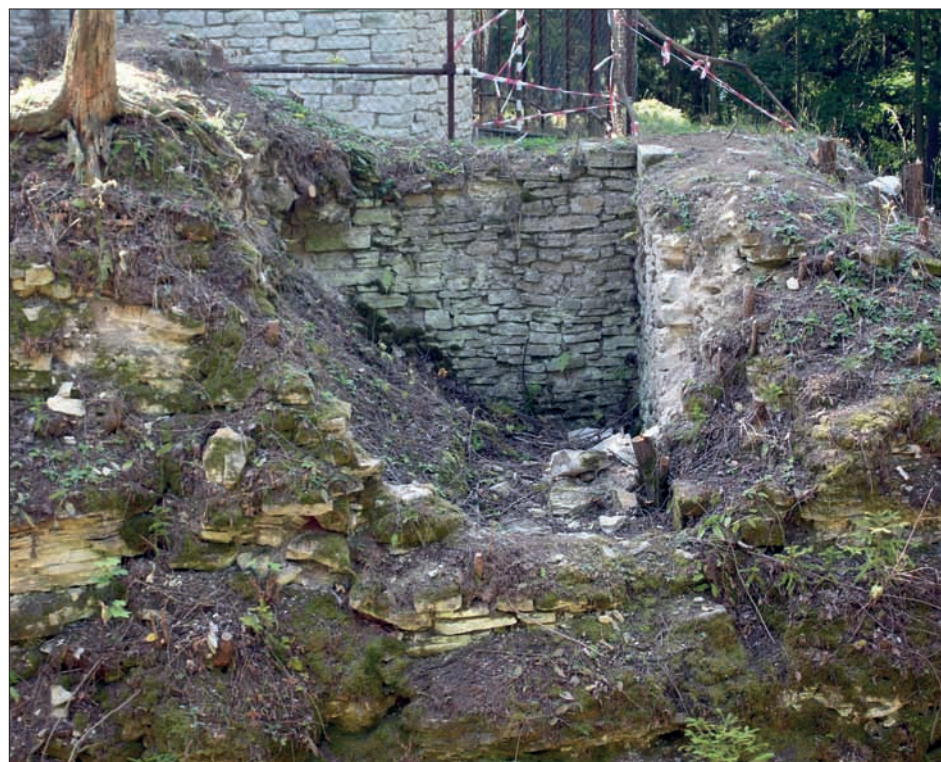
Obr. 215: Tzv. vltčí jáma druhé brány, pohled od jihu (srov. obr. 214), současný stav (snímek autor, 2008).
