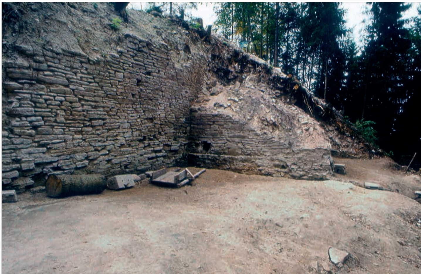
Obr. 175: Pohled na tzv. kovárnu a část parkánu od východu, před vytěžením interiéru stavby (snímek z archivu autora, asi 1975–1976).
