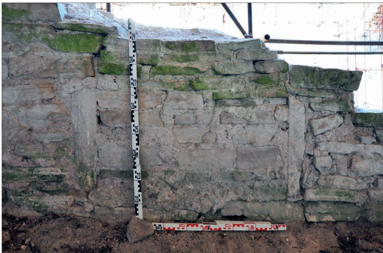
Obr. 87: Zazděná spodní část niky západního okna v nádvoří zdi síně B. Po stranách sedátka (vodorovná plocha se dochovala jen vlevo), vymezená svíslými kameny (snímek autor, 2012).
