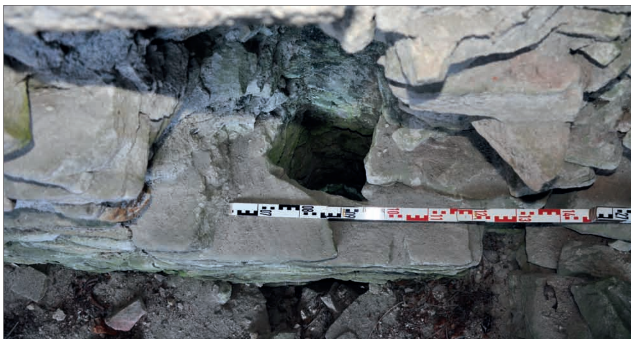
Obr. 125: Pohled shora na negativ svislého dřevěného prvku (srov. obr. 124) za druhotným lícem hradby (snímek autor, 2012).
