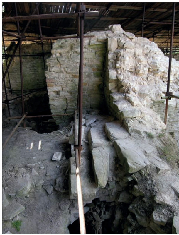
Obr. 107: Vyvýšené přízemí sektoru D, současný stav vstupu se schodištěm z nádvoří v pohledu od severu. Pod ním (na snímku zcela dole) otvor na místě průduchu ze sklepa (snímek autor, 2007).
