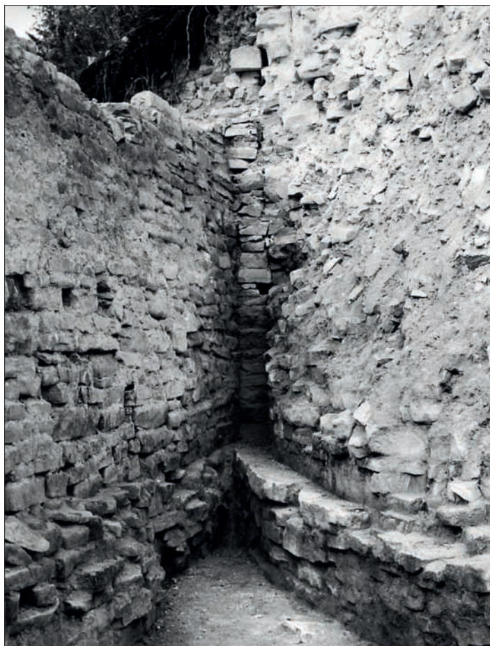
Obr. 41: Styk věže (vpravo) a západní části obvodové hradby v pohledu ze západního křídla (srov. snímek 42, vlevo). Předstupující základové zdivo hradby respektuje svým průběhem a šířkou základové zdivo věže. Na styku svislý proužek líce zdiva, jímž hradba přiléhala na spáru k věži (snímek ARÚ Praha, asi 1979).
