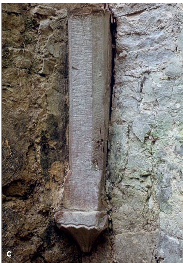
Obr. 88: Klenební konzoly nalezené in situ v obvodových zdech síně B: a – konzola se třemi výběhy žebí (meziklenební); b – konzola v mírném zlomu hradby; c – konzola v ostrém sz. koutě hradby; d – konzola v sv. koutě – horní dílec žebra záhy po obnažení spadl (snímky z archivu autora, 1973–1974).
