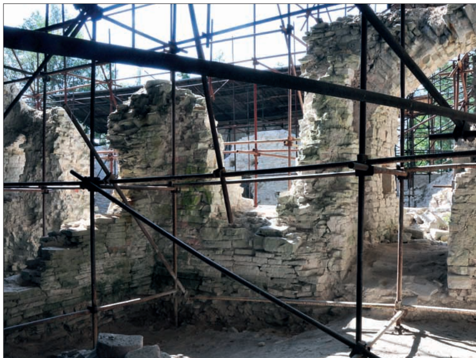
Obr. 140: Severní místnost sektoru F, pohled k jihozápadnímu rohu (srov. obr. 138 a 139). Vlevo zbytek dělicí zdi, uprostřed deprese na místě okénka, vpravo vchod do kuchyně (snímek autor, 2009).
