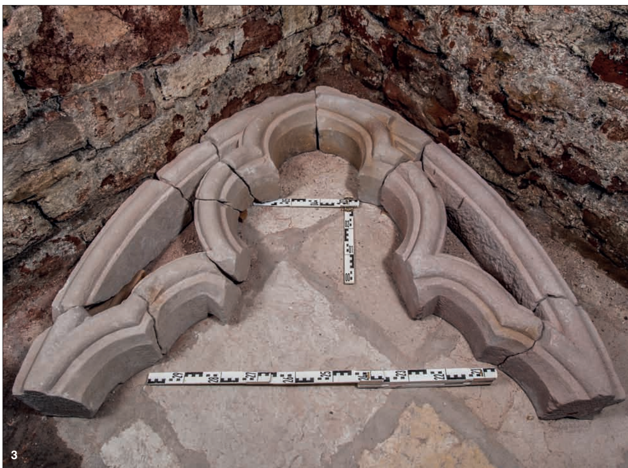
Obr. 202: Sektor B. 1 – zbytek druhé (severní) meziklenební konzoly, 2 – svorník s motivem čtyřlístku (snímky z archivu autora, 1973–1974), 3 – kružba okna z 1. patra (snímek Martin Micka, 2012).
