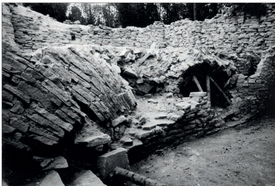
Obr. 102: Vytvářené přízemí sektoru D, zbytky západní stěny se zřícenou špaletou vstupu z nádvoří (vlevo), vpravo část klenby (srov. obr. 100), jež se vcelku sesula do sektoru E (snímek ARÚ Praha, asi 1975).
