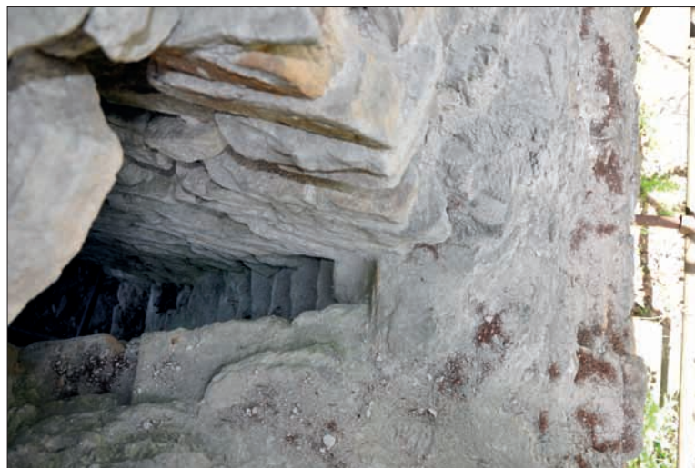
Obr. 65: Detaily jižního z trojice okének na východní straně obvodové hradby: vlevo pohled zevnitř, dole stupňovitý parapet a nahoře záklenek, který při vnějším ústí přechází v rovný překlád; vpravo nejužší místo okénka v pohledu shora, vlevo stupňovitý parapet, vpravo tloušťka zdiva zbývající k vnějšmu líci hradby, nahoře uprostřed severní špaleta okénka (snímek autor, 2012).
