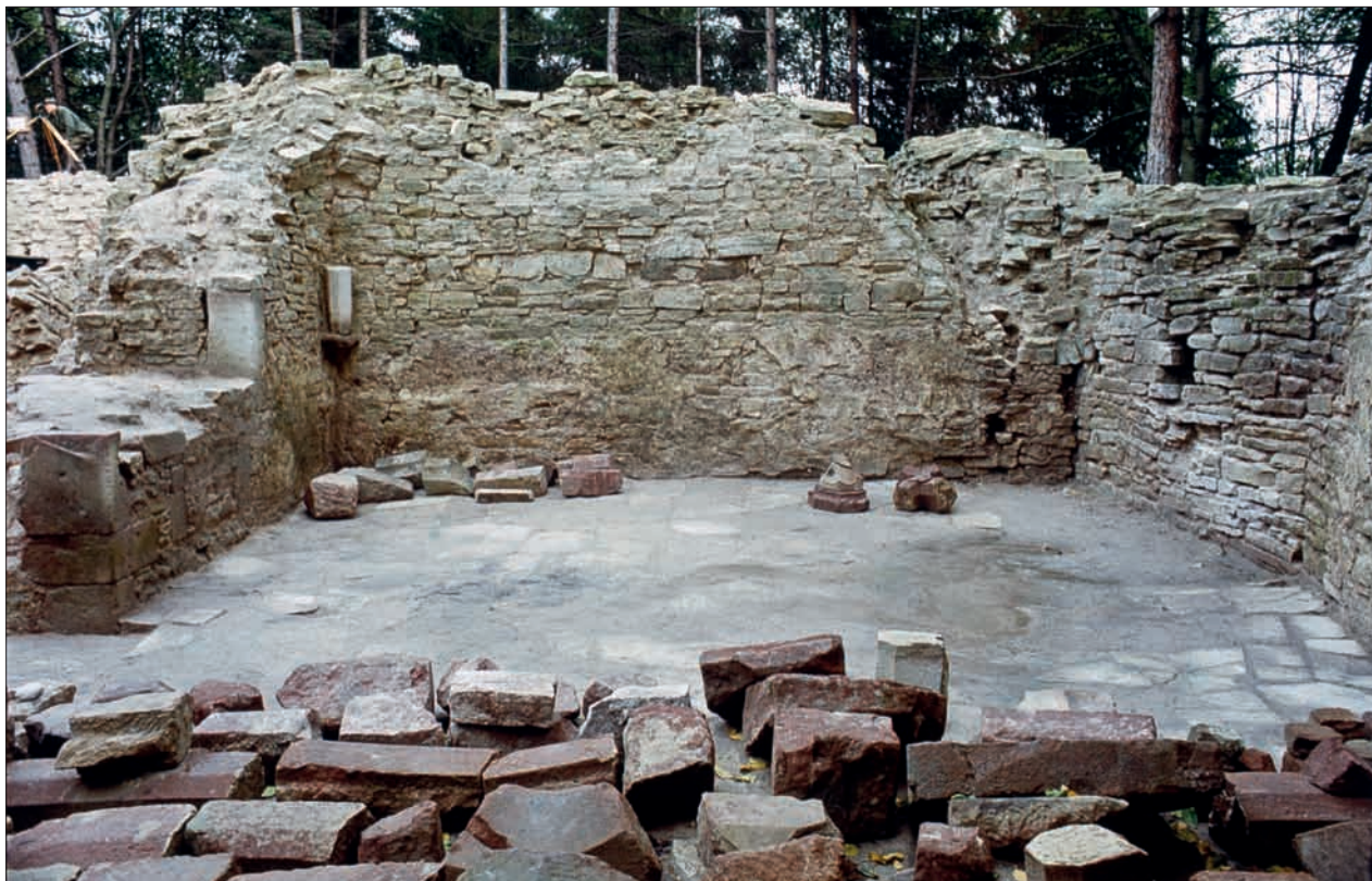
Obr. 85: Pohled k východní stěně interiéru síně B. Vlevo pozůstatky špalet vstupu a okna, v pozadí vlevo (srov. obr. 88/d) sv. koutová konzola (snímek z archivu autora, asi 1974).
