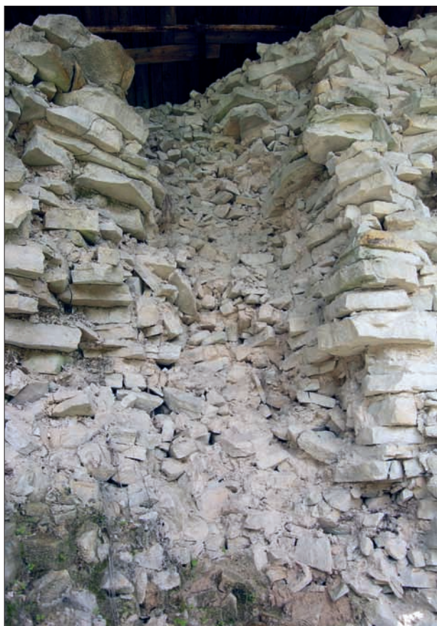
Obr. 47: Detail kaverny vzniklé částečným zánikem „sypané“ výplně zdiva věže (srov. obr. 46). Nevíme, zda se tato výplň uplatňovala v celé výšce zdiva věže. Lze předpokládat její absenci v nejspodnější úrovni ze statických důvodů, případně ve vyšších partiích, kde bylo zdivo poněkud slabší a obsahovalo okenní otvory, případně schodiště v síle zdiva (snímek autor, 2006).
