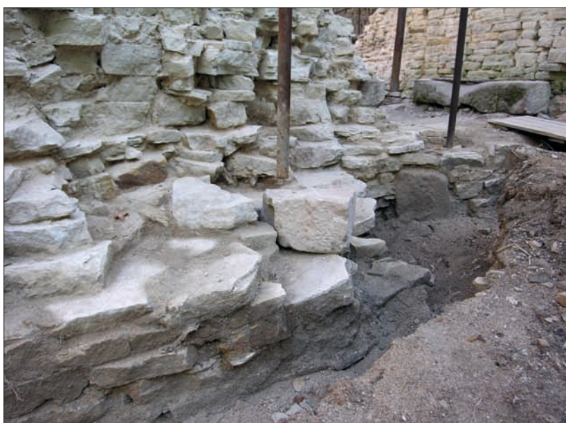
Obr. 197: Detail spodní části zdiva hradby předstupujícího v sz. sousedství brány do parkánu (pohled od sz.). V pozadí obnažené zdivo pod prahem, který je již odstraněn (stav v průběhu rekonstrukce brány, snímek autor, 23. 9. 2006).
