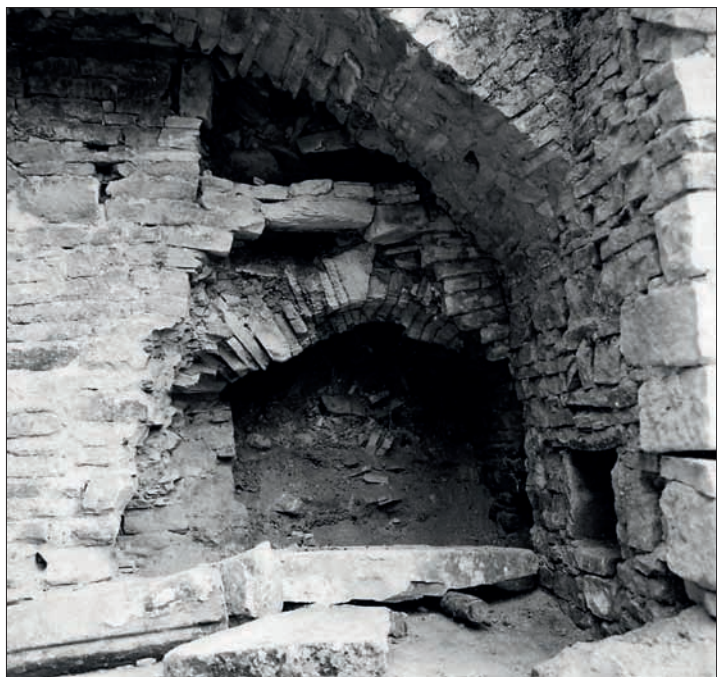
Obr. 170: Pohled z kuchyně na vstup do severní místnosti sektoru F v průběhu archeologického výzkumu (srov. obr. 169). Dosud je dochován segmentový základnek niky vstupu a částečně také zdivo nad ním, portál však již nestojí (snímek ARÚ Praha, asi 1979).
