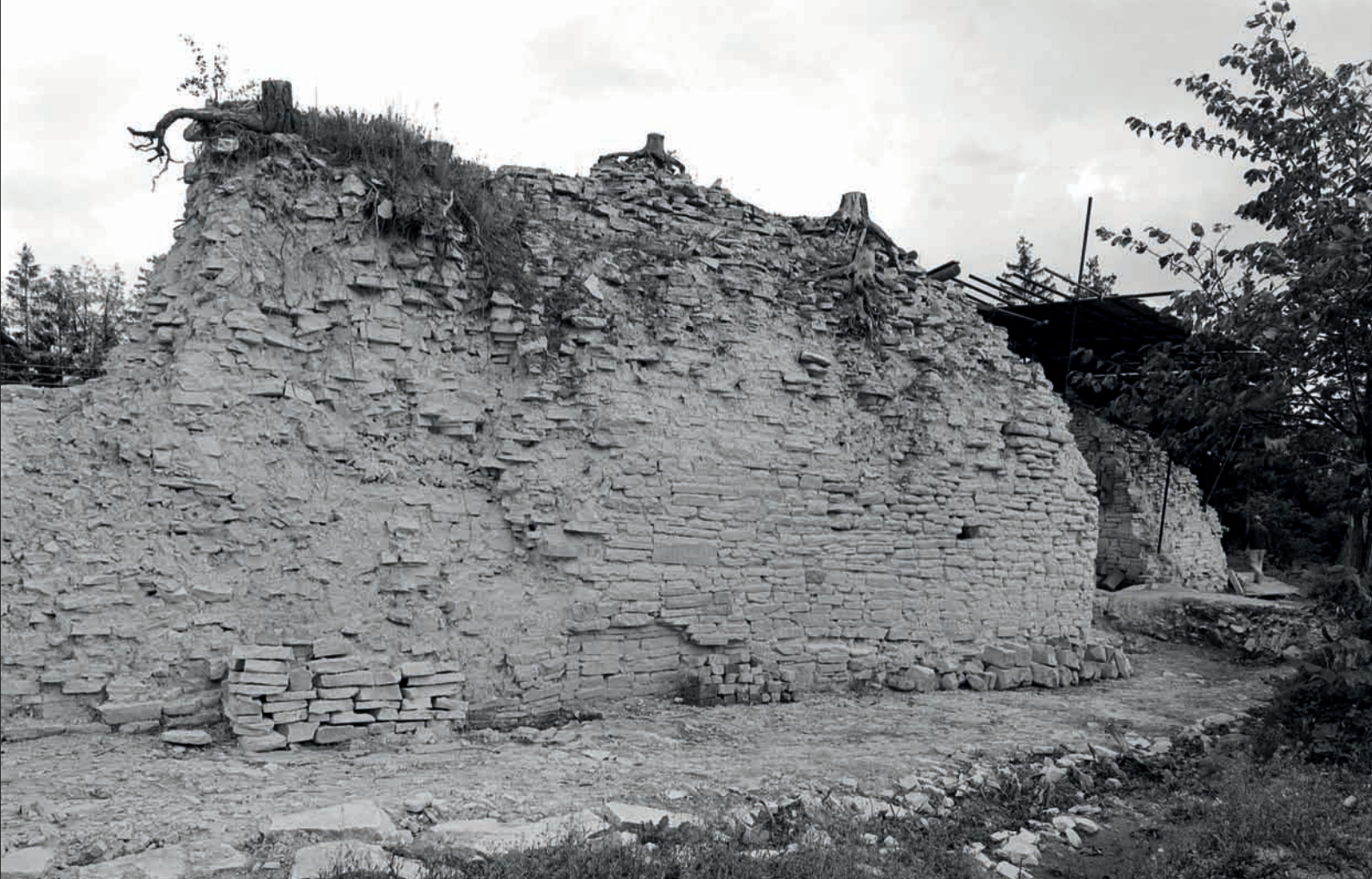
Obr. 210: Západní parkán po odstranění suti, pohled směrem k bráně (vpravo). Dole (částečně kryto provizorně uskladněnými kamenickými články a cihlami) jsou vidět místa s ustupujícím lícem. Na koruně hradby pařezy stromů, udávající úroveň terénu v době před zahájením archeologického výzkumu (snímek ARÚ Praha, 1981–1982).
