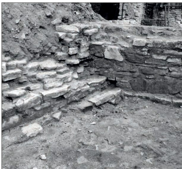
Obr. 43: Detail styku věže a nádvorní zdi západního křídla (srov. snímek 42, vpravo). Dobře lze rozeznat dva základové stupně věže a fragment jejího líce v místech, kde na spáru přiléhá zeď (snímek z archivu autora, asi 1979).
