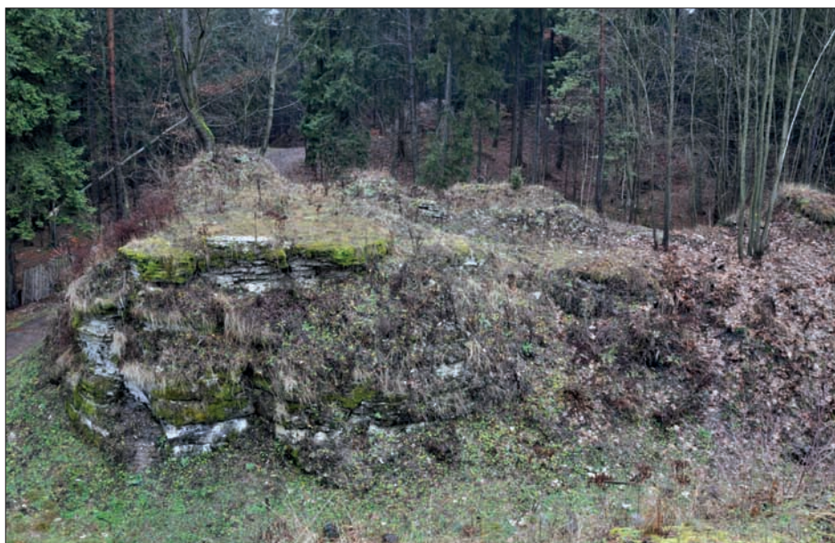
Obr. 223: Stejný záběr (srov. obr. 222), současný stav (snímek autor, 2011).
