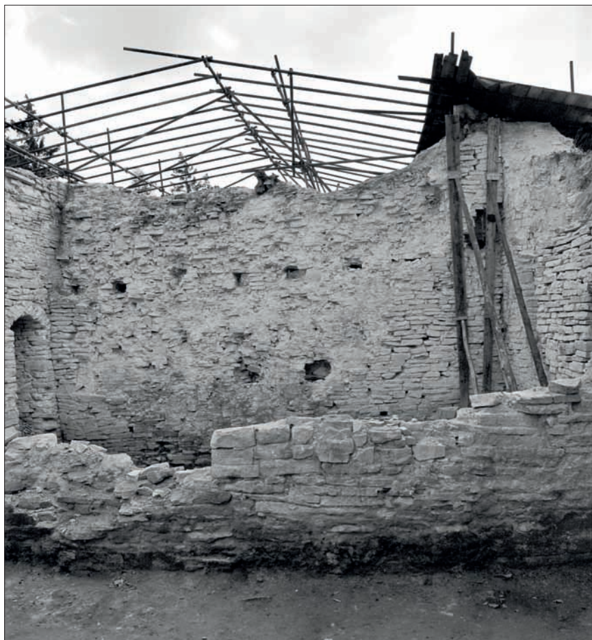
Obr. 132: Pohled na jižní stěnu jižní místnosti sektoru F, s vodorovnou řadou otvorů po trémovém stropu. V popředí zbytky dělicí zdi (snímek z archivu autora, asi 1981).
