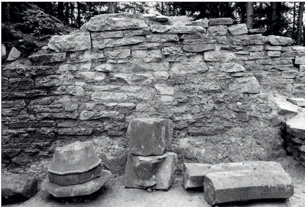
Obr. 99: Vyvýšené přízemí sektoru D, pohled k východu, ke klenební příložce. V popředí v suti nalezené kamenické prvky – vpravo dva kusy žebra, směrem doleva následují část přípory s konzolou, polygonální hlavice a abakus (snímek ARÚ Praha, asi 1974).
