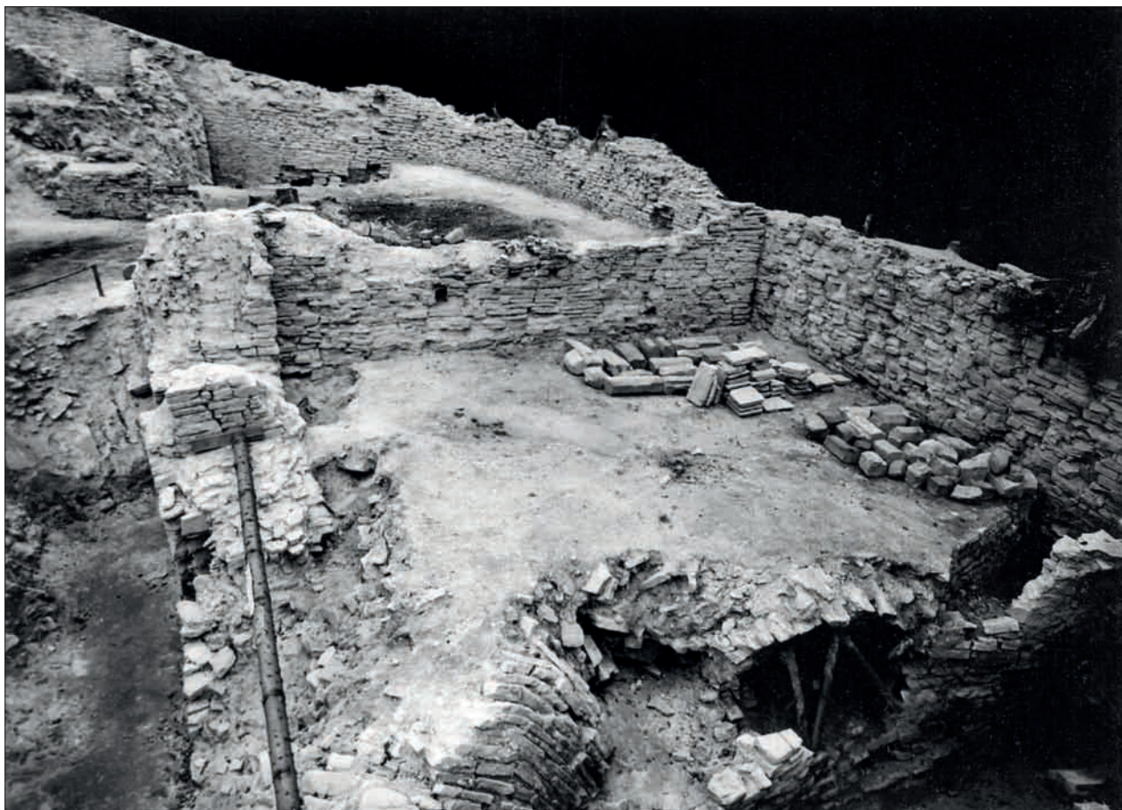
Obr. 110: Téměř shodný záběr (srov. obr. 109), natočený k sv. (snímek ARÚ Praha, asi 1975)
