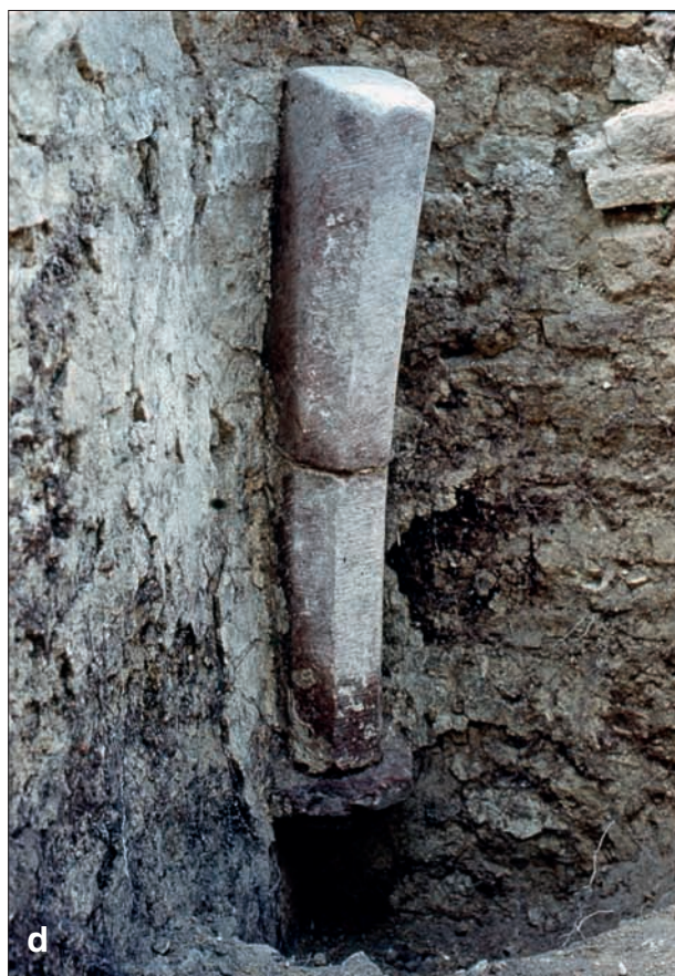
Obr. 88: Klenební konzoly nalezené in situ v obvodových zdech síně B: a – konzola se třemi výběhy žebí (meziklenební); b – konzola v mírném zlomu hradby; c – konzola v ostrém sz. koutě hradby; d – konzola v sv. koutě – horní dílec žebra záhy po obnažení spadl (snímky z archivu autora, 1973–1974).
