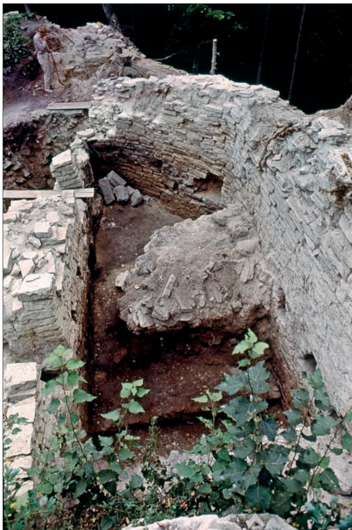
Obr. 157: Pohled od severu do interiéru západního křídla. Sut' nad klenbou sklepa ještě není zcela odstraněna (srov. obr. 156). V pozadí prostor brány, který se teprve začíná odhalovat (snímek z archivu autora, asi 1973).
