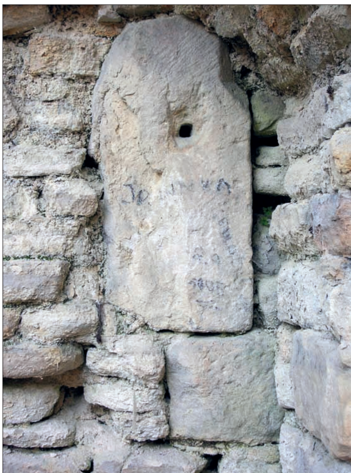
Obr. 173: Detail sv. rohu kuchyně s pilířem dymníku. Vlevo obnažená část portálku. Vpravo druhotné zkosení ve východní zdi (srov. obr. 169), související se zřízením portálku (snímek autor, 2006).
