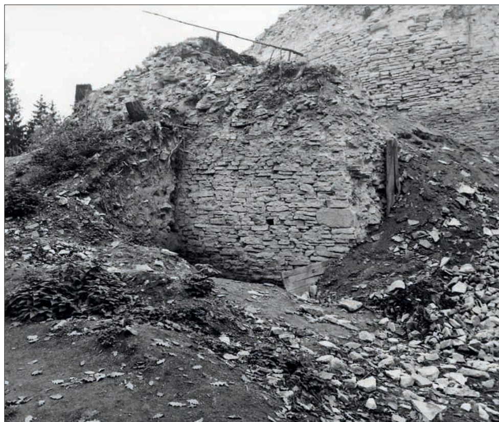
Obr. 218: Vnější líč parkánové hradby na vsv. straně hradu v průběhu jejího postupného obnažování (snímek ARÚ Praha, asi 1978).
