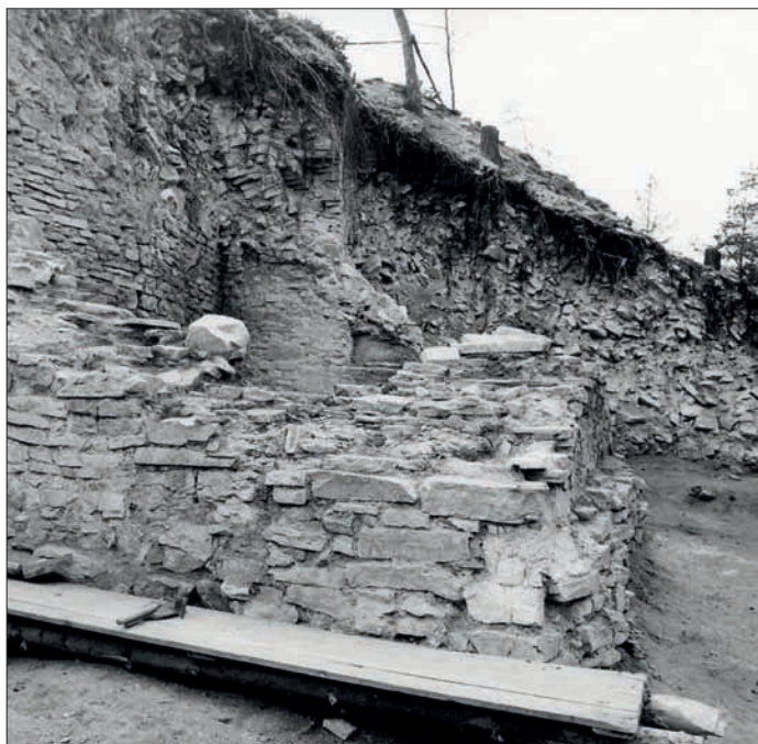
Obr. 176: Tzv. kovárna v pohledu od východu. V pozadí vnitřní strana její západní zdi s odkládací nikou, nad touto zdi blok zdiva přiložený k obvodové hradbě (snímek ARÚ Praha, asi 1976).
