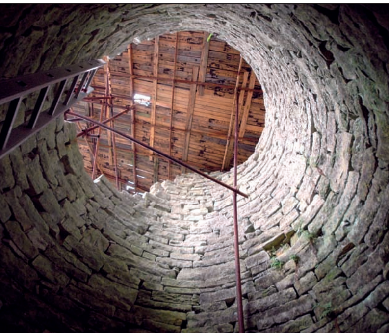
Obr. 49: Interiér přízemí věže, pohled ze dna prostoru vzhůru (snímek Václav Tutr, 2006).
