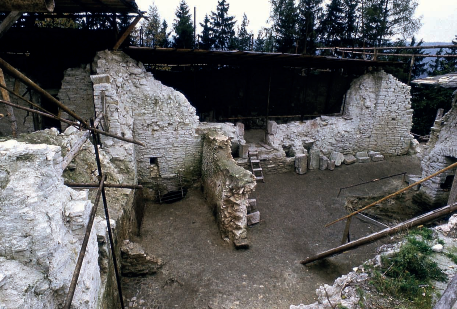
Obr. 69: Celkový pohled na jižní křídlo od sv. rohu nádvoří (snímek z archivu autora, asi 1978).
