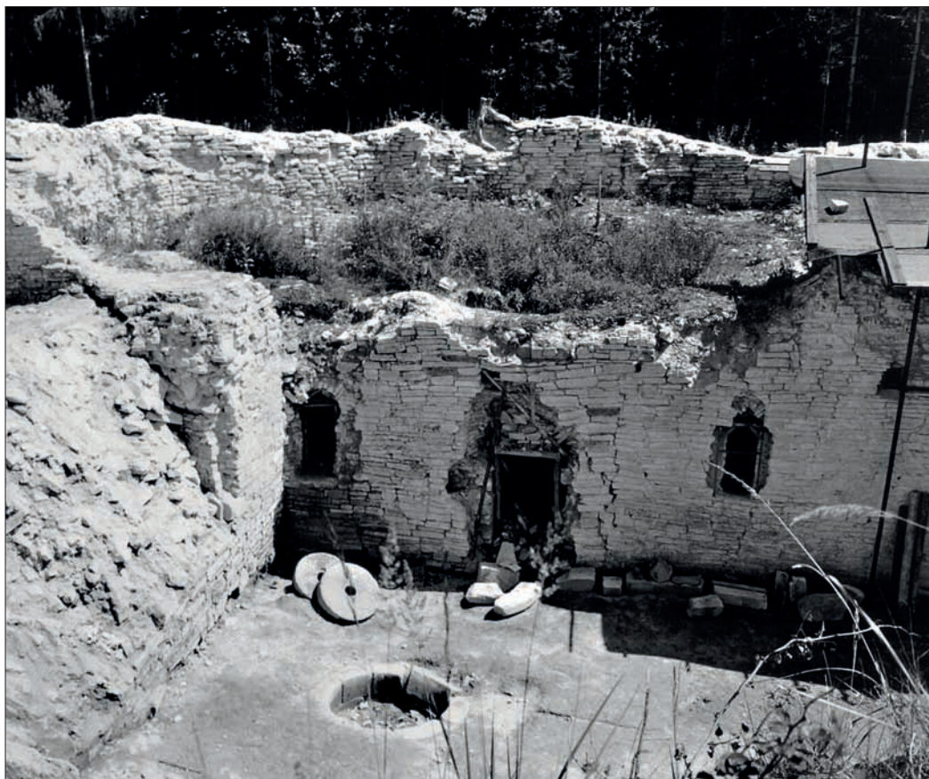
Obr. 128: Pohled na nádvorní fasádu sektoru F v pozdějším období – objevují se statické poruchy, rozpadá se vchod do přizemí, ostění vstupu do 1. patra zaniklo (snímek z archivu NPÚ, asi 1978).
