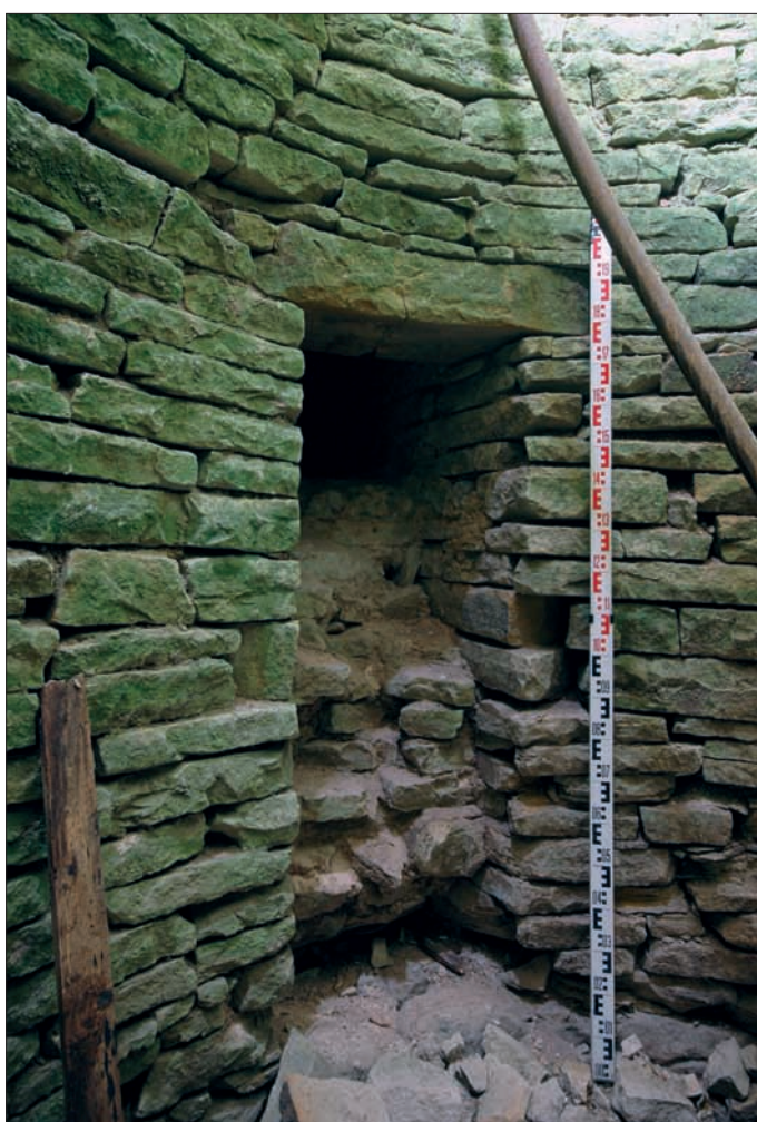
Obr. 55: Vstup z přízemí věže do skřížse v mase zdiva, s částečně dochovanou zazdívkou (snímek Václav Tutr, 2006).
