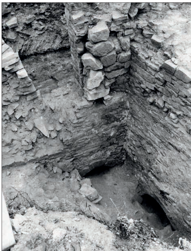
Obr. 106: Vyvýšené přízemí sektoru D, pohled z nádvoří (z povrchu dosud neodstraněné sutě) na vchod. Nároží pravé špalety z lomového kamene (nahore uprostřed), pod nímž je patrně otvor dřevěného nosníku pavlače, se záhy na to zřítilo. Dole záklenky vstupů do sklepů (snímek ARÚ Praha, asi 1974).
