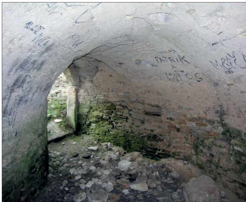
Obr. 161: Vnitřek sklepa západního křídla, pohled k jihu. Vpravo od portálu výklenek pro otevřené dveře (snímek autor, 2006).
