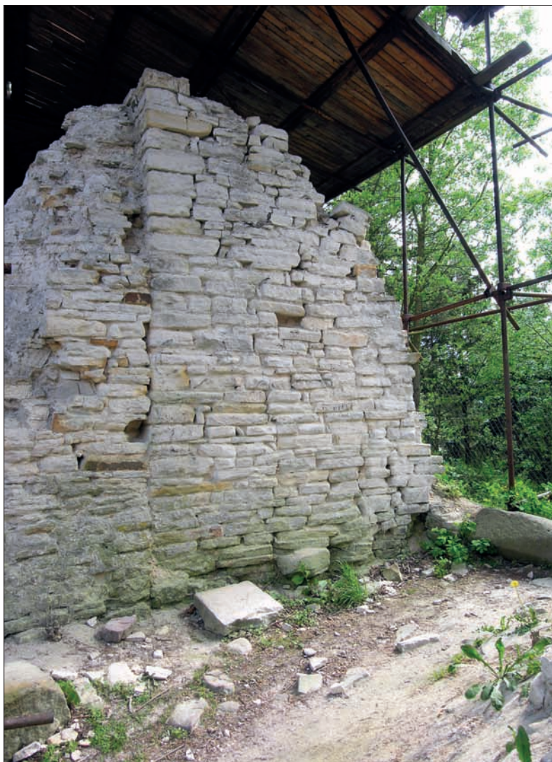
Obr. 63: Pohled z nádvoří na jižní stěnu brány jádra hradu, stav před rekonstrukcí. Vlevo svislá spára dodatečného připojení nádvořní zdi jižního křídla, vpravo dole práh (snímek autor, 2006).
