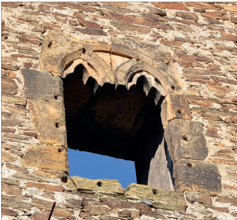
Obr. 241: Nádvorní průčelí paláce říčanského hradu, detail jednoho ze sdružených oken. Jejich záklenky jsou svou formou obdobou vizmburského záklenku s motivem třmene (snímek autor, 2011).
