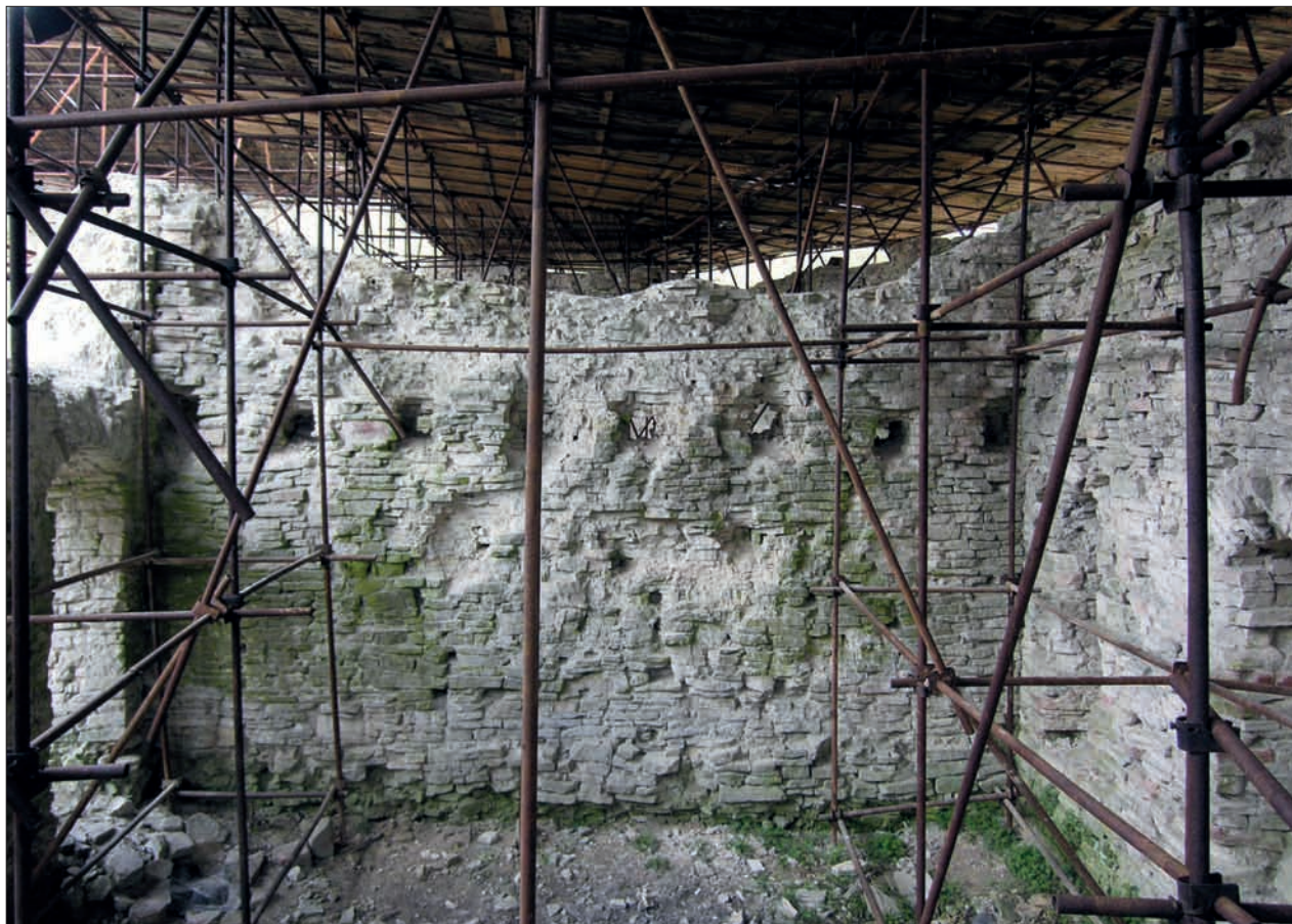
Obr. 121: Přízemí sektoru E v pohledu k severu, na dělicí zeď s otvory trámového stropu (srov. obr. 120). Vlevo vchod z nádvoří (snímek autor, 2007).
