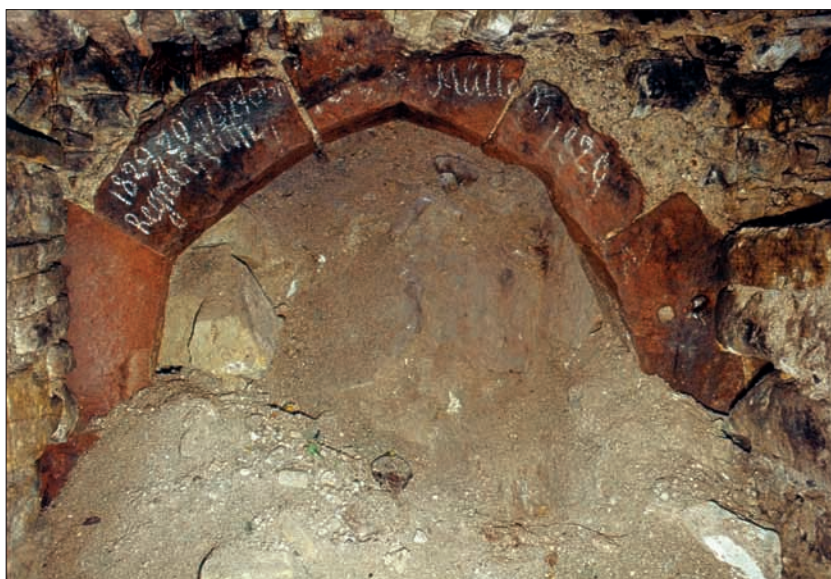
Obr. 6: Vnitřní strana horní části ostění portálu do sklepa pod jižní síní s autentickým dokladem návštěvy pátera Regnera a jeho třech průvodců 20. října 1829. Nejen nápis křídou, ale i samotný záklenek ostění nenávratně zmizely (snímek z archivu autora, 1974).
