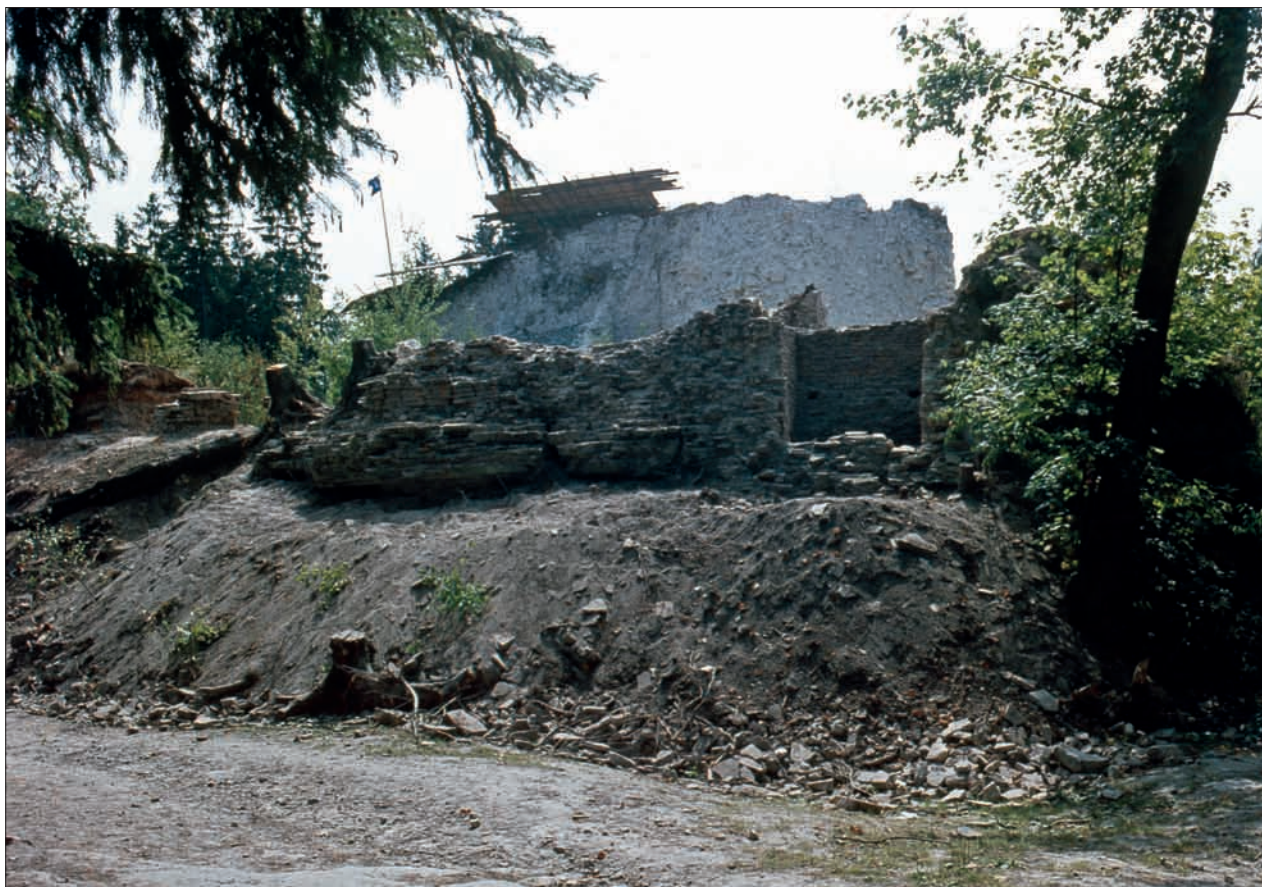
Obr. 224: Pohled od severu na část valu s tzv. vlčí jámou první brány (vpravo) a objekty po jejích stranách. V pozadí jádro hradu (snímek z archivu autora, asi 1983).
