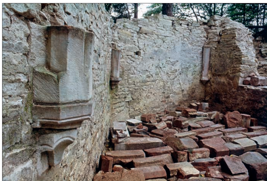
Obr. 83: Detailní pohled (srov. obr. 81) na stěnu s klenebními konzolami směrem k západu. Na podlaze jsou dočasně uskladněny v suti nalezené prvky zřícené žebrové klenby (snímek z archivu autora, asi 1974).
