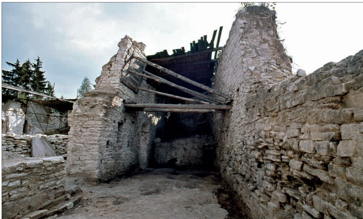
Obr. 158: Pohled od severu do interiéru západního křídla. Část nádvorní zdi (srov. obr. 147) je vzepřena (snímek z archivu autora, asi 1980).
