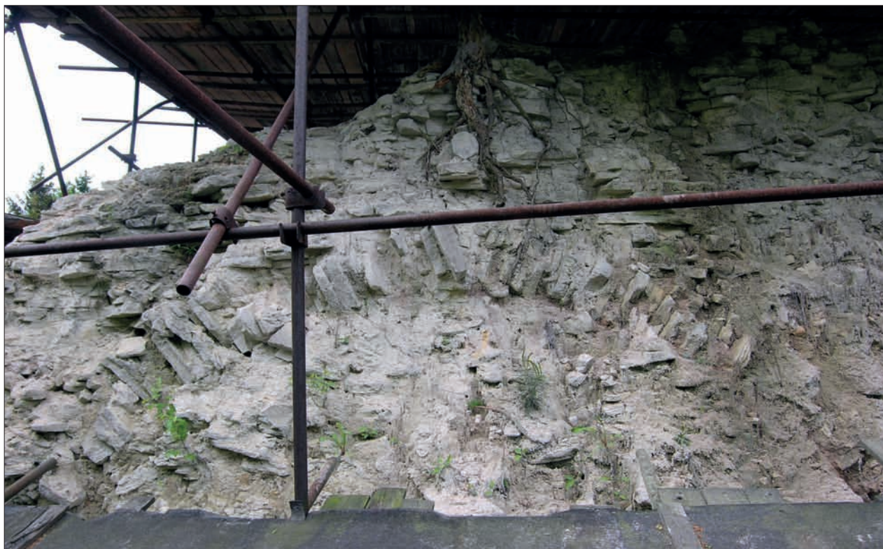
Obr. 181: Horní část zbytku klenby tzv. kovárny v hlavní hradbě, pohled od severu (srov. obr. 172 nahoře). Na koruně hradby pařez stromu, který je dokladem úrovně terénu v době před zahájením archeologického výzkumu v roce 1972 (snímek autor, 2006).
