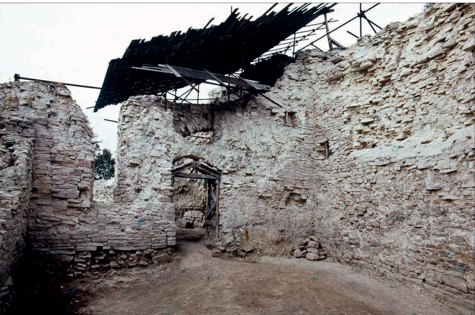
Obr. 139: Téměř stejný pohled (srov. obr. 138), po prozkoumání zbytku sutě (objevilo se tak základové zdivo) a zřízení záklenku okénka (snímek z archivu autora, asi 1982–1983).
