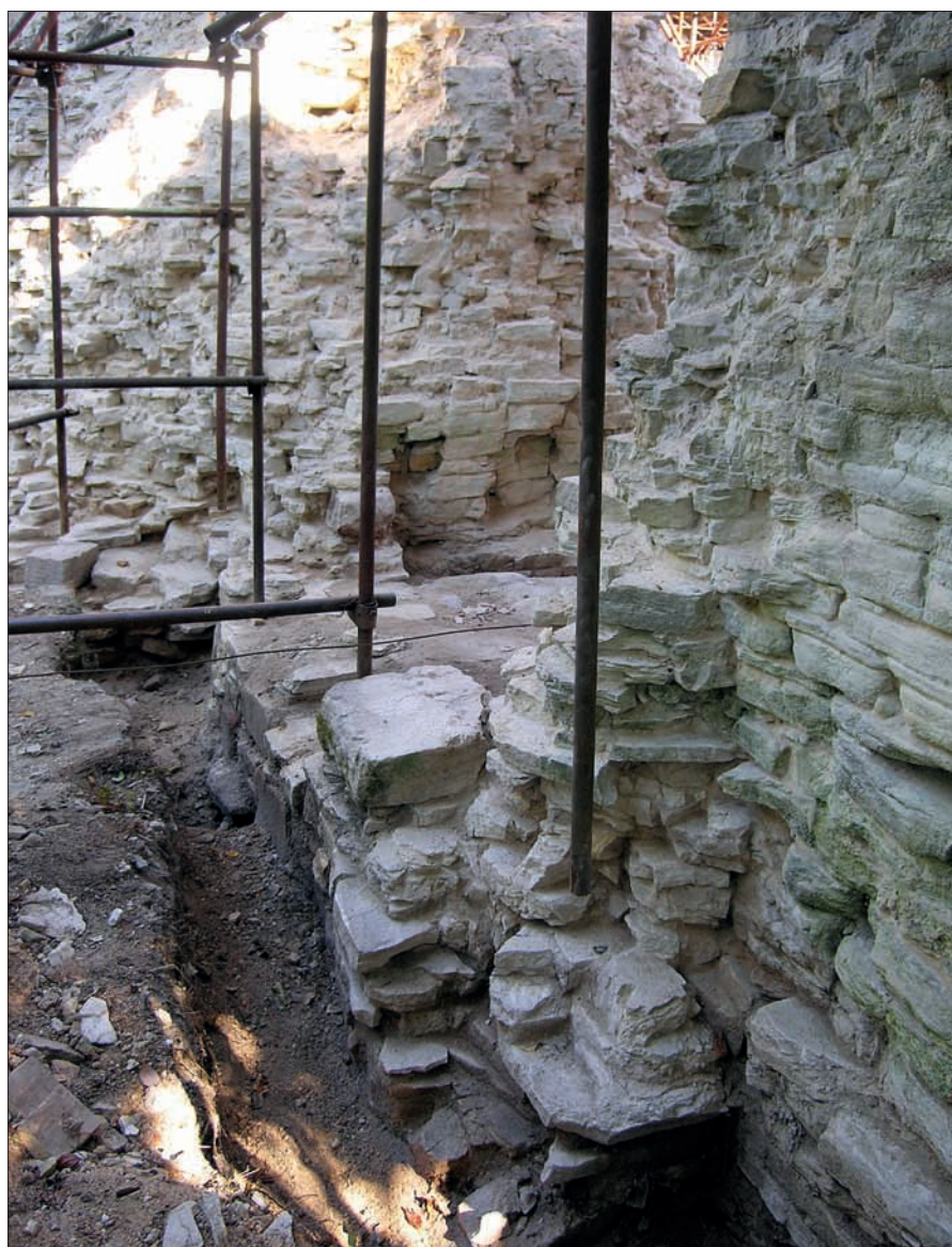
Obr. 198: Zdivo obnažené při rekonstrukci brány. Pohled od jihu, v popředí výběh zdiva v sousedství zaniklé jižní stojky portálu (snímek autor, 23. 9. 2006).
