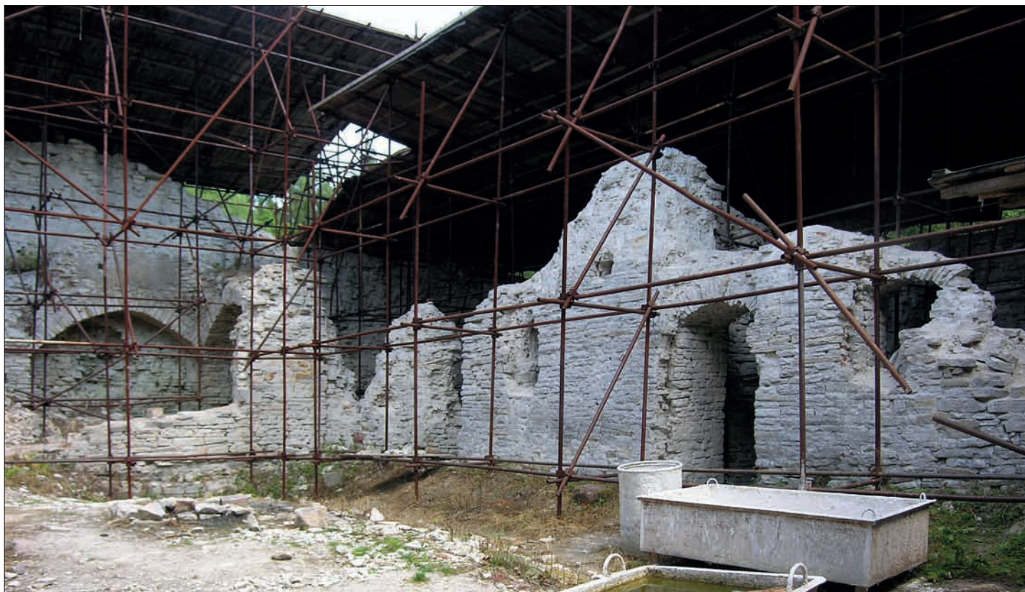
Obr. 116: Nádvorní průčelí východního křídla v pohledu od brány (srov. obr. 114 a 115), vlevo v pozadí kuchyně (snímek autor, 2008).
