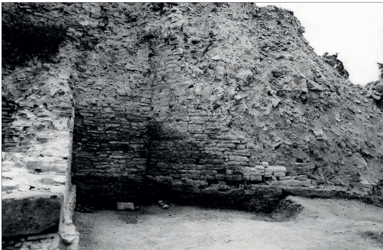
Obr. 45: Pohled ze severního parkánu na zbytek vnějšího pláště věže (vpravo), západní zeď tzv. kovářny (vlevo) a mezilehlý krátký úsek vnějšího líce hradby (snímek ARÚ Praha, asi 1982).
