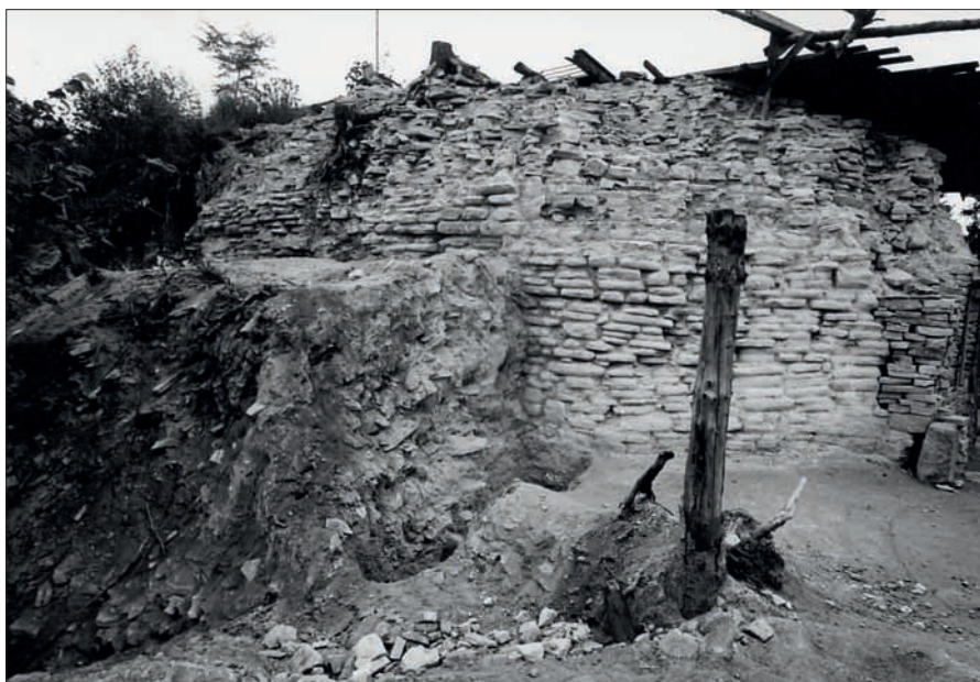
Obr. 208: Postupné odstraňování závalu západního parkánu. Vpravo severní stěna brány do jádra (srov. obr. 190), již s provizorní plentou (snímek ARÚ Praha, asi 1979).
