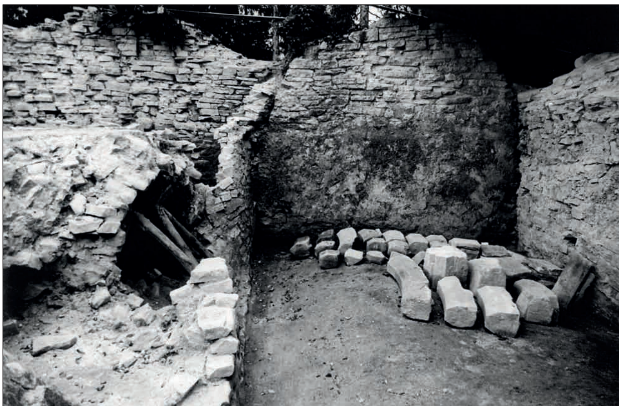
Obr. 100: Vyvýšené přízemí sektoru D, pohled k východu, po odstranění suti až na úroveň podlahy (srov. obr. 99). Vlevo část klenby, jež se vcelku sesula do sektoru E (snímek ARÚ Praha, asi 1975).
