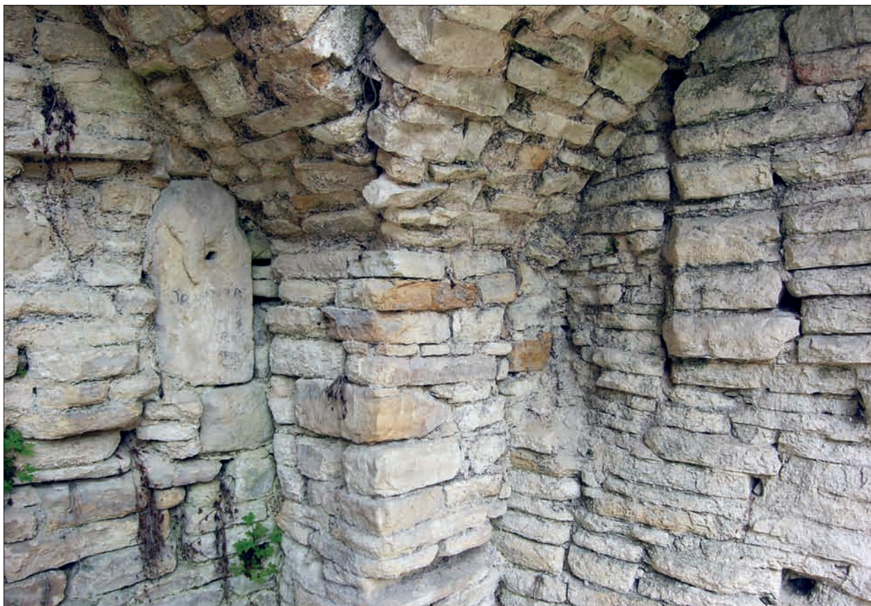
Obr. 173: Detail sv. rohu kuchyně s pilířem dymníku. Vlevo obnažená část portálku. Vpravo druhotné zkosení ve východní zdi (srov. obr. 169), související se zřízením portálku (snímek autor, 2006).
