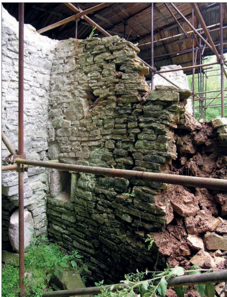
Obr. 78: Horní část portálu průchodu ze sklepa sektoru D do sklepa sektoru C. Pozoruhodné je nestandardní složení ostění z kusů různé velikosti, horniny a míry poškození (podobné anomálie se projevují také ve skladbě druhého sklepního portálu, srov. obr. 76), které může nasvědčovat druhotnému použití některých prvků (snímek Václav Tutr, 2006).
