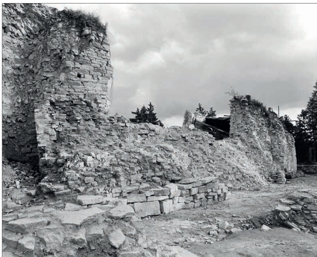
Obr. 62: Západní parkán v pohledu od sz. Uprostřed silně destruovaná hradba bez líce, s dobře patrnou vnitřní strukturou zdiva. Vpravo v pozadí vyšší úsek hradby u západního křídla. Vlevo v popředí fragment nároží hradby u věže, nad ním zbytek vnějšího pláště věže (snímek z archivu autora, 1981–1982).
