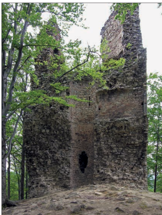
Obr. 235: Zajímavé srovnání nabízí válcová věž hradu Kaltenštejn v Rychlebských horách (srov. obr. 233/3), vybudovaná před koncem 13. století. Protože zanikla celá polovina věže, lze si na svislém řezu dobře prohlédnout její vnitřní utváření. Věž má v průměru 10,6 m, interiér vysokého přízemí, které mělo rovný strop, dosahuje pouze necelých dvou metrů. Hmoty zdíva je na rozdíl od vizmburské věže „jednotlivá“. Do kopolí klenutého 1. patra se vstupovalo průchodem, který bylo možno na obou stranách uzavřít. Z průchodu stoupalo schodiště v síle zdi do 2. patra, jež mělo podstatně prostornější interiér. Stejně jako na Vizmburku, je ze dna přízemí věže přístupná šachta, údajně vylámaná v podložní skále. I když je šachta jinak utvářená, je pravděpodobné, že měla podobný účel (snímky věže a šachty na jejím dně autor, 2005; zaměření Kouřil – Prix – Wihoda 2000, 214).
