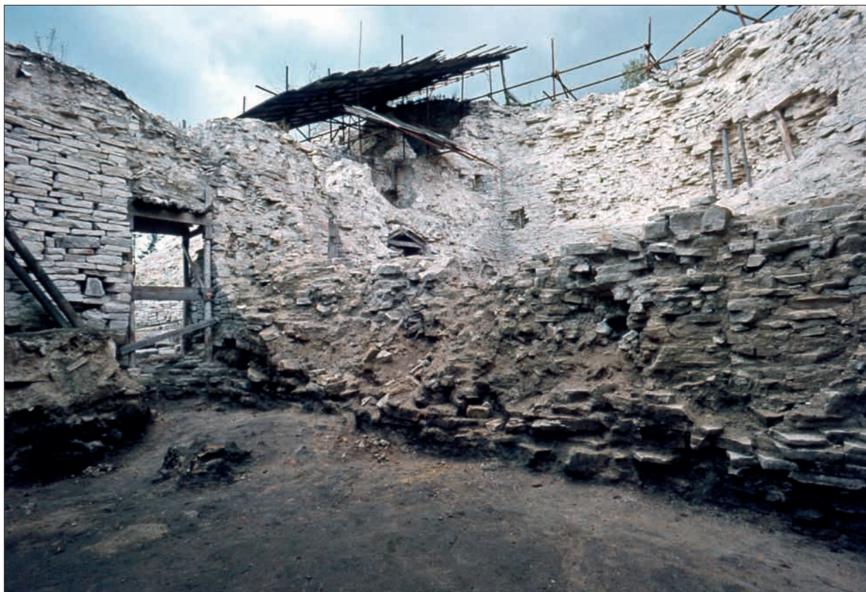
Obr. 136: Pohled z jižní místnosti sektoru F k sz. (srov. obr. 134). V popředí zbytky dělicí zdi (snímek z archivu autora, asi 1981).
