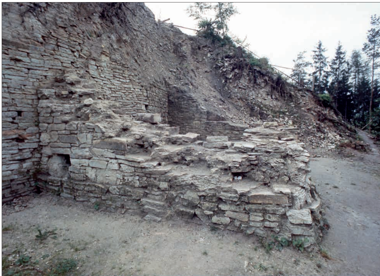
Obr. 180: Tzv. kovárna v pohledu od východu, v pozadí již není blok zdi přiložený k hlavní hradbě (srov. obr. 176). Vlevo v popředí je zřetelné připojení obvodové zdi tzv. kovárny k hradbě na spáru. Líc hradby probíhá nad korunou zdi až ke klenákům zaniklé klenby (snímek z archivu autora, asi 1979–1980).
