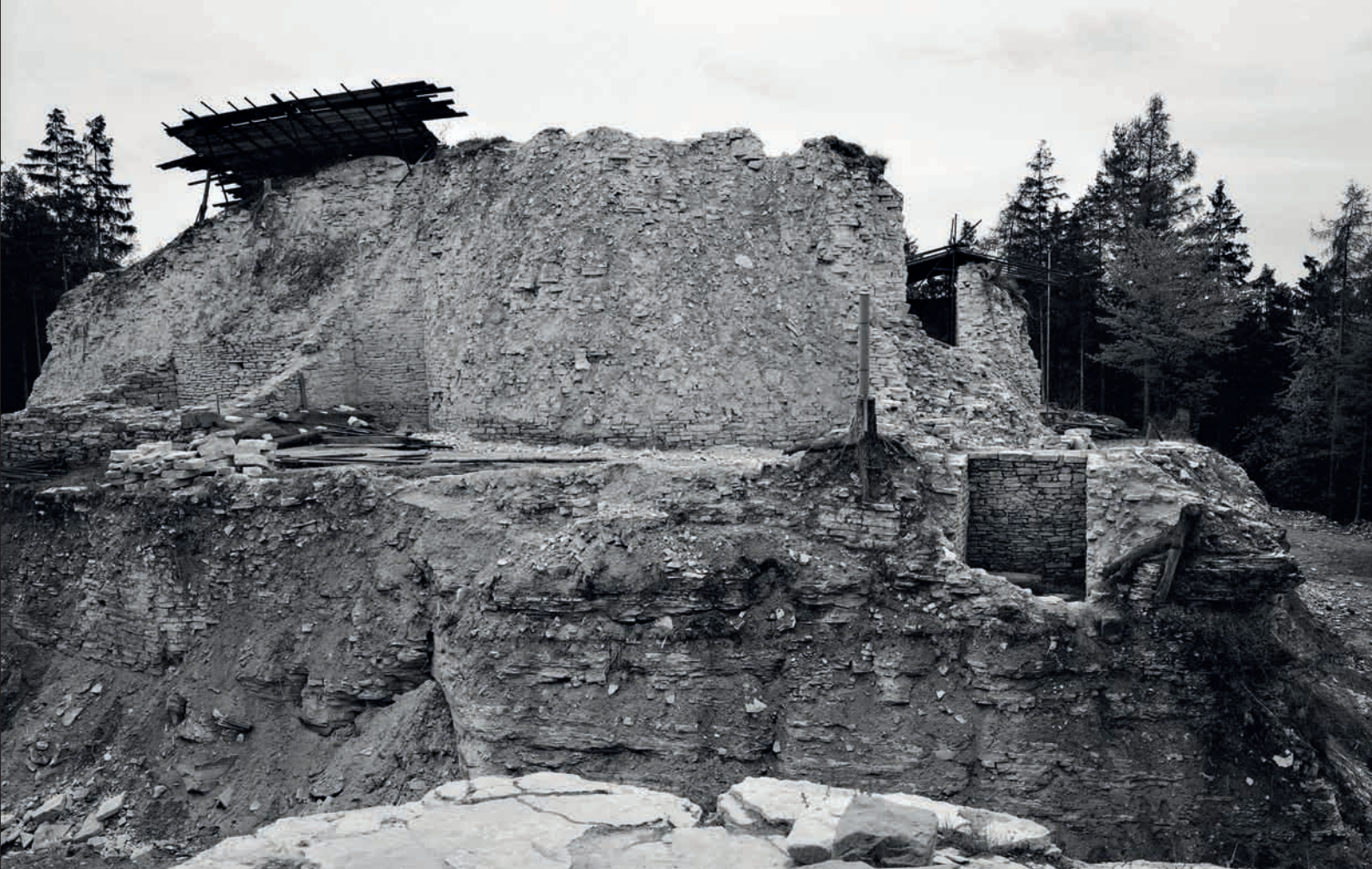
Obr. 35: Pohled na jádro hradu od první brány z doby těsně po ukončení archeologického výzkumu. Vpravo „vlčí jáma“ druhé brány, uprostřed hmota věže. I když její lícové zdivo téměř beze zbytku zaniklo a dosahuje jen sotva třetiny původní výšky, věž nezapře svou někdejší mohutnost a dominantní úlohu. Pod druhou branou obnažená skála, vlevo zbytky parkánové zdi (snímek z archivu NPÚ ÚP).
