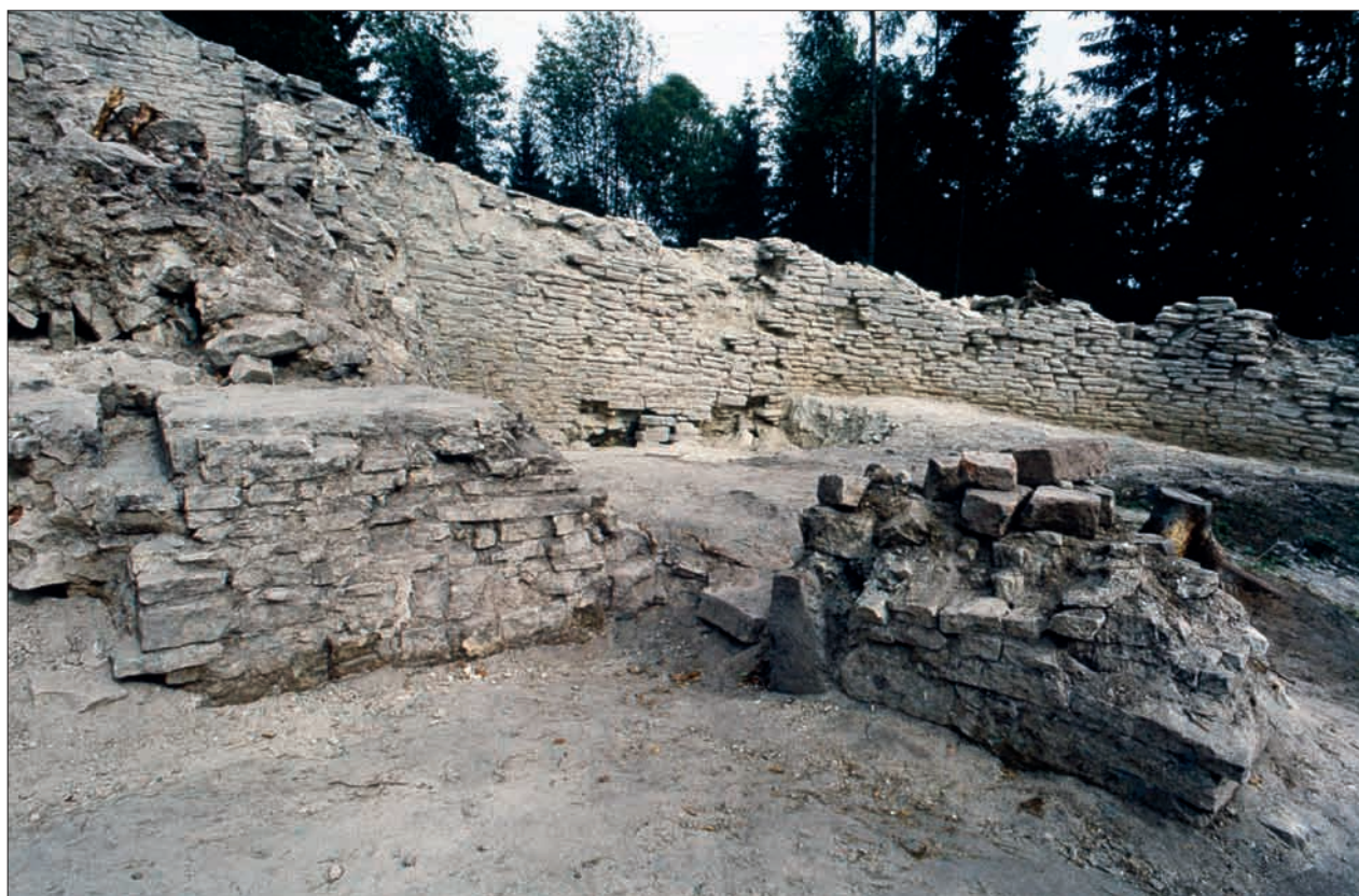
Obr. 129: Pohled z prostoru nádvoří, ještě zaplněného sutí, směrem k sv. části sektoru F. Uprostřed relikt vstupu do severní místnosti 1. patra s pravou stojkou ostění (srov. obr. 127); snímek z archivu autora, asi 1975).
