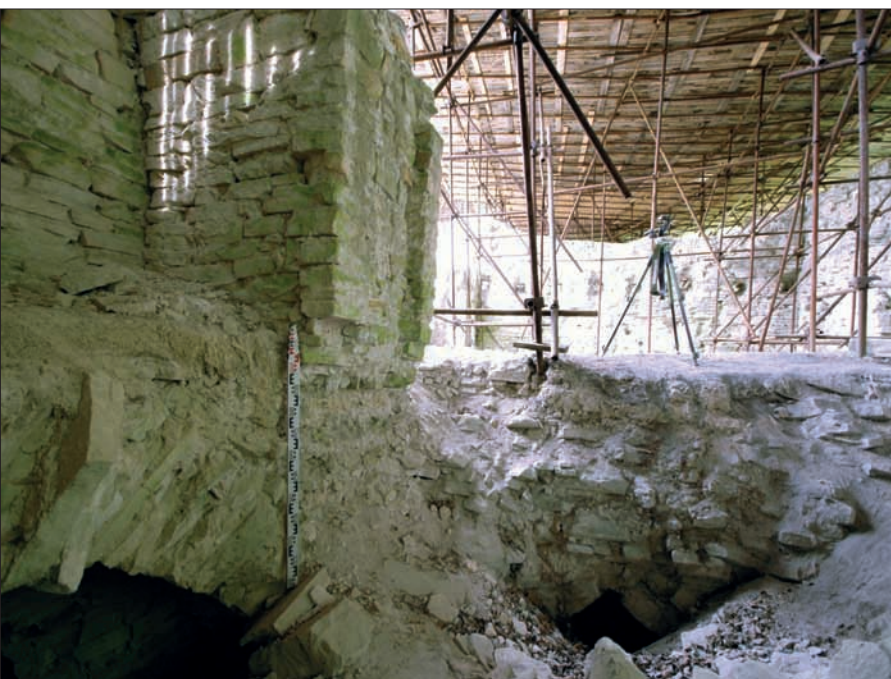
Obr. 97: Současný pohled z povrchu destrukce klenby sklepa sektoru C k severu (srov. obr. 96). Vlevo nad klenbou sz. roh místnosti ve vyvýšeném přízemí, se špaletou průchodu do sektoru D. Dole je patrný způsob založení zdi s průchodem (srov. obr. 98). Dole uprostřed otvor obnažující vrchol průchodu mezi sklepy (snímek Václav Tutr, 2006).
