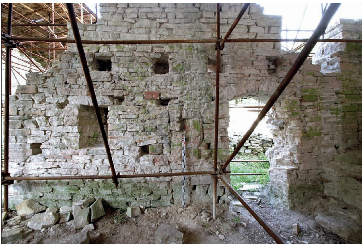
Obr. 160: Vnitřní strana nádvoří zdi západního křídla s vchodem a severním okénkem. Mezi nimi svíslá stavební spára, vpravo od geodetické latě nároží špalety zazděného okénka (srov. obr. 149) starší fáze (snímek Václav Tutr, 2006).
