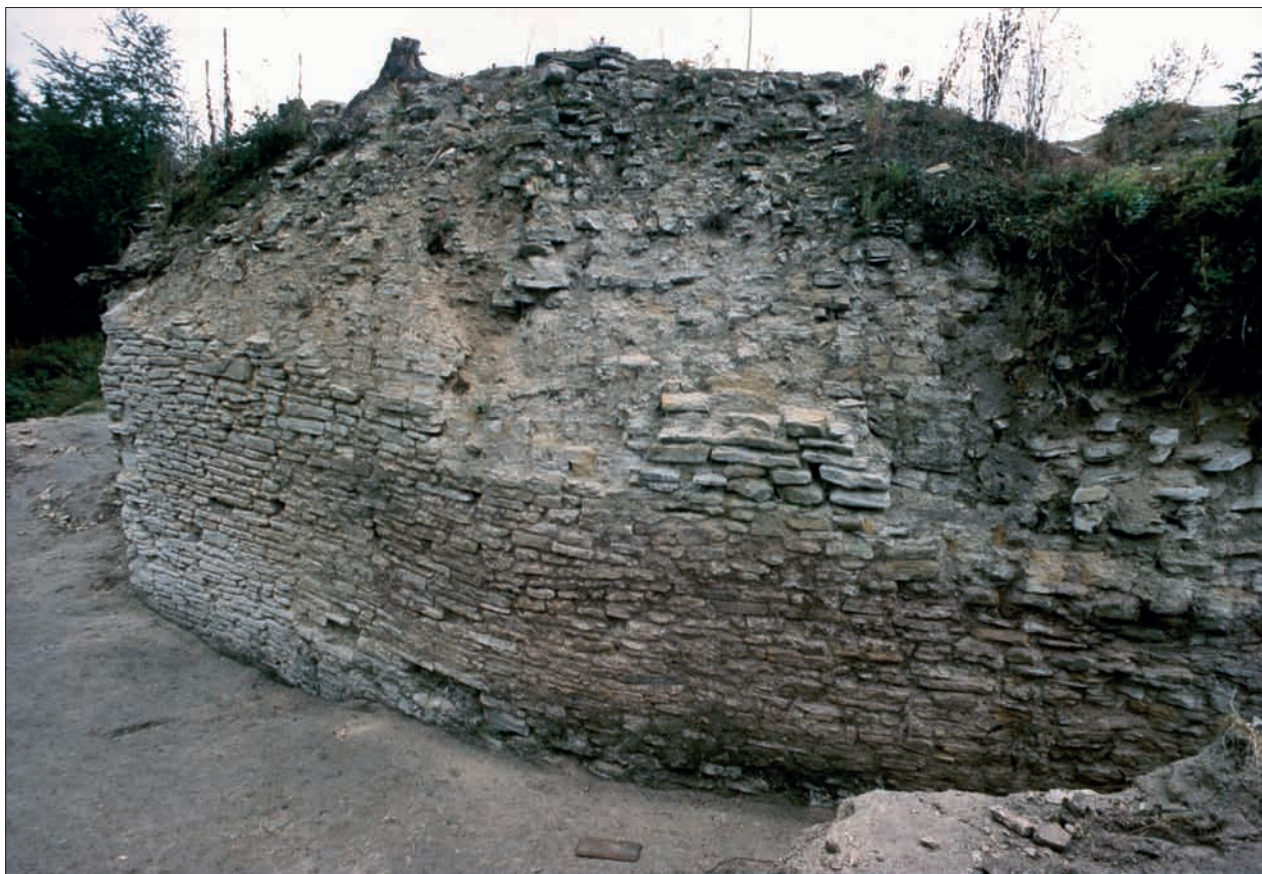
Obr. 59: Část vnějšího líce obvodové hradby na sv. straně hradu, s typickou strukturou plochých pískovcových kamenů (snímek z archivu autora, asi 1980).
