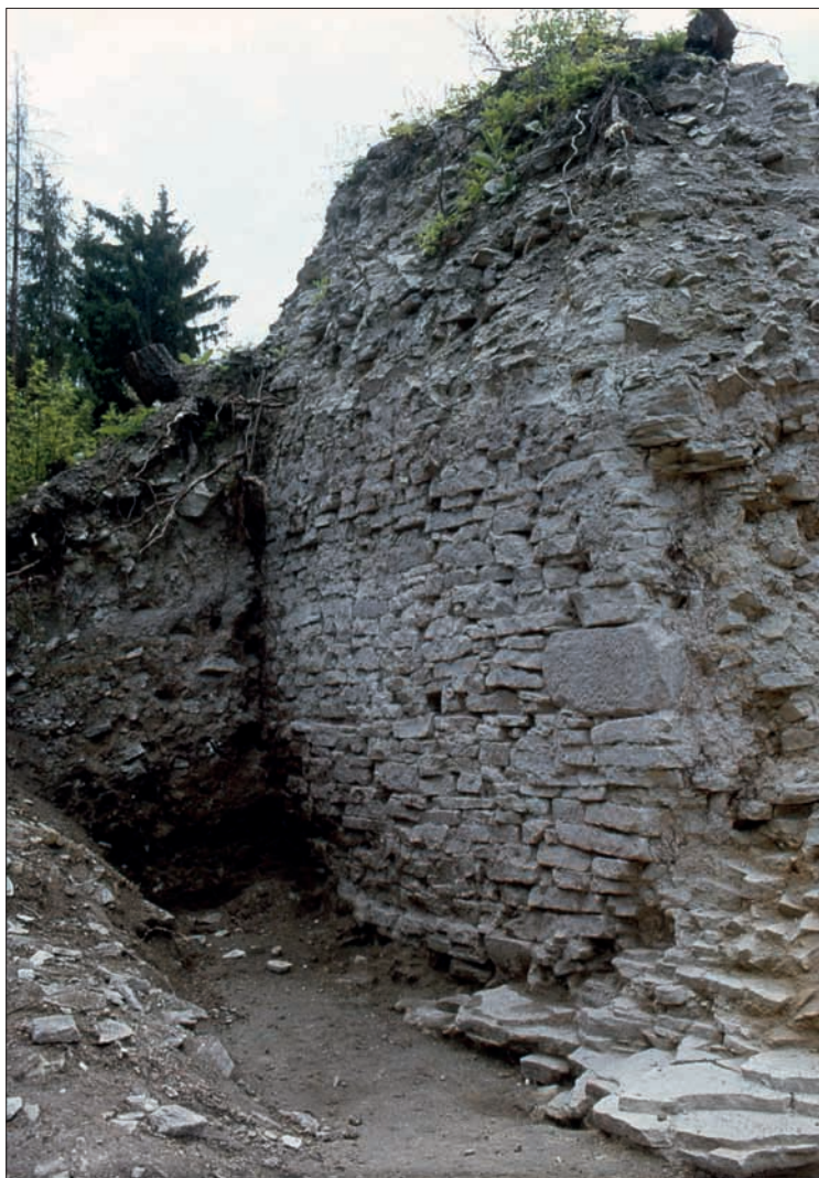
Obr. 219: Podobný záběr (srov. obr. 218) v pokročilejší fázi archeologického výzkumu. Hradba je zjevně založena na rostlé skále nízko v příkopu (vpravo dole). Opracovaný kámen na hraně líce snad naznačuje existenci blíže neznámého prvku (otvoru?) v sousedství (snímek z archivu autora, asi 1981).
