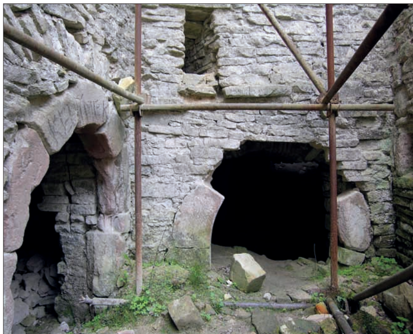
Obr. 79: Portálky ke sklepům sektorů B a D. Nahoře uvnitř zaslepený průduch do sklepa sektoru C, pod ním vystupují vodorovné kameny, patrně pozůstatek zastřešení šje (snímek autor, 2006).
