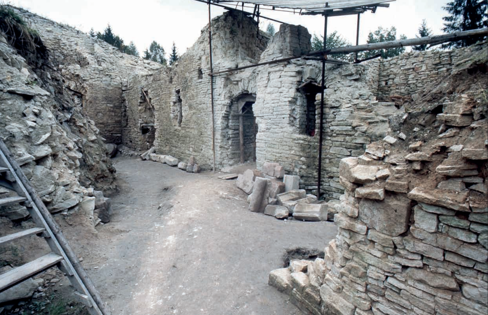
Obr. 114: Nádvoří průčelí východního křídla, zcela uvolněné ze závalu nádvoří. Vpravo v popředí zídka nad sestupem ke sklepům (snímek z archivu autora, asi 1977).
