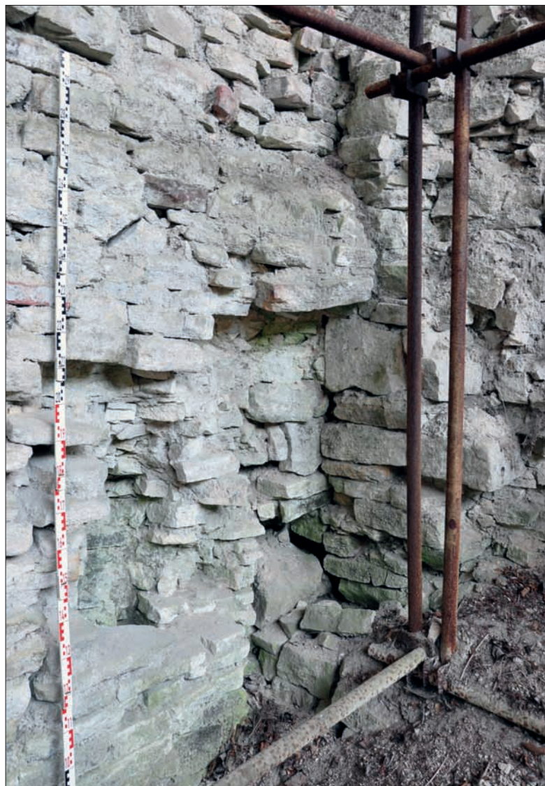
Obr. 124: Detail jihovýchodního rohu místnosti sektoru E. V pozadí fragment originálního líce jižní zdi prostory, před něj předstupuje druhotná vysprávka (?) hradby. Vlevo dole svislý negativ dřevěné výztuže (snímek autor, 2012).
