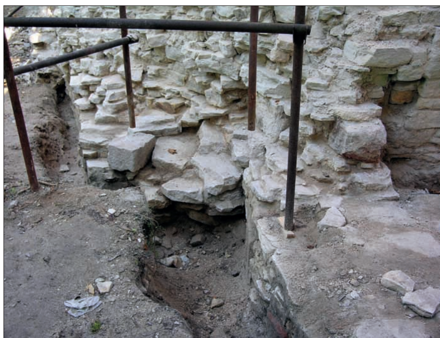
Obr. 199: Detail brány během rekonstrukce, pohled od jihu. Vpravo v popředí zdivo pod odstraněným prahem, vlevo na konci vykopané rýhy zdivo předstupující do parkánu (srov. obr. 197 a 198; snímek autor, 23. 9. 2006).
