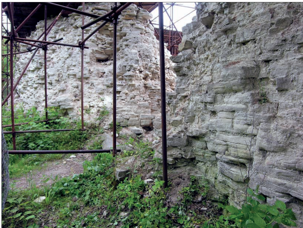
Obr. 33: Brána je nejvýrazněji rekonstruovanou částí jádra hradu v době od ukončení archeologického výzkumu. Na místě vnějšího portálu, silně postiženém dlouhodobým rozpadem, vznikl novotvar; sledující pouze možnost osadit zde pevná dubová vrata (pohled od jihozápadu, vlevo stav v květnu 2006, vpravo v prosinci 2006, snímky autor).
