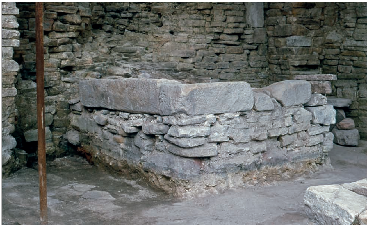
Obr. 166: Těleso topeniště při severní stěně kuchyně, pohled od jz. (snímek z archivu autora, asi 1980).
