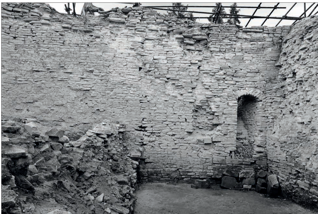
Obr. 131: Jižní místnost sektoru F koncem výzkumu, pohled k východu. Vlevo zbytky dělicí zdi, jejíž otisk je velmi dobře patrný na lici obvodové hradby v pozadí (snímek z archivu autora, asi 1981).
