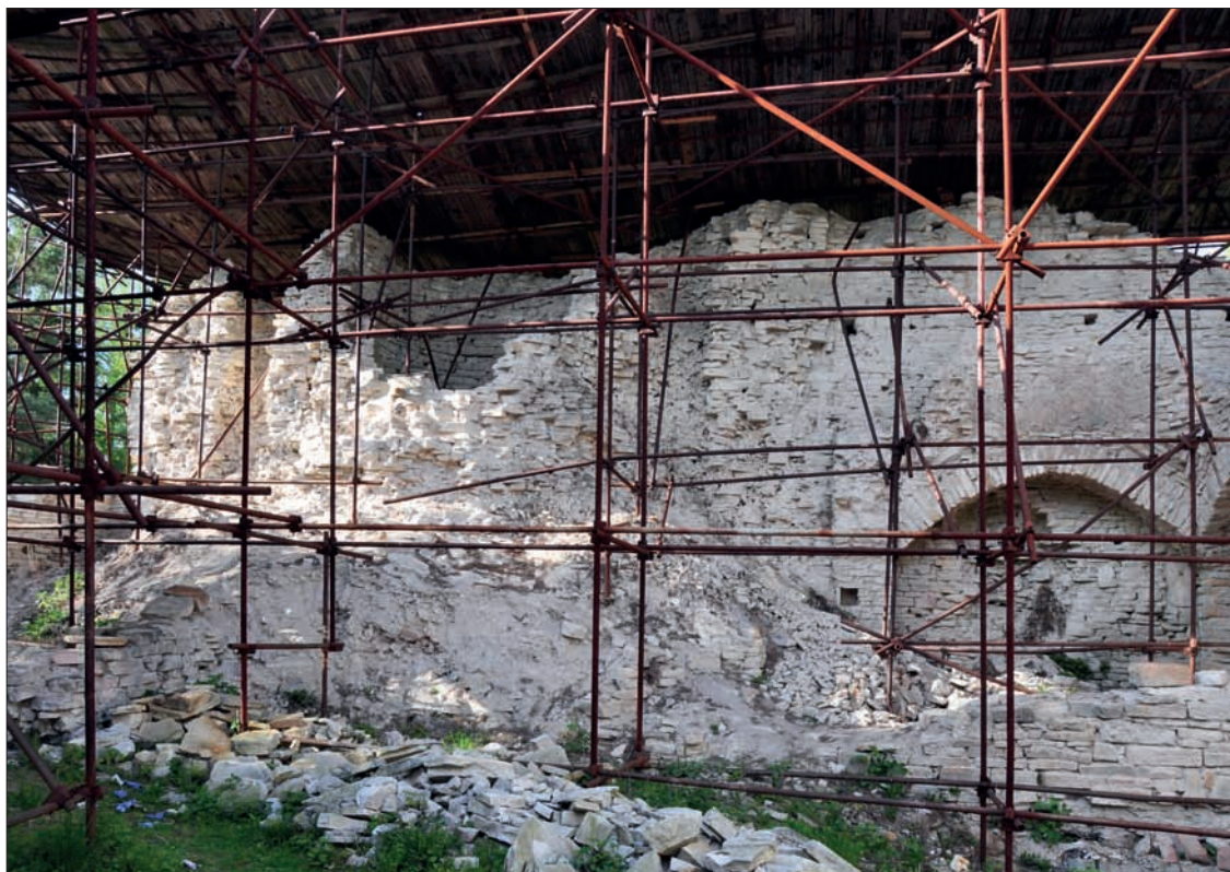
Obr. 46: Dnešní pohled na věž z nádvoří. Dobře je patrné její oddělení spárou od kuchyně (resp. obvodové hradby), jádro zdiva kolem vnitřního pláště a po stranách kaverny vzniklé úbytkem vnitřní výplně zdiva (snímek autor, 2012).
