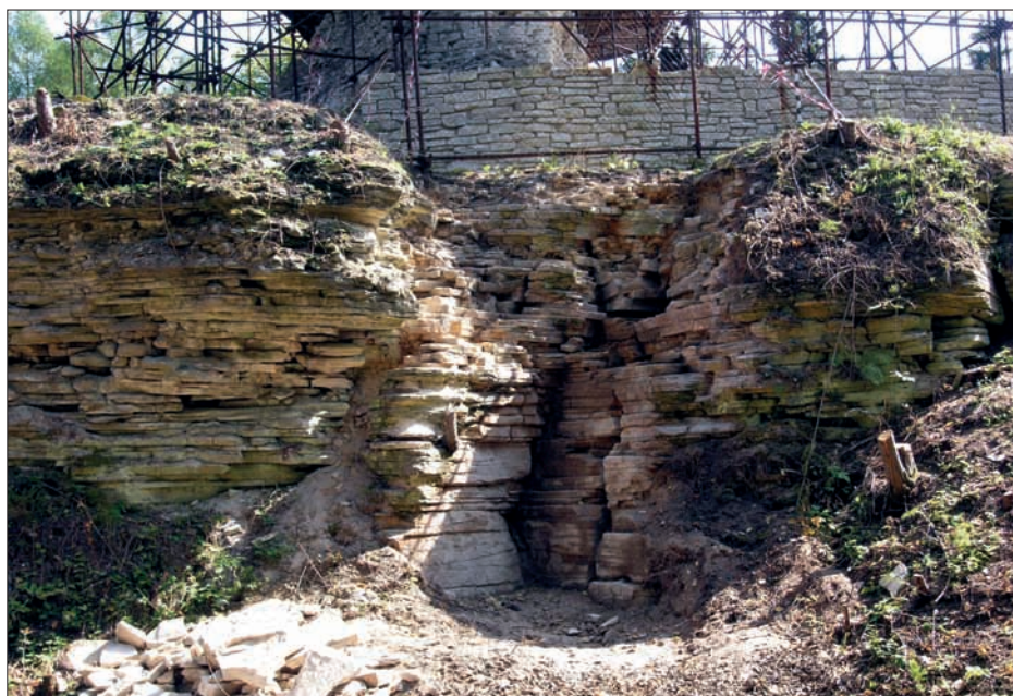
Obr. 36: Detail struktury skalního suku, na němž stojí hradní jádro (nahore v pozadí věž a před ní rekonstruovaný úsek západní části hradby). Křehká, deskovitě odlučná pískovcová skála zde byla natolik narušena, že ji bylo nutno následně vyspravit pomocí úseku zdiva s vynášecím pasem (stav před rekonstrukcí, snímek autor, 2008).
