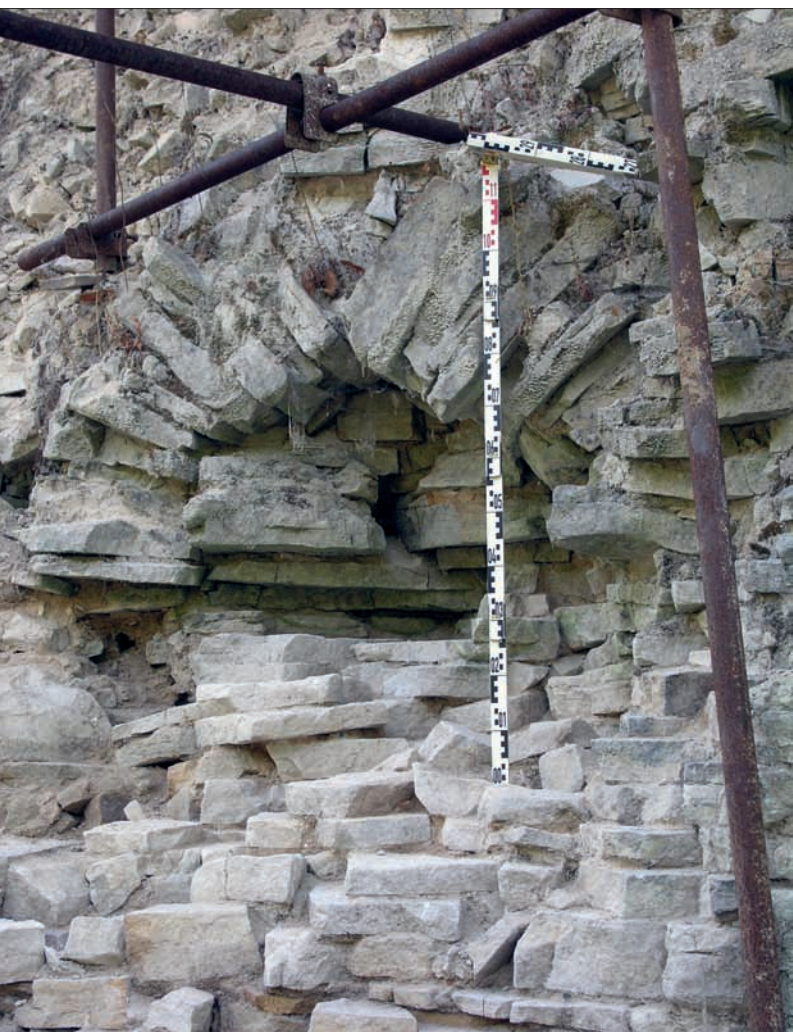
Obr. 51: Dva detailní pohledy (srov. obr. 48) na odlehčovací klenbičku (snímky autor, 2008).
