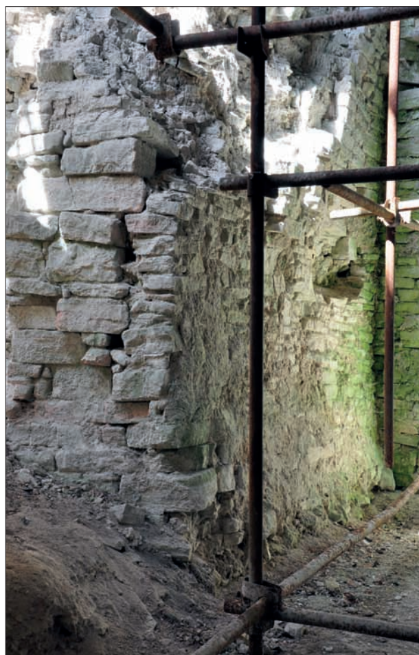
Obr. 142: Šikmý pohled od jihovýchodu na úsek zdi mezi vchodem ze severní místnosti sektoru F do kuchyně (špaleta v popředí) a obvodovou hradbou (v pozadí). Konkávní prohnutí líce, rozdíly v jeho struktuře a některé další anomálie (srov. též obr. 138 a 139) prozrazují složitější nálezovou situaci, kterou však dnes nelze spolehlivě vyhodnotit (snímek autor, 2012).
