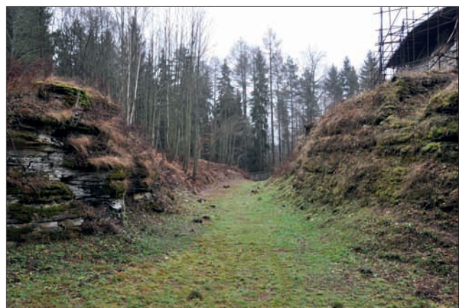
Obr. 221: Takřka stejný záběr (srov. obr. 220), současný stav (snímek autor, 2011).
