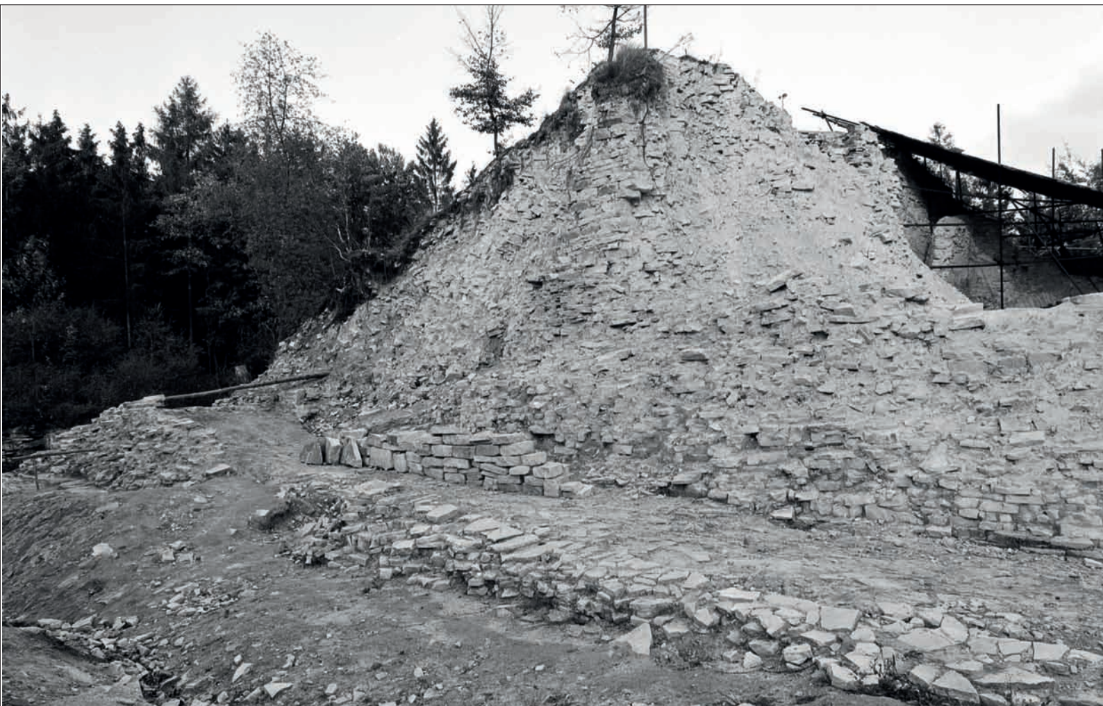
Obr. 211: Severní část západního parkánu v pohledu od jz. V popředí zbytky parkánové zdi, v pozadí věž s reliktem vnějšího pláště, vlevo druhá brána (snímek z archivu autora, asi 1981).
