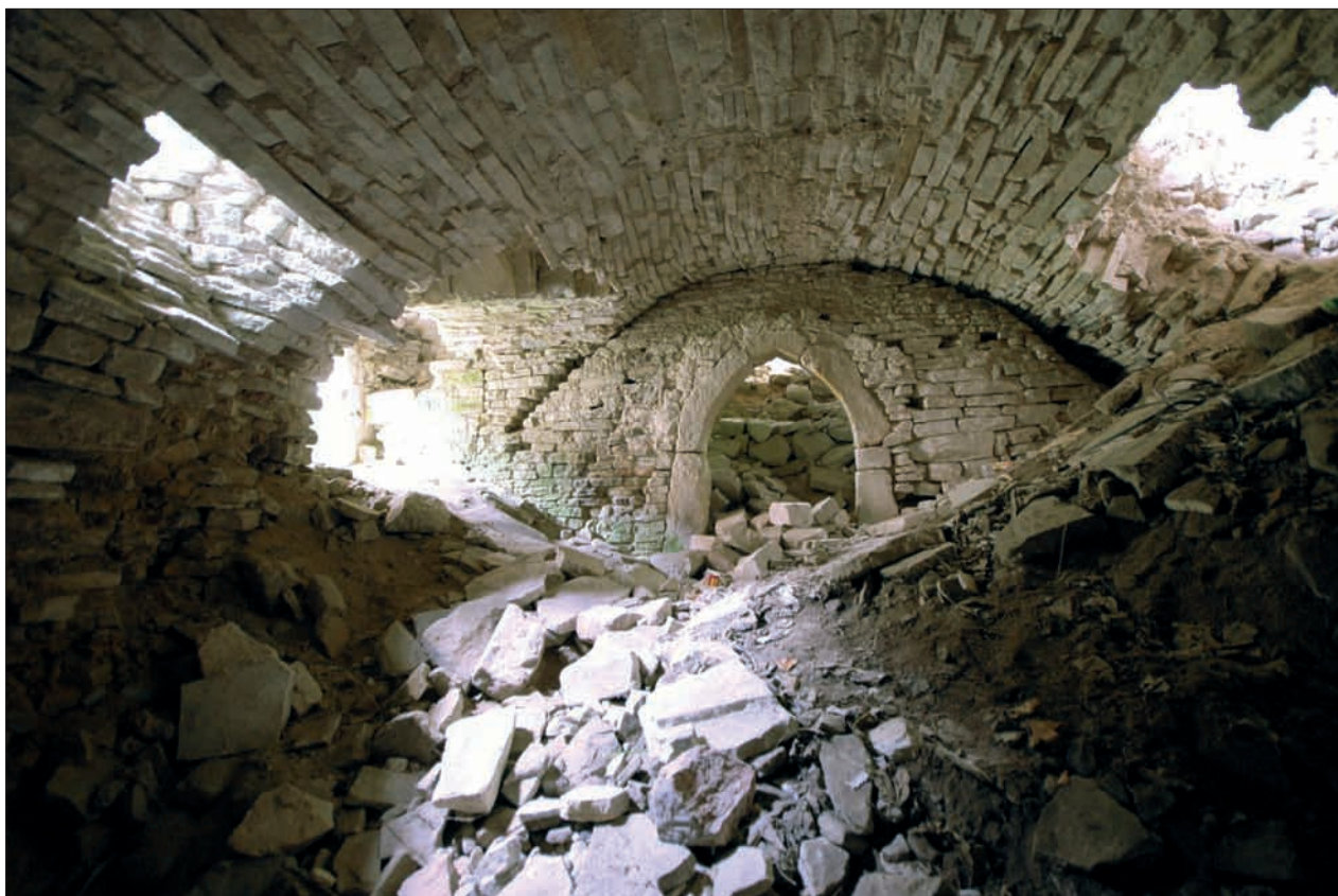
Obr. 73: Sklep pod jižní síní B, pohled k východu. Vlevo průduch a vstup z nádvoří, v čele portál do sklepa sektoru C, vpravo novodobý průraz klenbou (snímek Václav Tutr, 2006).
