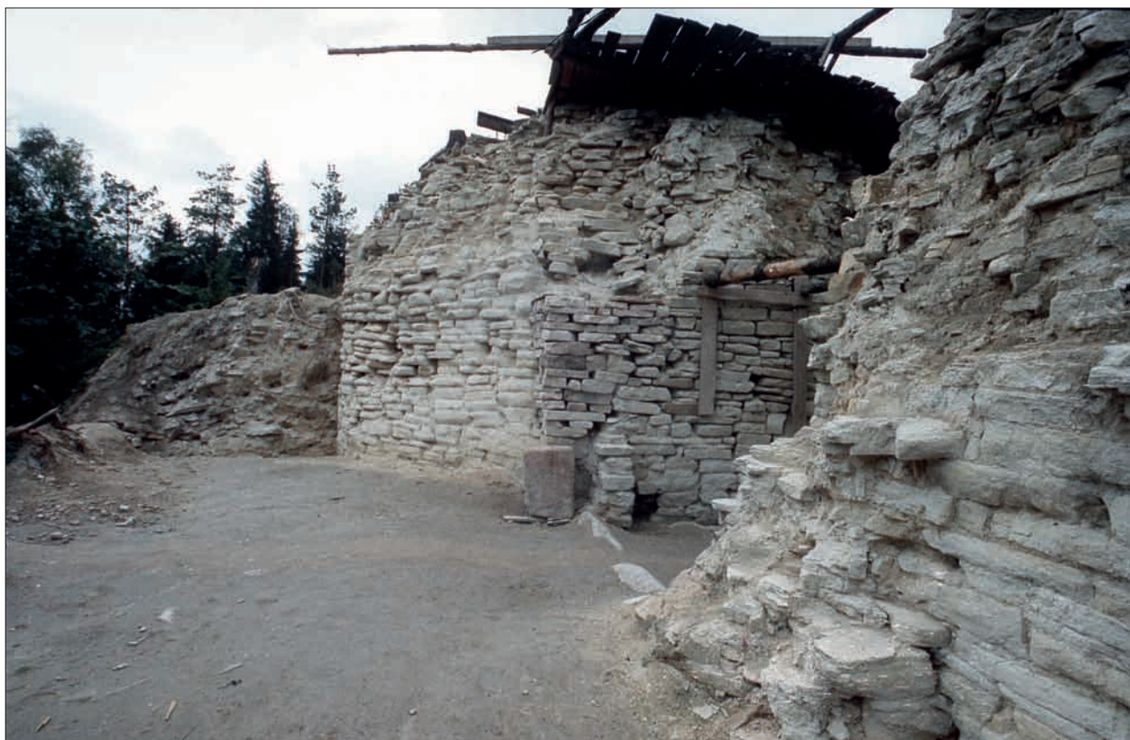
Obr. 190: Podobný záběr (srov. obr. 189), ale z poněkud jiného úhlu a v již pokročilejší fázi uvolňování západního parkánu ze sutě. Severní stěna brány se mezitím z větší části zřítla a byla nahrazena „na sucho“ kladenou plentou, která měla zabránit další destrukci (snímek z archivu autora, asi 1979).
