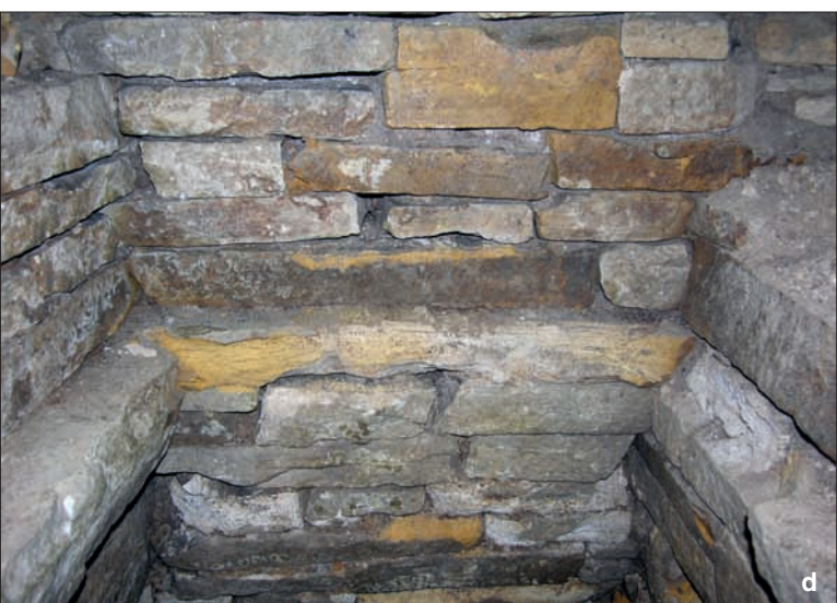
Obr. 56: Detailní pohledy do interiéru skrýše ve zdivu věže (snímky autor, 2006): a – dolní část šachty v pohledu shora, na obvodu různou měrou olámaná, 9 cm široká římsa pro uložení krycí desky; římsa byla na třech stranách, na straně k přístupové chodbičce (na snímku dole) chyběla; b – pohled na strop šachty (zcela vlevo) a stupňovité zastropení přístupové chodbičky (zcela vpravo překlad vstupu z přízemí věže); c – pohled na zadní stěnu horní části šachty (naproti přístupové chodbičce), dole olámaná římsa pro uložení krycí desky; d – pohled na přechod mezi zadní stěnou horní a dolní části šachty (srov. c), uprostřed různou měrou olámané římsy; e – pohled na jz. stěnu horní části šachty (přístupová chodbička zleva, stěna je k chodbičce na spáru, se zadní stěnou je provázána – nejde o stavební fáze, ale o stavební postup).
