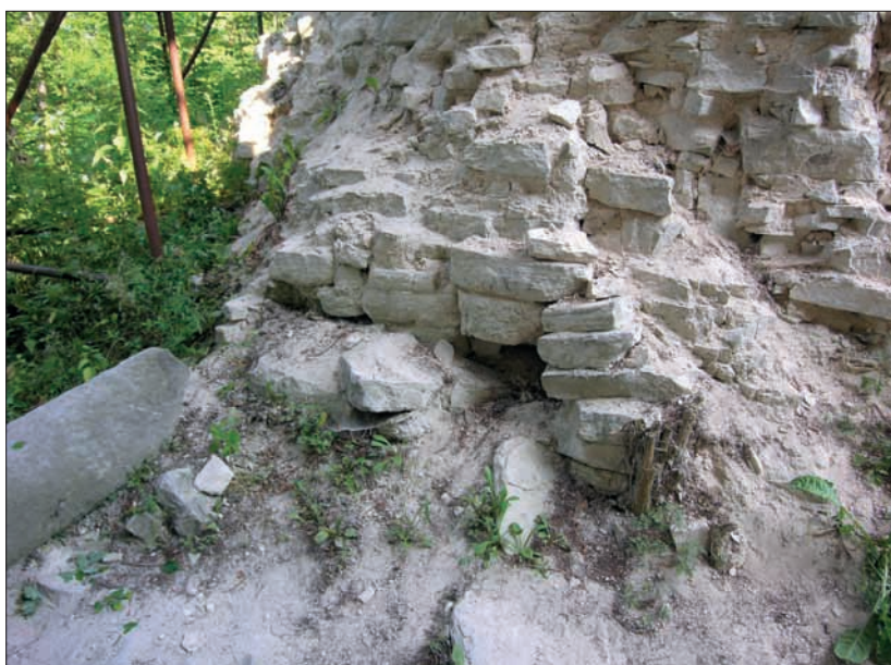
Obr. 196: Detail severního konce prahu s přilehlým zdivem stěny brány před rekonstrukcí (snímek autor, 2006).
