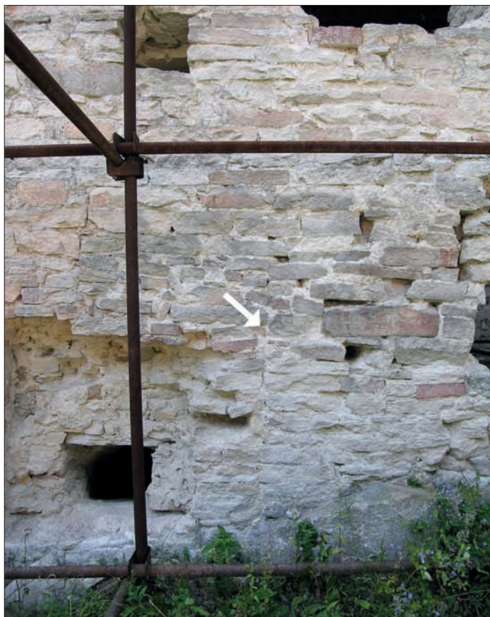
Obr. 148: Nádvoří průčelí západního křídla, detail střední části se svislou spárou (uprostřed, upřesněno šipkou), jež je stopou staršího vchodu, vlevo okénko ze sklepa (snímek autor, 2006).
