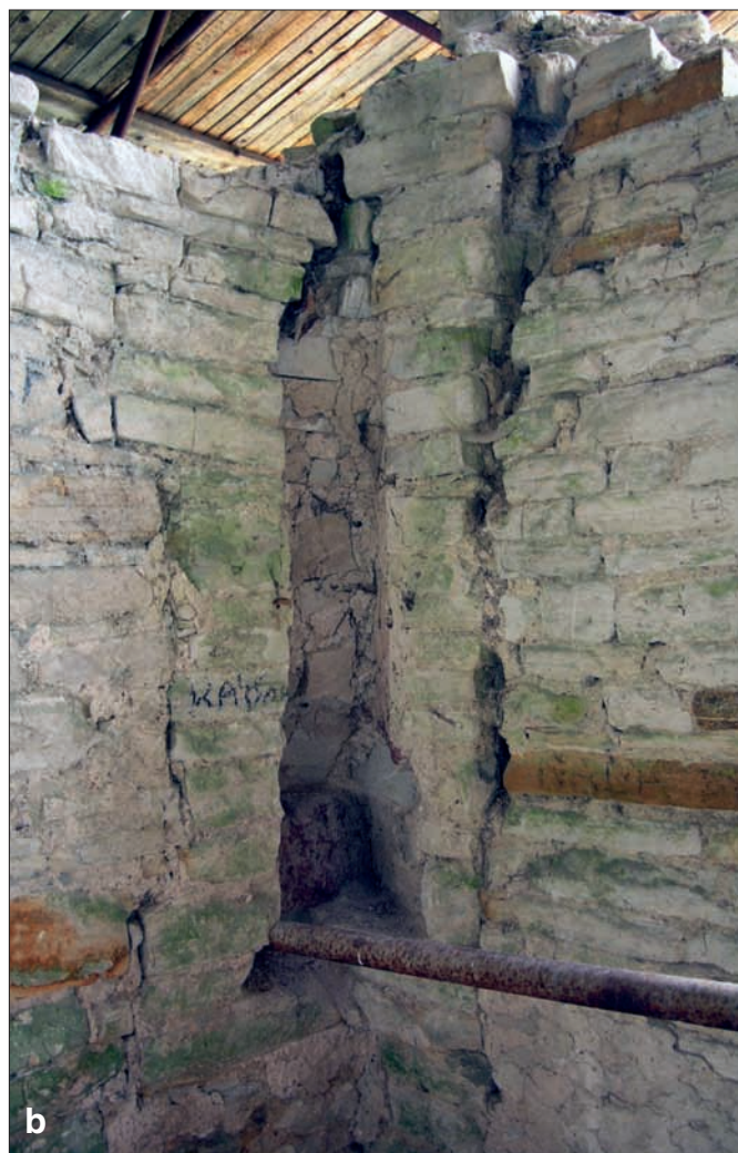
Obr. 90: Jizvy po vytrhaných konzolách síně B (a – mezuklenební na jižní straně – srov. obr. 88/a; b – sz. koutová – srov. obr. 88/c). Postranní spáry ve zdivu (obsahující úlomky červeného pískovce) prozrazují, že konzoly byly do hradby druhotně vloženy (snímky autor, 2012 a 2006).
