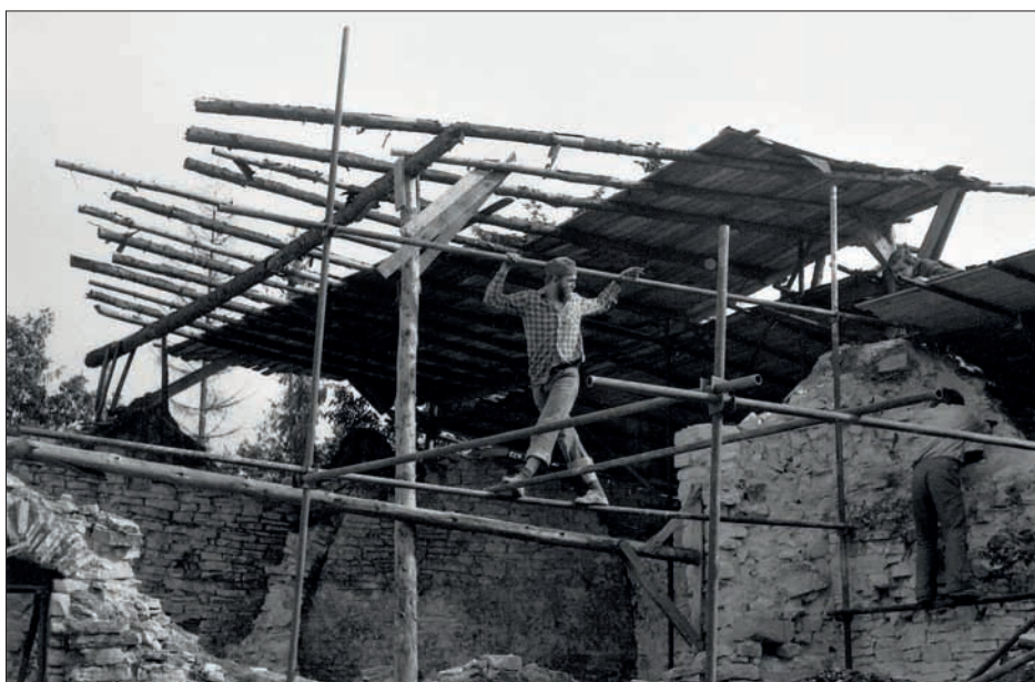
Obr. 28: V průběhu archeologického výzkumu probíhalo provizorní zastřešování obnažených částí zdiva převážně svépomocí samotnými brigádníky (snímek z archivu Jana Dobiáše).
