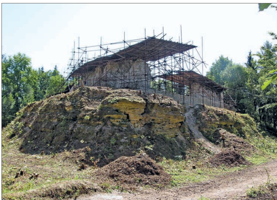
Obr. 3: Současná podoba jádra hradu v pohledu od severozápadu, s provizorním ochranným zastřešením (snímek autor, 2008, stav před sanací skály západního parkánu).
