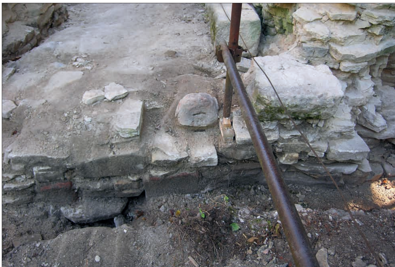
Obr. 201: Detail spodní části brány po odstranění prahu, pohled z parkánu, nahoře severní, dole jižní část, záběry se výrazně překrývají. Ve vrstvě zdiva pod prahem se vyskytuje několik kusů červeného pískovce, zřejmě druhotně použitých. Toto zdivo spolu s reliktem pilířku (horní snímek zcela vlevo), jehož součástí musela být zmišlená stojka ostění, je na spáru připojeno k lici hradby. Vpravo (dolní obr.) relikť jižního pilířku, navazujícího na širší výběh zdiva (srov. obr. 195). Vlevo od tohoto pilířku vystupuje zaoblený kámen z červeného pískovce, jehož účel (stejně jako vztah k prahu) zůstává nejasný (snímky autor, 23. 9. 2006).
