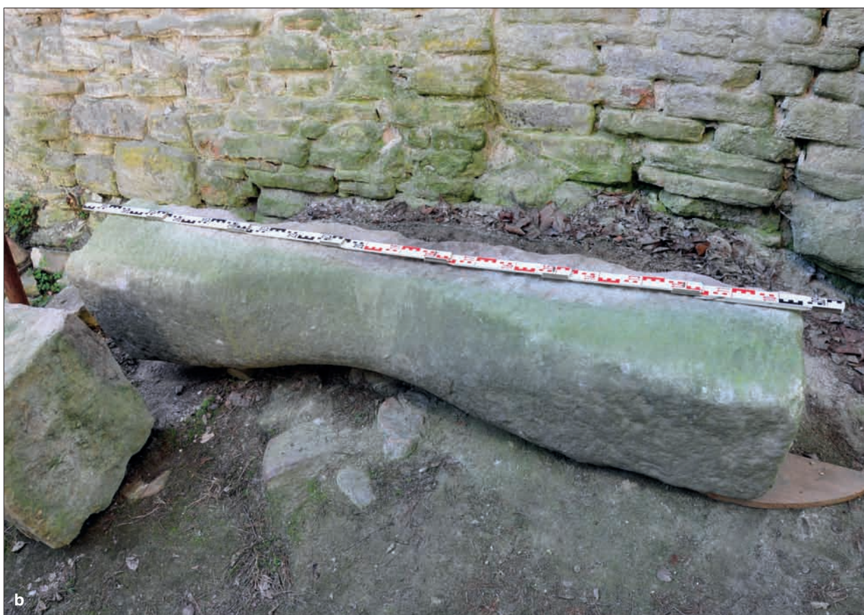
Obr. 200: Práh brány odstraněný při rekonstrukci z původního místa. a – uložení ve správné poloze, s dobře patrným opotřebením horní plochy a jedné z hran, b – uložení na boku, s opotřebením druhé hrany (snímky autor, 2012).
