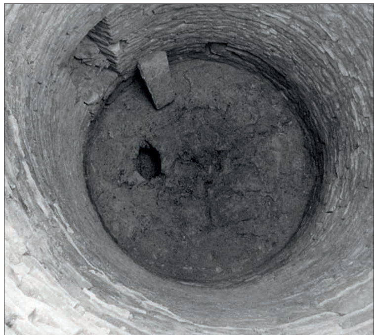
Obr. 50: Celkový pohled do interiéru přízemí věže po vybrání sutí. Vlevo nahoře vstup do skříže, upravo od něj stojí kamenný prvek neznámého původu. Charakter povrchu dna a otvoru v něm je nejasný (snímek z archivu autora, asi 1984).
