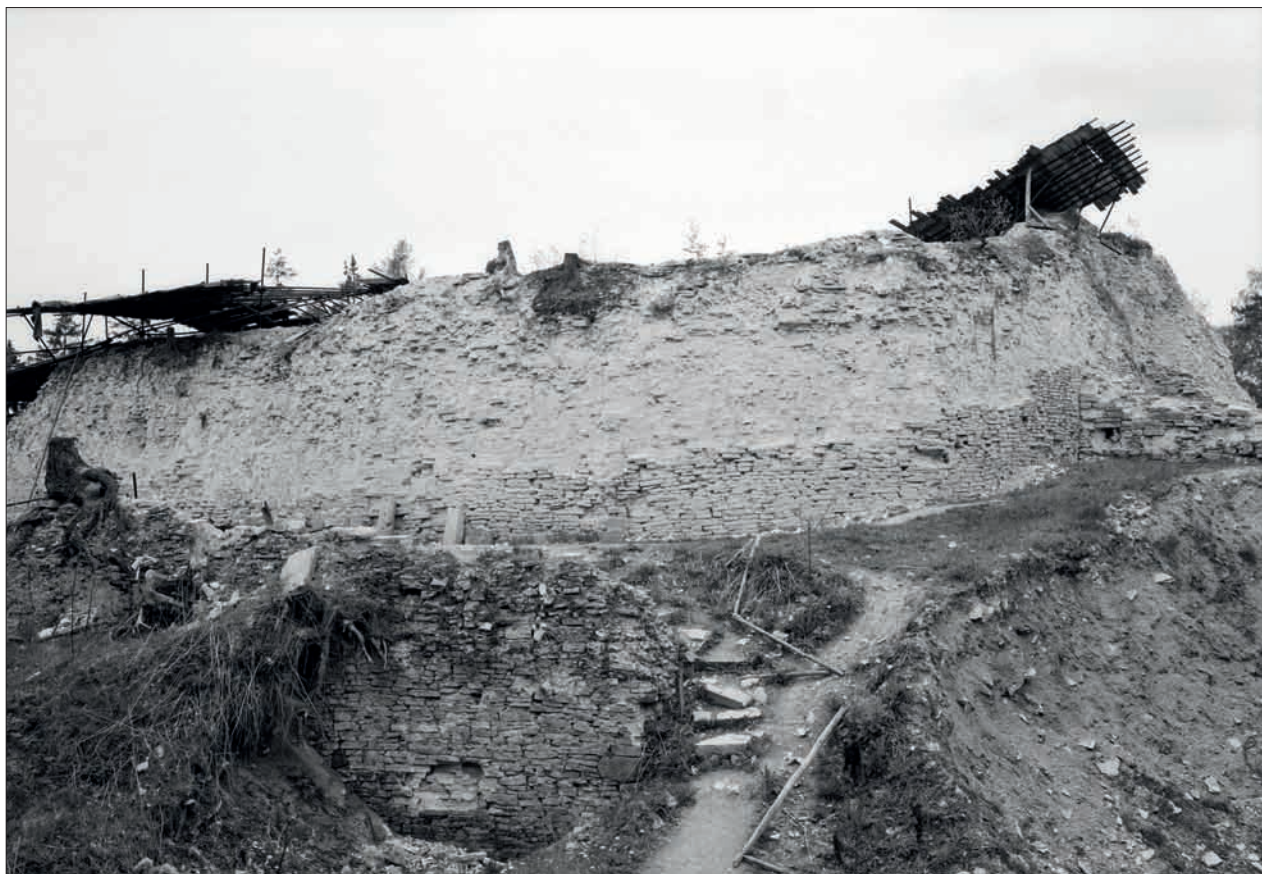
Obr. 61: Pohled z valu na východní až sv. část obvodové hradby (zcela vpravo tzv. kovárna), s dobře patrným rozsahem dochování původního líce (srov. obr. 58–60). V popředí parkánová zeď. Na korunách obou hradeb lze nalézt pařezy, které prozrazují úroveň terénu před zahájením archeologického výzkumu (snímek z archivu NPÚ ÚP, asi 1982).
