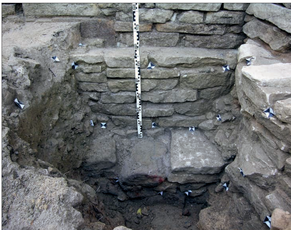
Obr. 68: Detail základové části věže (srov. obr. 48 a 67) s napojením základové části hradby. Pohled od západu (snímek autor, 2008).
