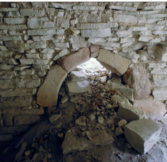
Obr. 78: Horní část portálu průchodu ze sklepa sektoru D do sklepa sektoru C. Pozoruhodné je nestandardní složení ostění z kusů různé velikosti, horniny a míry poškození (podobné anomálie se projevují také ve skladbě druhého sklepního portálu, srov. obr. 76), které může nasvědčovat druhotnému použití některých prvků (snímek Václav Tutr, 2006).
