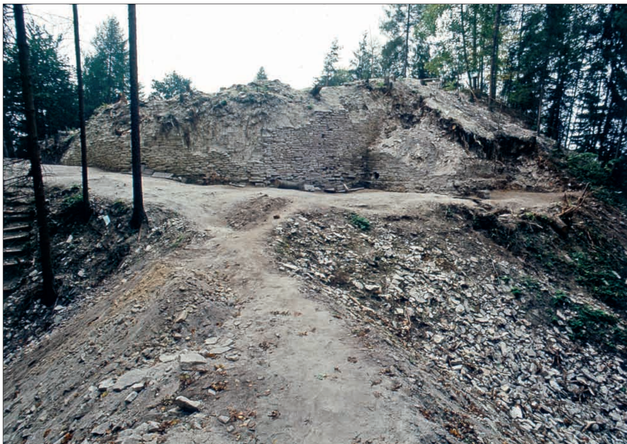
Obr. 58: Vnější líc obvodové hradby na severní až sv. straně hradu, vpravo tzv. kovárna před vybráním sutě v jejím interiéru. Líc hradby silně opadával v bezprostřední návaznosti na své obnažení (snímek z archivu autora, asi 1975).
