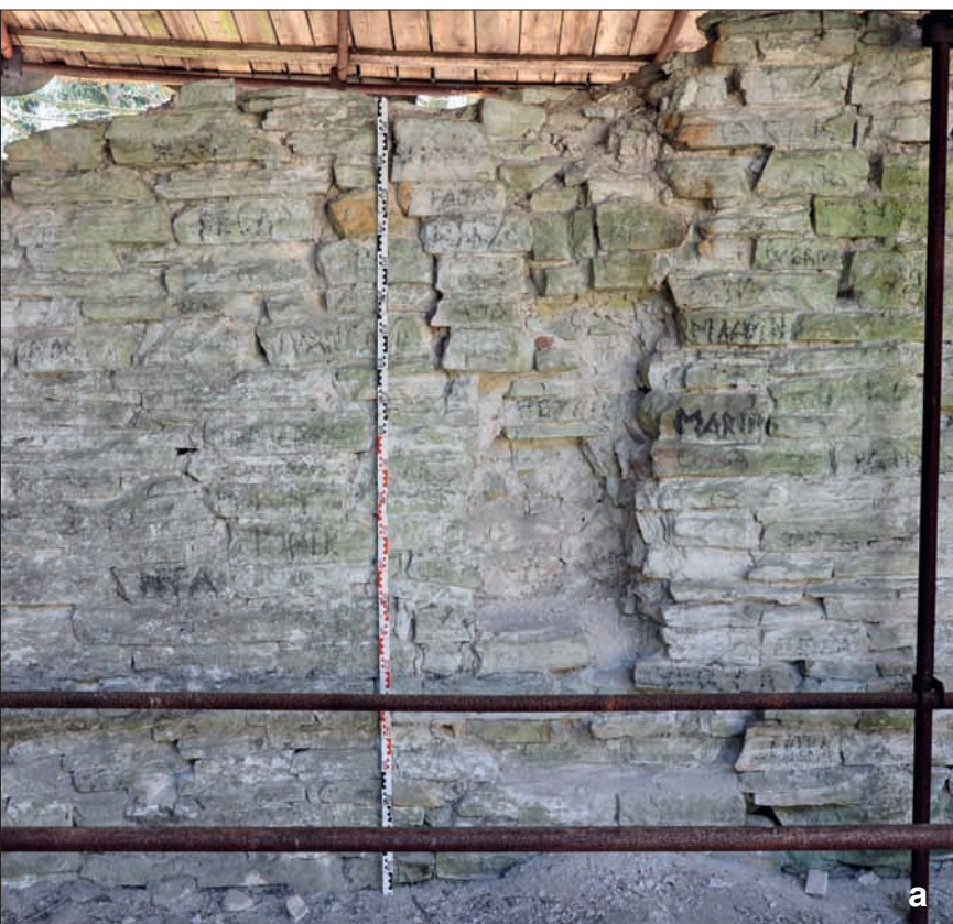
Obr. 90: Jizvy po vytrhaných konzolách síně B (a – mezuklenební na jižní straně – srov. obr. 88/a; b – sz. koutová – srov. obr. 88/c). Postranní spáry ve zdivu (obsahující úlomky červeného pískovce) prozrazují, že konzoly byly do hradby druhotně vloženy (snímky autor, 2012 a 2006).
