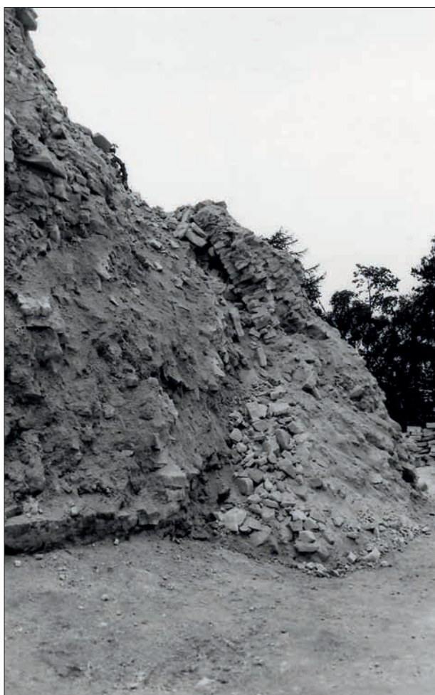
Obr. 44: Pohled ze severního parkánu na severní až sz. stranu obvodu věže (návaznost na snímek 45). Vnější plášť zdiva se zde nedochoval, pozoruhodný je však detail nahoře uprostřed. Není to pouhá suť, ale vcelku držící blok zdiva, který sjel odněkud z vyšších partií věže. Lze rozeznat svislý, rovně probíhající líc, který se původně uplatňoval v interiéru věže. Jeho pečlivé provedení nenasvědčuje tomu, že by vymezoval „sypané jádro“ zdiva, spíše je fragmentem vnitřního pláště, případně chodbičky nebo jiného vnitřního prostoru v mohutné mase zdiva věže (snímek ARÚ Praha, asi 1982).
