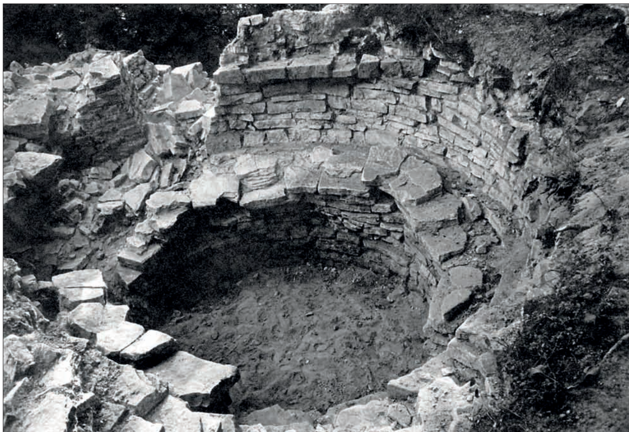
Obr. 52: Interiér věže v pohledu k sz. Nad výplní suti vnitřní plášť zdíva přízemí, nad ním zbytky náběhu kupolové klenby, výše pruh lice mezi rubem klenby a podlahou 1. patra. Zcela nahoře vystupuje několik kamenů, které jsou pozůstatkem podlahy, jež ležela na zásypu klenby přízemí (tyto kameny odpadly již v průběhu archeologického výzkumu). V levém horním rohu snímku je patrný fragment líčované špalety, která byla původně ve vyšší úrovni. Její smysl nelze přesně stanovit. V úvahu přichází vstup z 1. patra do schodiště v síle zdi či do prevetu, méně pravděpodobně (vzhledem ke konkrétní poloze) vstup z exteriéru (snímek z archivu autora, 1973–1974).
