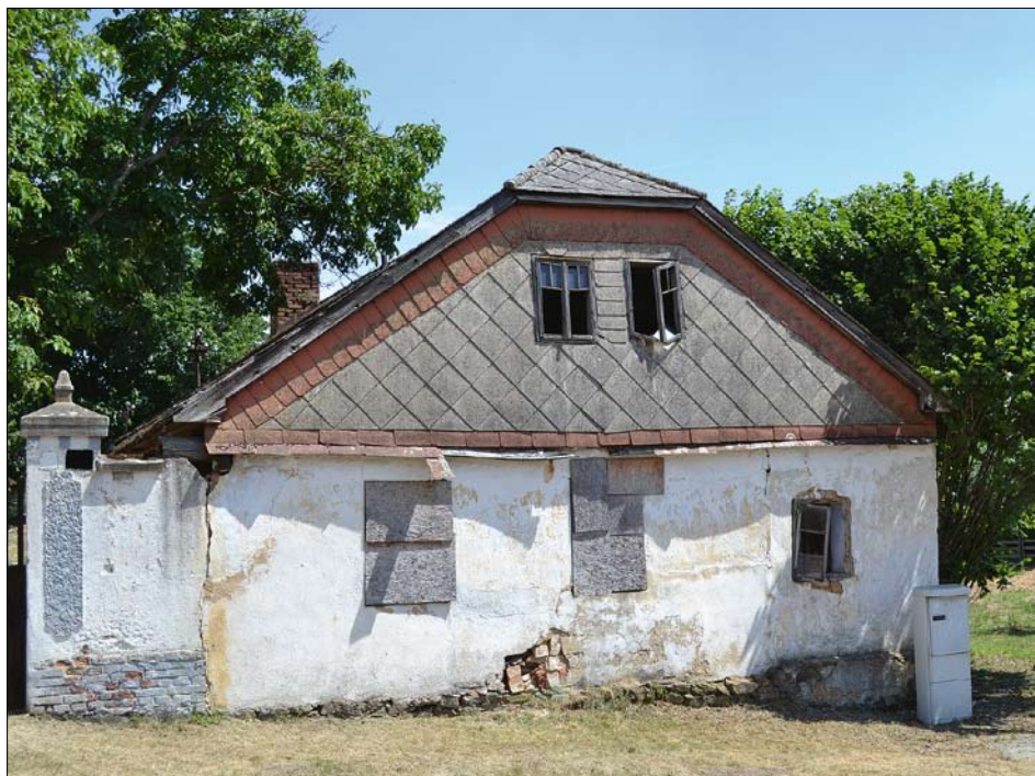
Obr. 17: Lisov (okres Plzeň-jih) – usedlost čp. 16, obytné stavení, pohled od západu, stav v červenci 2013.
