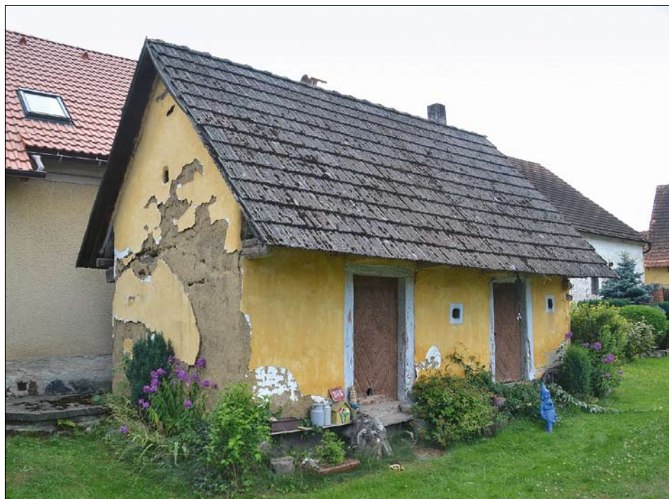
Obr. 7: Malinec (okres Plzeň-jih) – sýpka u čp. 21, pohled od severovýchodu, stav v červenci 2018.
