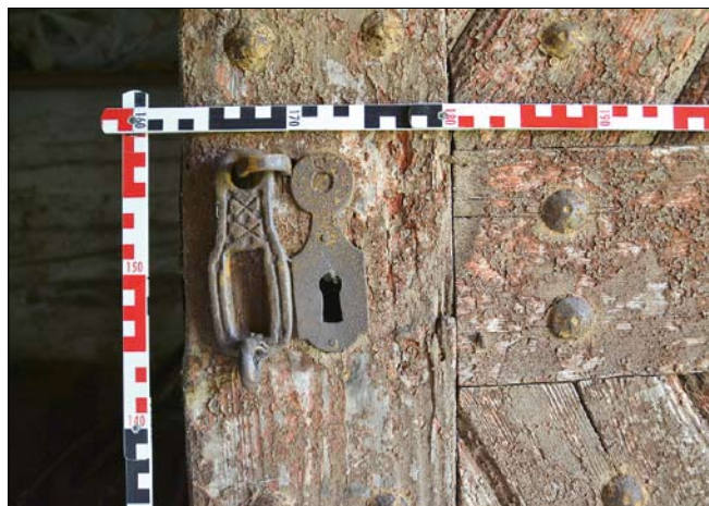
Obr. 10: Malinec – sýpka u čp. 21, dveře sýpky, detail kované petlice, klíčového štítku a zdobených hlav hřebů, stav v červenci 2018.
