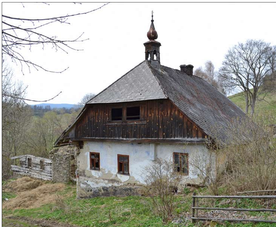
Obr. 13: Kavrlík (okres Klatovy) – usedlost čp. 2, obytné stavení, pohled od východu, stav v dubnu 2012.
