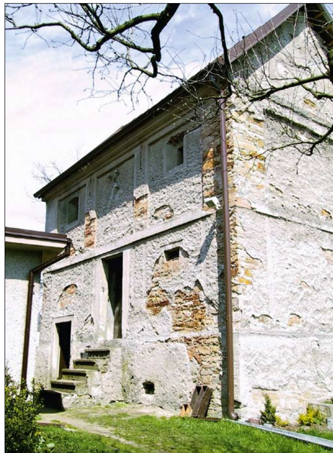
Obr. 9: Křivice, čp. 32, nádvorní strana špýcháru (foto NPÚ, ÚOP v Josefově, P. Arjčuk, 2001).
