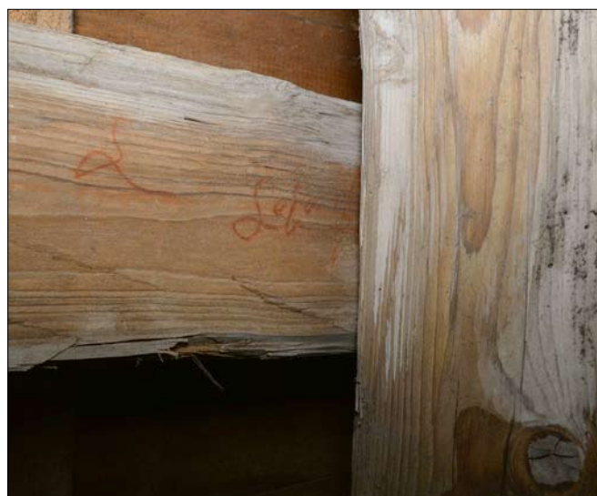
Obr. 15: Miličín, kostel Narození Panny Marie, krov nad presbytářem, rudkový datační nápis na spodním líci severní krokve vazby č. 7, překrytý z větší části rozpěrou a ramenem ondřejského kříže. V mezeře mezi prvky lze na místě přechíst ještě slovo „Páně“, letopočet však již nikoliv.
