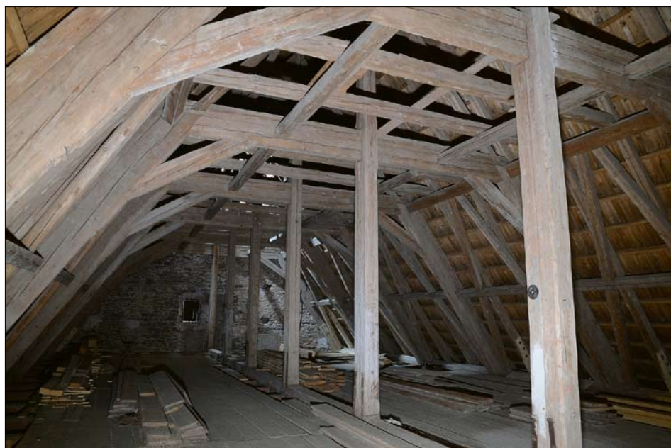
Obr. 17: Miličín, kostel Narození Panny Marie, krov nad lodí, pohled od jihovýchodu.
