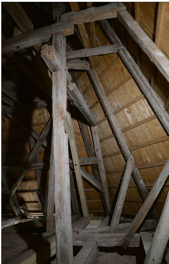
Obr. 9: Miličín, kostel Narození Panny Marie, krov nad presbytářem, pohled od jihu na sloupek druhotně redukované plné vazby č. 10. Patrné je zkrácení příčné rozpěry ležaté stolice a prvky zvalbení nad závěrem. Zřetelné jsou nepřesnosti ve spojích patních vzpěr s nárožními krokvi.
