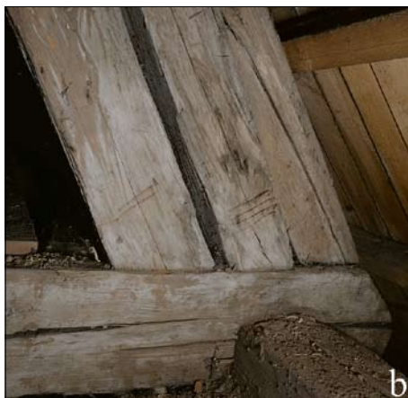
Obr. 6: Miličín, kostel Narození Panny Marie, krov nad presbytářem, detaily pat plných vazeb; a – jižní pata vazby č. 7 se zvláštní úpravou zhlaví vazného trámu pro zadrápnutí krátčete; sloupek plné vazby nese piktogram podobající se řeckému písmenu gama; b – severní strana vazby č. 4, sloupek nese římskou číslici II.
