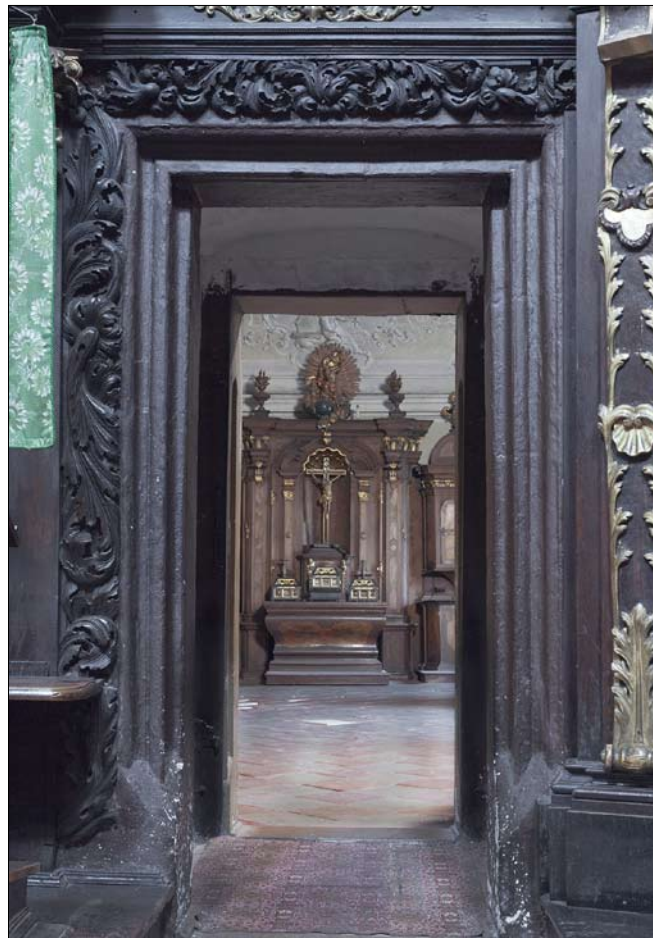
Obr. 12: Broumov, klášter, kostel sv. Vojtěcha. Jižní portál průchodu do sakristie.
