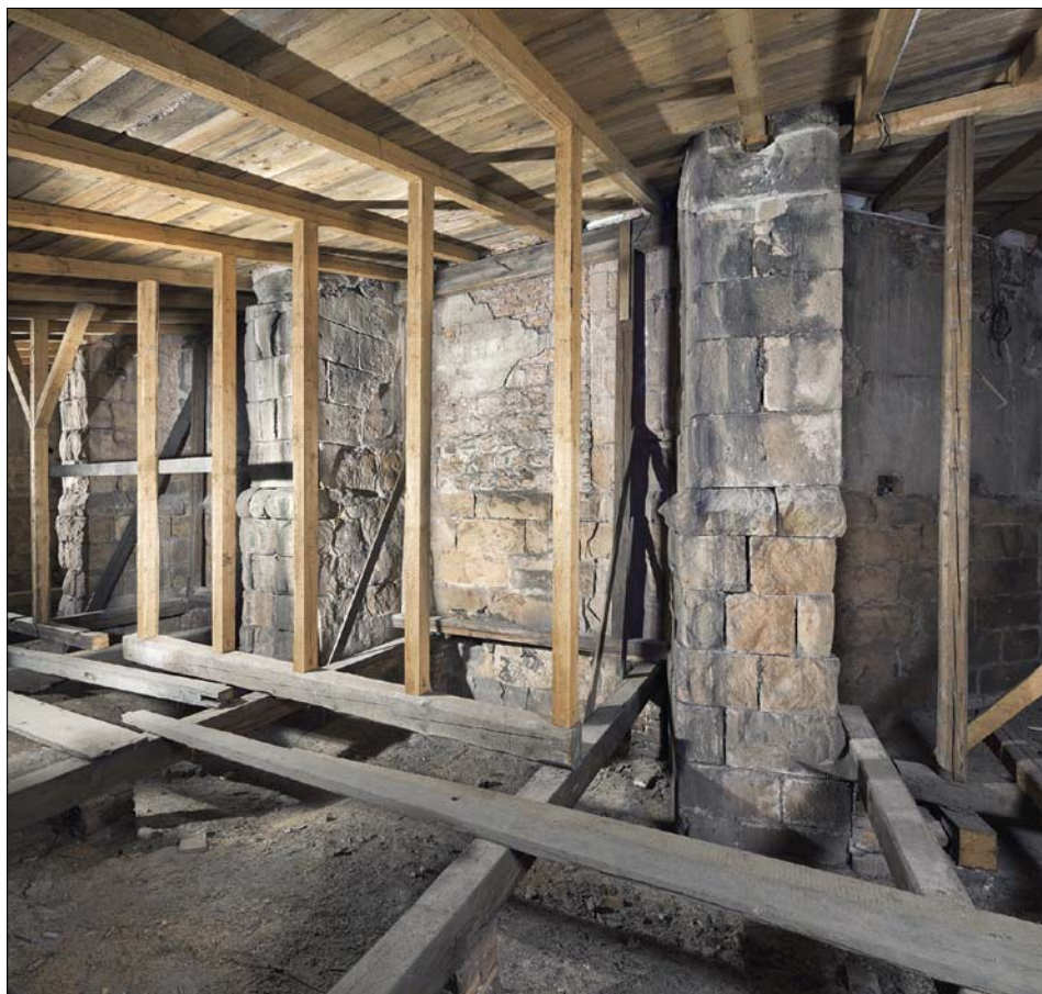
Obr. 20: Broumov, klášter, kostel sv. Vojtěcha. Gotické zdivo v podstřeší na jižní straně kostela; v popředí jihovýchodní nárožní opěrák.
