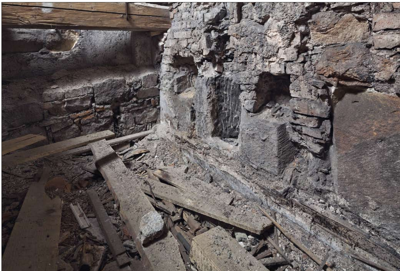
Obr. 19: Broumov, klášter, kostel sv. Vojtěcha. Gotické zdivo na severní straně kostela; dole kvádrové zdivo s okénkem, nad ním otisk klenby. Pod okénky zbytek ohořelého fabionu dnešní Tadeášky.
