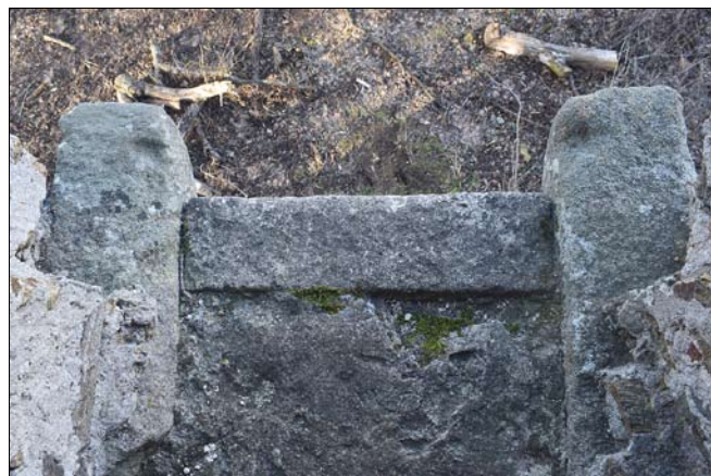
Obr. 11: Cornštejn, předsunutá fortifikace hradu. Vstup do věže, dvojice konzol (s lůžky pro točnici padacího můstku) a práh.
