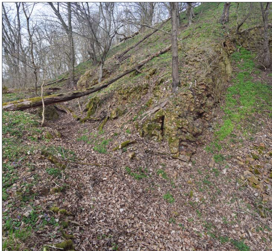
Obr. 5: Cornštejn, předsunutá fortifikace hradu. Pohled k severozápadu na severozápadní konec čelního příkopu, vpravo neodtěžený skalní výchoz.
