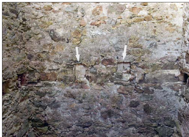
Obr. 13: Cornštejn, předsunutá fortifikace hradu. Jihovýchodní stěna věže s dvojicí kapes trámů (vyznačeno šipkami), při okrajích fotografie kapsy trámů podlahy prvního patra.
