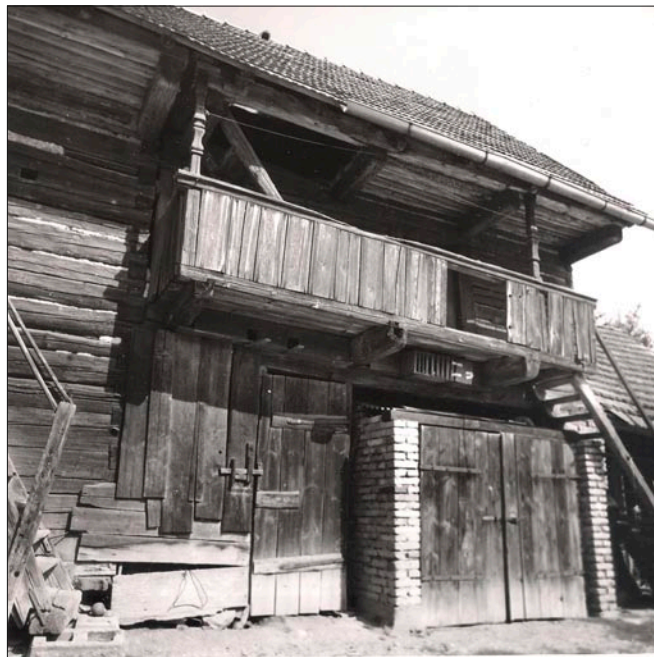
Obr. 5: Jarov, usedlost čp. 2. Kolna přiléhající od jihovýchodu k roubené patrové sýpce. Kolna byla transferována do Rabštejna nad Střelou (foto J. Vajdiš, 1970; archiv NPÚ ÚOP v Plzni).
