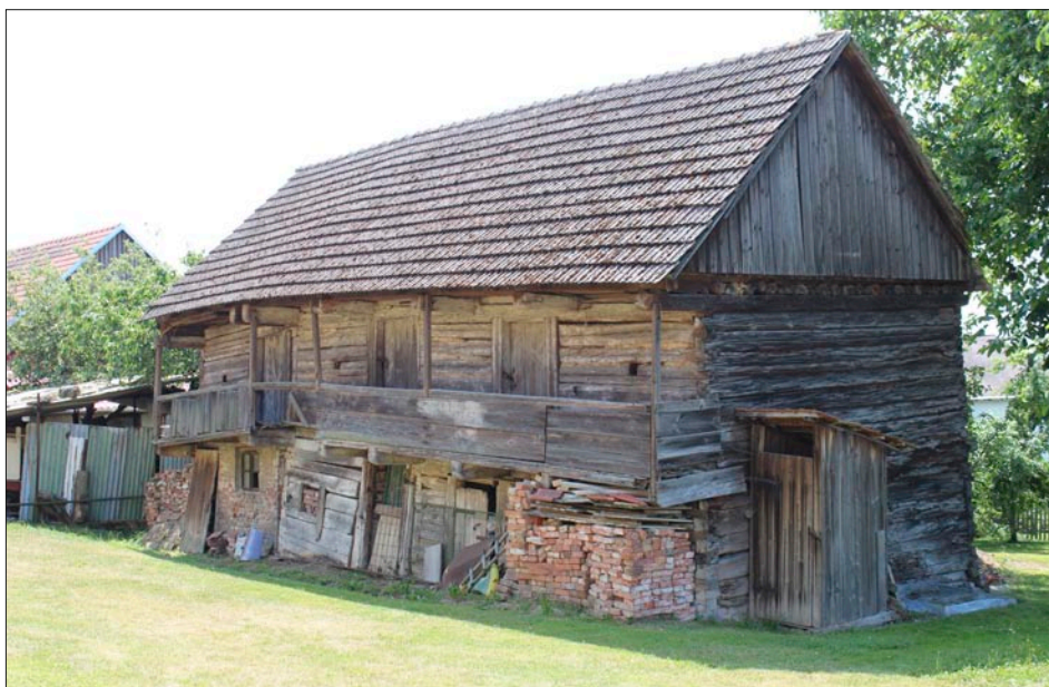
Obr. 14: Jarov, usedlost č. 22, pohled od severozápadu na roubenou patrovou sýpku s pavláčkou, stav 2024.
