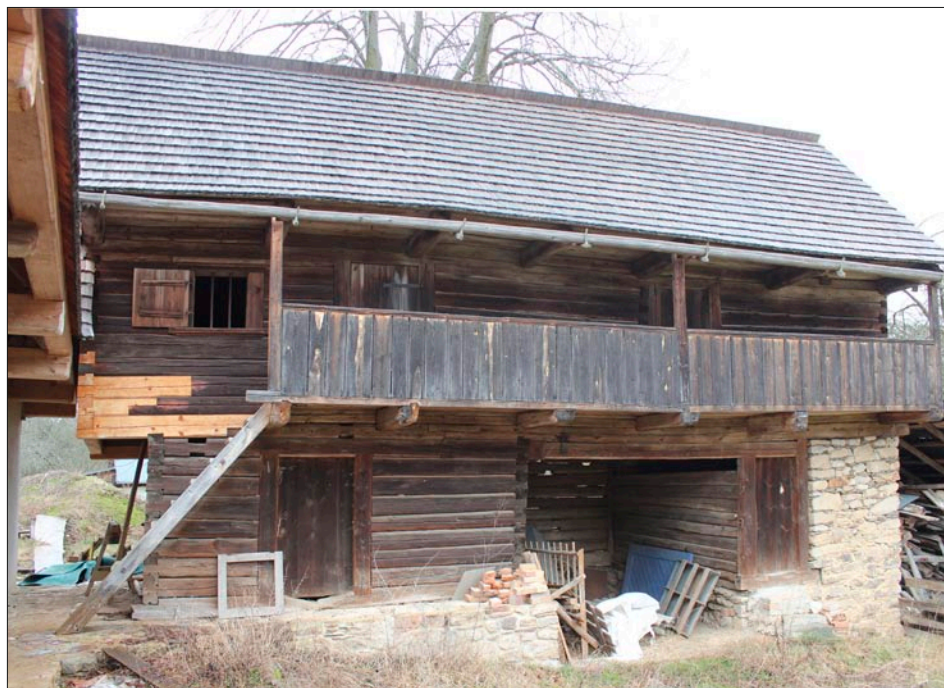
Obr. 17: Radějov, usedlost čp. 18 (dříve čp. 3), roubená patrová sýpka s pavláčkou, pohled od jihovýchodu, stav 2020.
