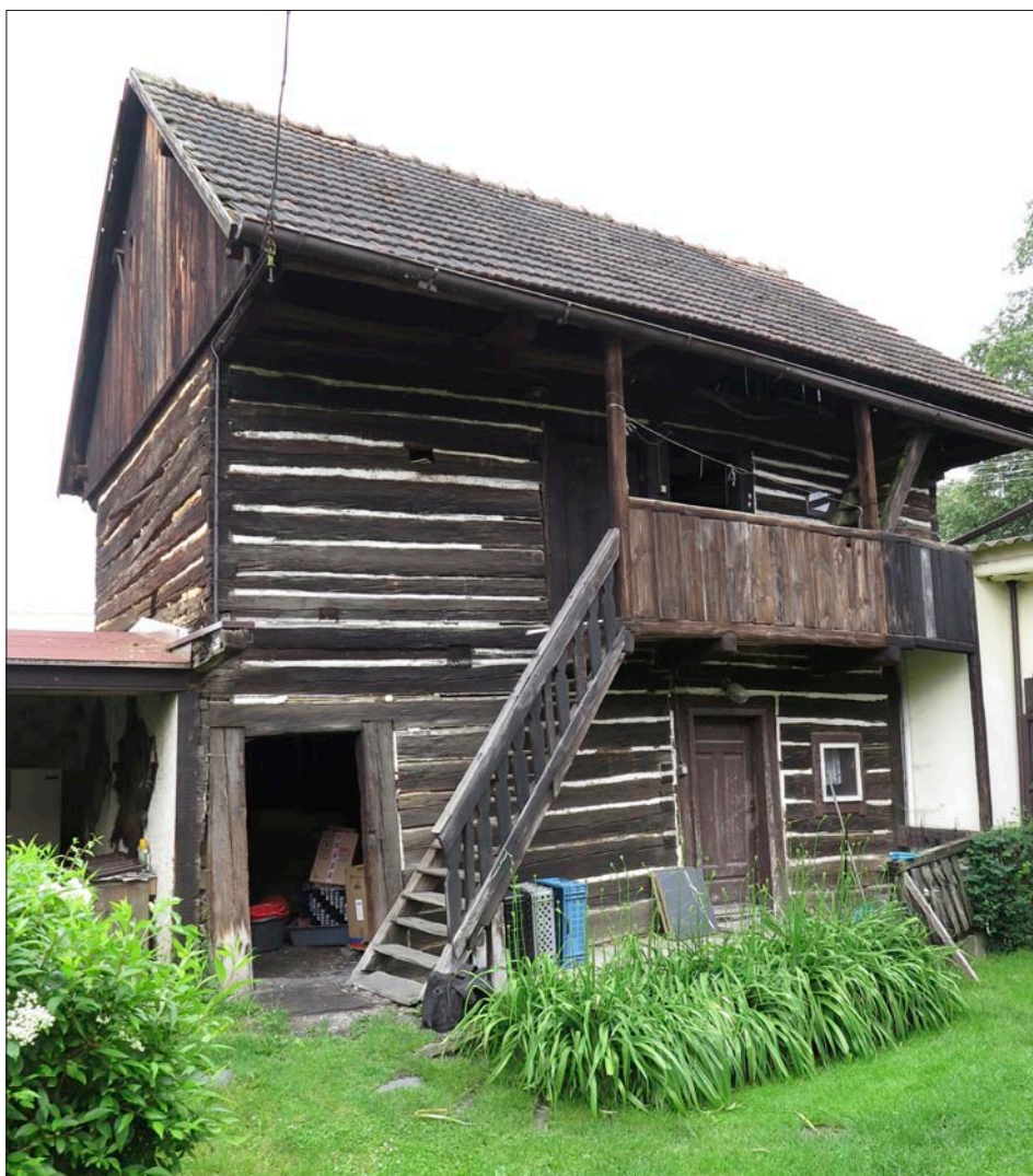
Obr. 3: Jarov, usedlost čp. 1, roubená patrová sýpka s pavlácí v jihozápadní části dvora, pohled od východu, stav 2024.
