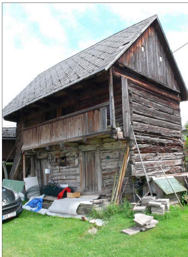
Obr. 18: Žebnice (okres Plzeň-sever), usedlost čp. 30, roubená patrová sýpka s pavláčkou, pohled od severozápadu, stav 2018.
