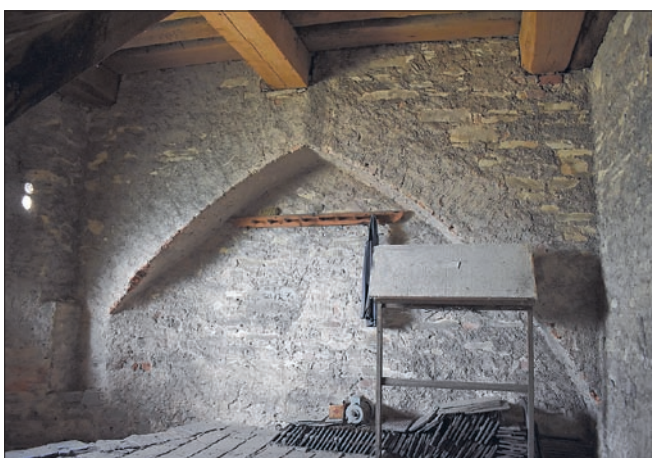
Obr. 34: Poděbrady, kostel Povýšení sv. Kříže. Hrotitý pas na severní straně druhého patra věže (stav 2024).
