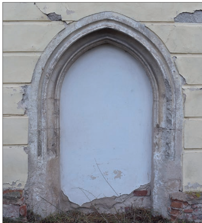
Obr. 14: Libice nad Cidlinou, kostel sv. Vojtěcha, jižní portál lodi (stav 2022).
