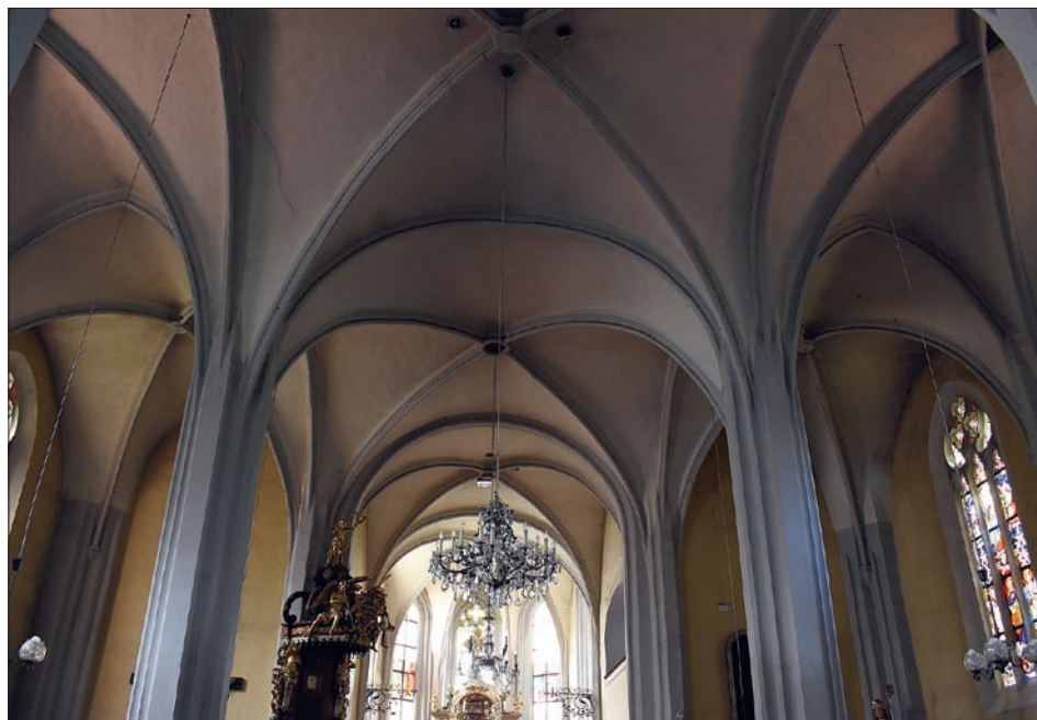
Obr. 11: Poděbrady, kostel Povýšení sv. Kříže. Klenba trojlodí s pohledem přes nevýrazný vítězný oblouk do presbytáře (stav 2024).
