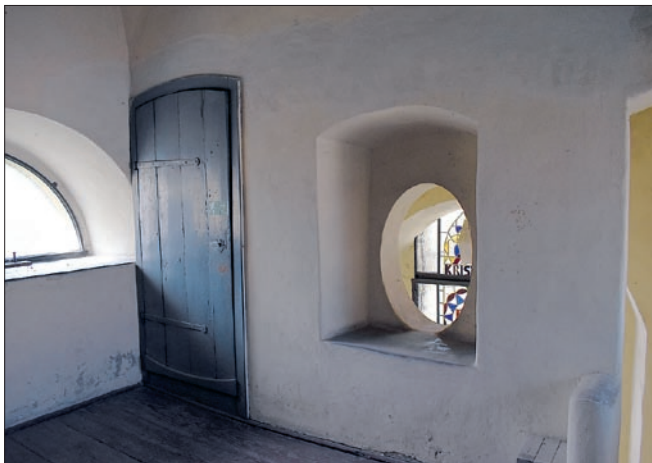
Obr. 33: Poděbrady, kostel Povýšení sv. Kříže. Patro věže, dveře schodů do 2. patra, okénko, zcela vpravo výstup schodiště z přízemí (stav 2024).
