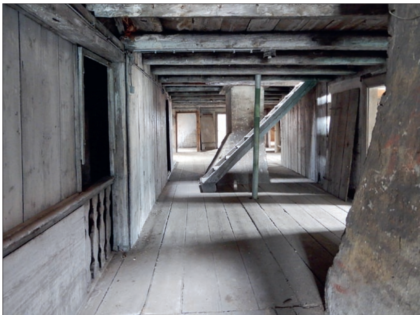
Obr. 30: Františkovy Lázně, dům čp. 9, pohled do podkroví směrem jižním, zcela vlevo schodiště s dřevěnými vyřezávanými balustrami, vpravo obytné komory nad předním traktem směřujícím k Hlavní třídě (foto L. Zeman, 2017).
