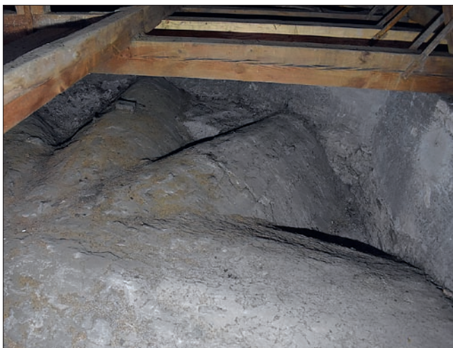
Obr. 15: Poděbrady, kostel Povýšení sv. Kříže. Rub závěrového pole klenby presbytáře (stav 2024).
