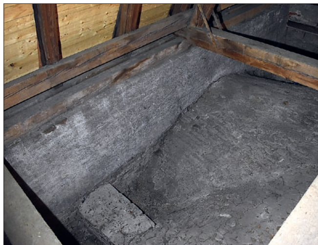
Obr. 16: Poděbrady, kostel Povýšení sv. Kříže. Rub klenby presbytáře (stav 2024).
