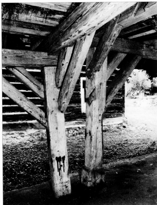
Obr. 11: Dřevěné sloupy s dvojicí pásků - zbytek historické konstrukce kolny před štítem domu ve dvoře.
