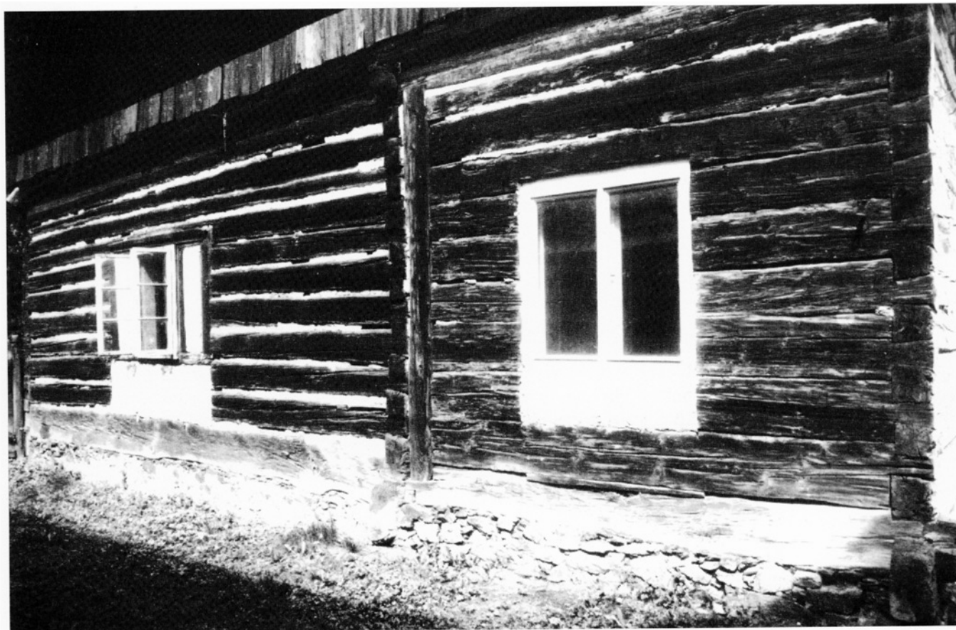
Obr. 15: Čelní stěna obytné části domu - vlevo světnice, vpravo - světnička, připojená dodatečně (na sloupek) k roubenému nároží světnice.
