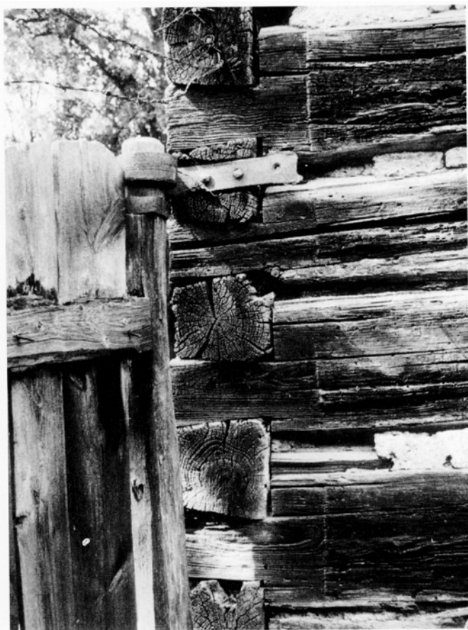
Obr. 13: Jižní roubené nároží světnice s rybinovou vazbou a stopami možného dodatečného odtesání oblin trámů.
