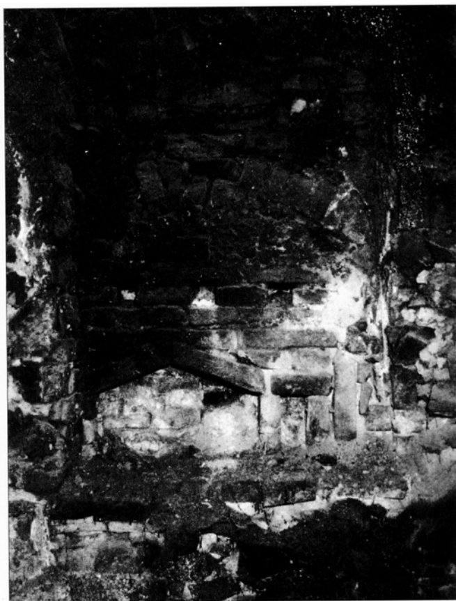
Obr. 7: Stěna kuchyně s dochovanými obslužnými a dymnými otvory někdejší pece.
