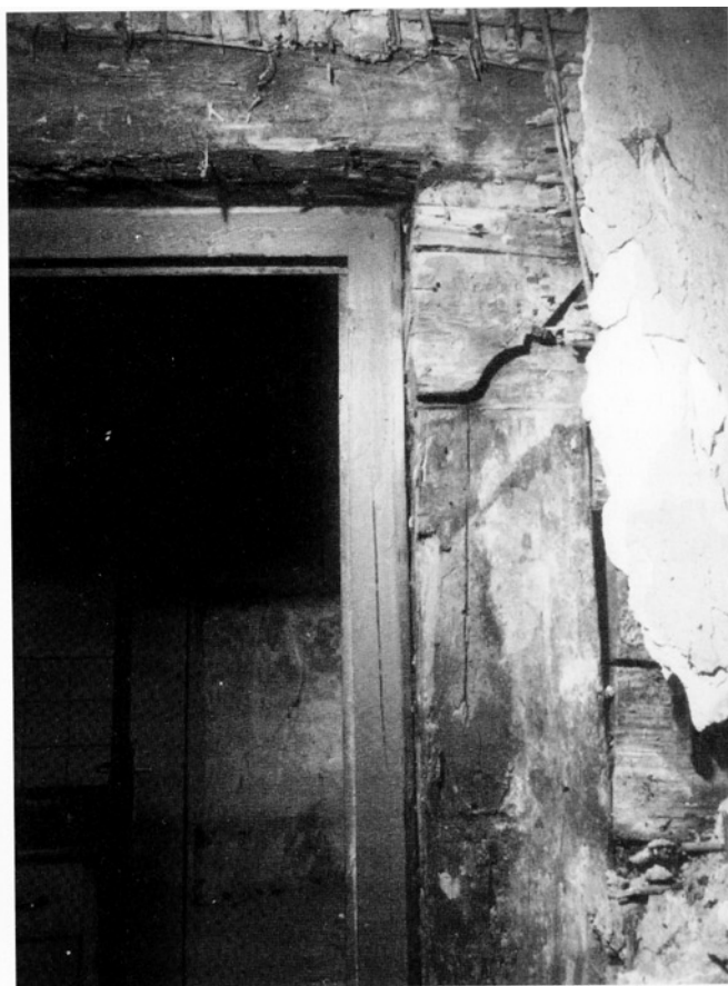
Obr. 14: Vstup ze světničky do novodobé kuchyně s fragmentem odsekané profilované římsy staršího nižšího portálu.
