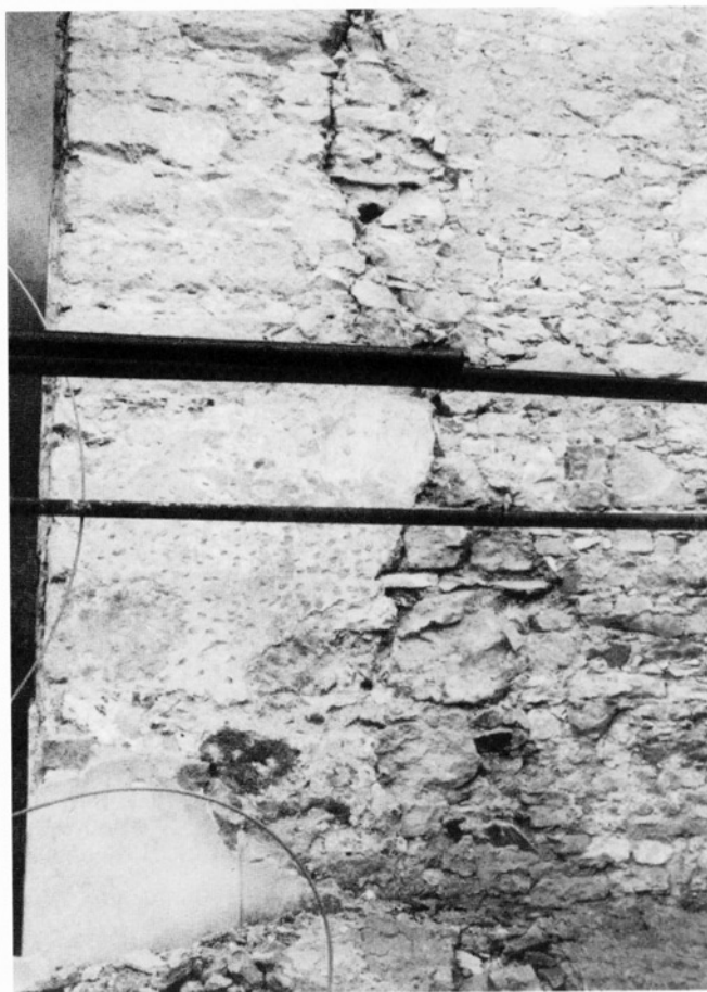
Obr. 14: Raně barokní štítová zeď lodi. Pohled od jihu, zprava připojeno vrcholně barokní zdivo jižní obvodové zdi.
