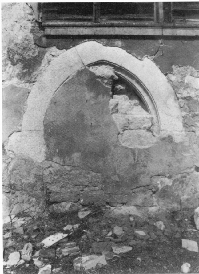
Obr. 8: Vstupní portál jižního bočního průčelí. (Foto R. Kursa.)
