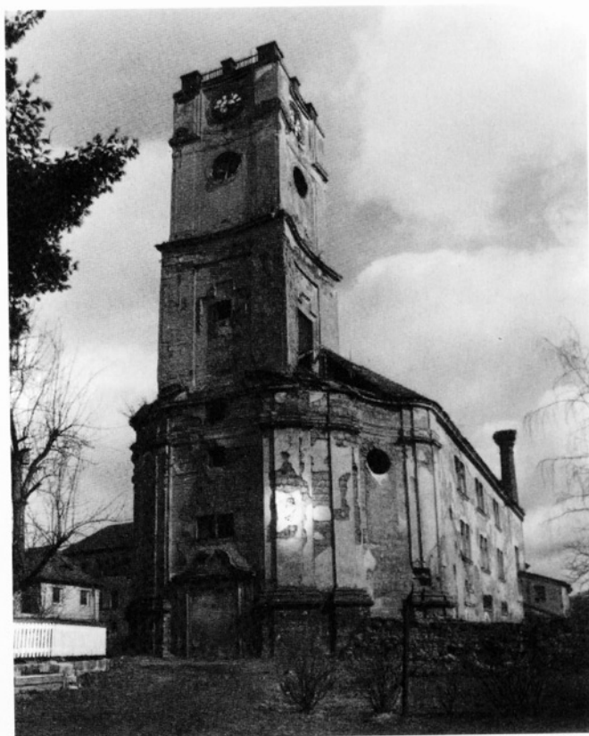
Obr. 2: Celkový pohled s představenou západní barokní částí z let 1781-83 od F. Hegera. Přestavba na pivovar 1863. (Foto R. Kursy.)
