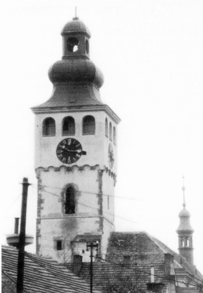
Obr. 11: Věž kostela po poslední opravě při pohledu od západu.
