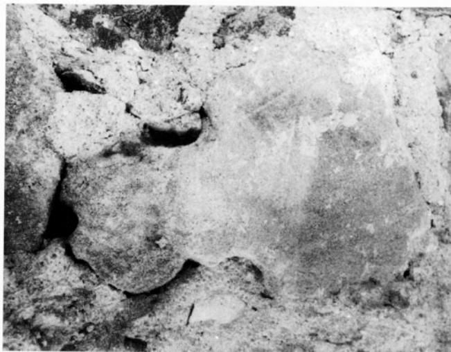
Obr. 14: Fragment klenebního žebra, zazděný v jižní části vnějšího pláště Velké věže. (Foto autor, květen 1993)
