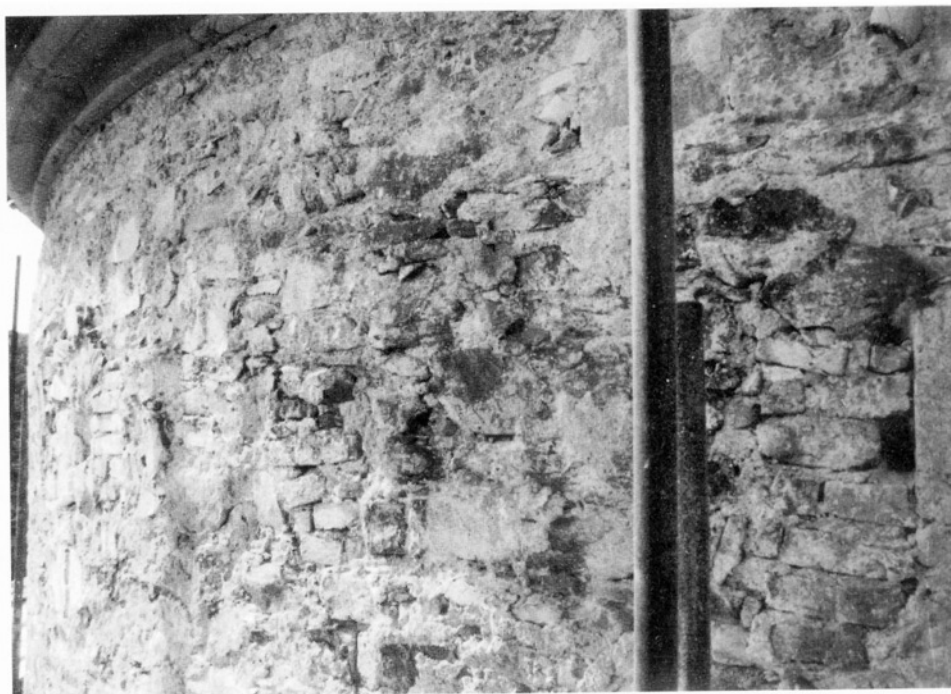
Obr. 5: Horní část věže na západní straně. Nahoře mírně kónický pruh novodobého zdiva, pod ním cihlami zazděné otvory po dřevěných vzpěrách ochozu, částečně ohraničené pískovcovými kameny. (Foto autor, květen 1993)
