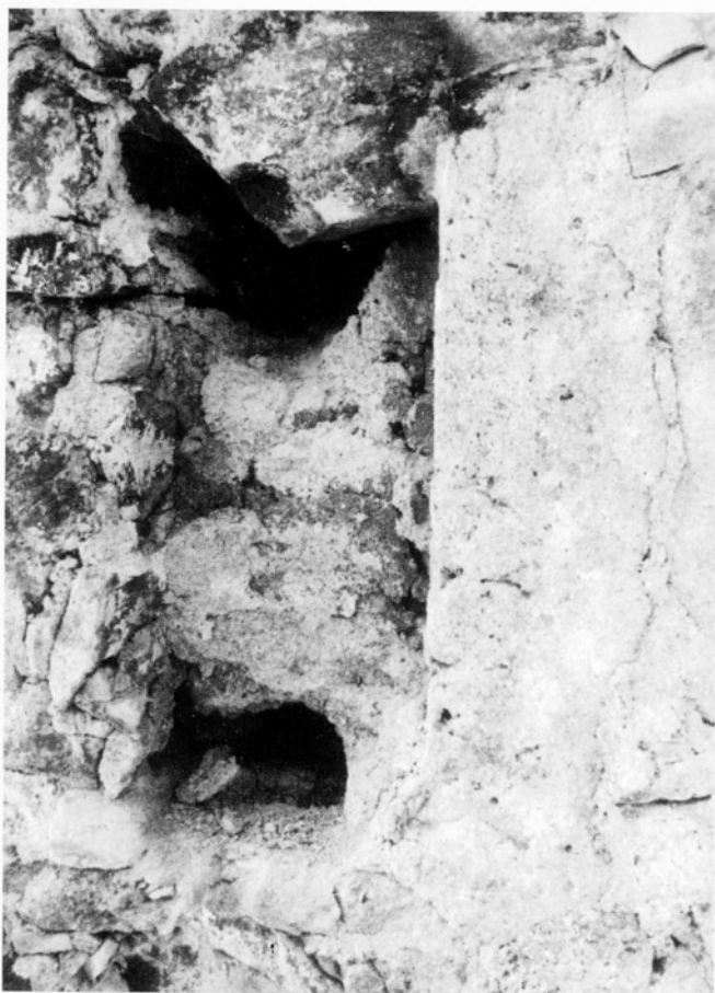
Obr. 6: Detail sondy do zazdívký otvoru vzpěry ochozu věže s otiskem v maltě v pozadí. (Foto autor, květen 1993)
