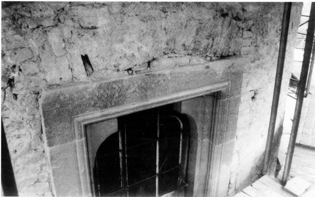
Obr. 21: Nadpraží portálku do dolní úrovně 1. patra Velké věže s vylehčovacím obloukem. (Foto autor, květen 1993)
