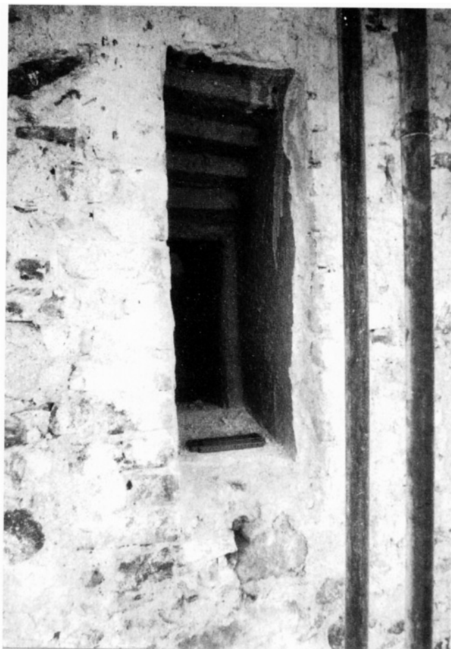
Obr. 15: Střední ze tří okének se stupňovitým nadpražím Velké věže. V parapetu zazděný fragment klenebního žebra. (Foto autor, květen 1993)
