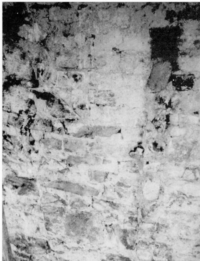
Obr. 10: Detail štěrbinové střílny Velké věže se sondou do zazdívk v horní části. Vlevo svislá technologická spára. (Foto autor, květen 1993)
