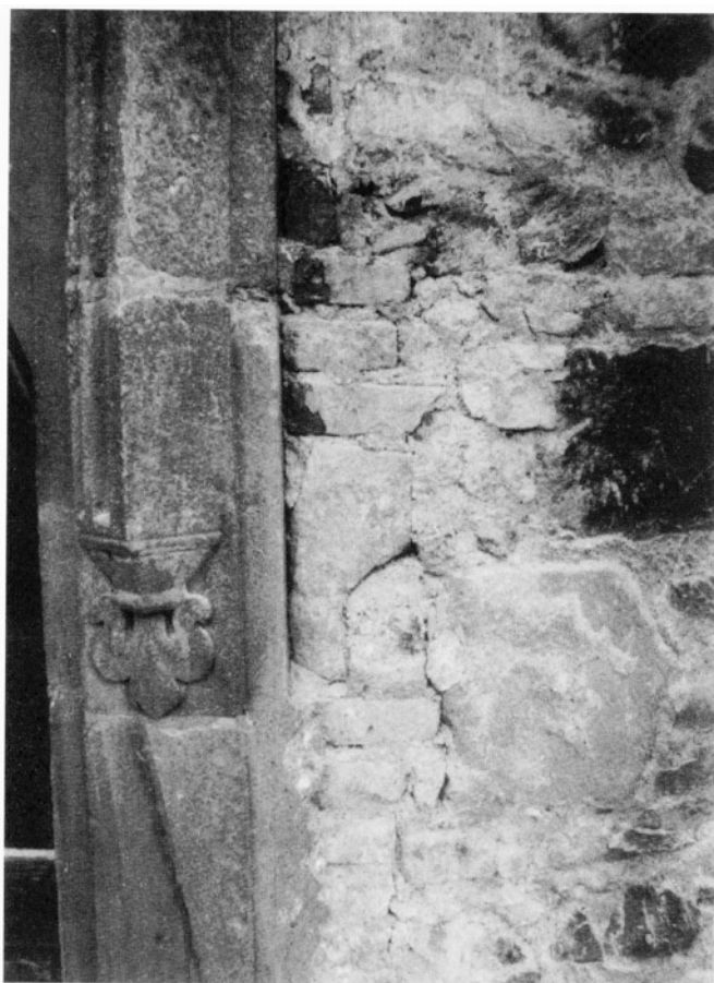
Obr. 19: Pravá stojka portálku do horní úrovně 1 patra Velé věže. (Foto autor, květen 1993)
