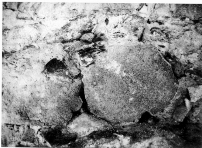
Obr. 12: Detailní pohled na dva zazděné architektonické fragmenty v nejspodnější partii zdíva Velké věže (srov. obr. 11). (Foto autor, květen 1993)
