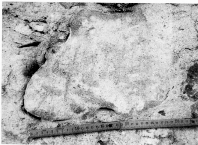
Obr. 13: Jedno z druhotně zazděných klenebních žebër v severní části zdíva Velké věže. V horním výžlabku fragment nátěru. (Foto autor, květen 1993)
