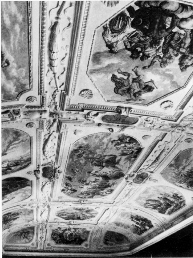
Obr. 21: Klenba velkého sálu ve 2. patře severozápadního křídla zámku. (Foto PÚ v Pardubicích - V. Maryška 1992)
