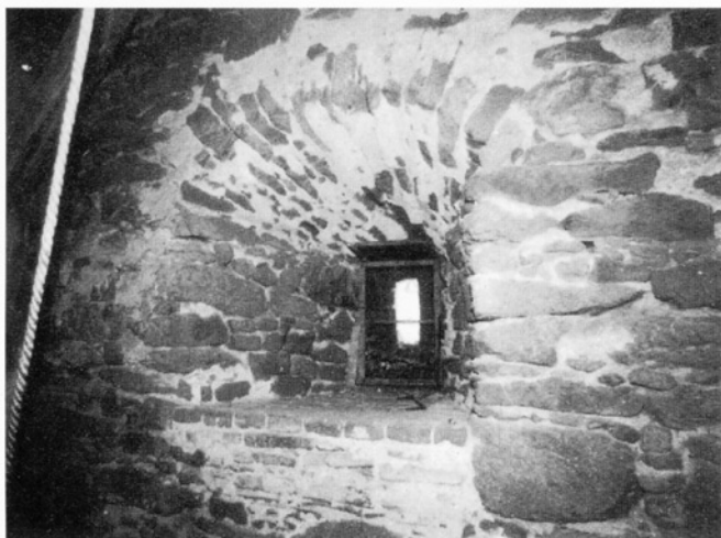
Obr. 2: Špaleta střílnovitého okénka ve východní zdi 2. patra věže.
