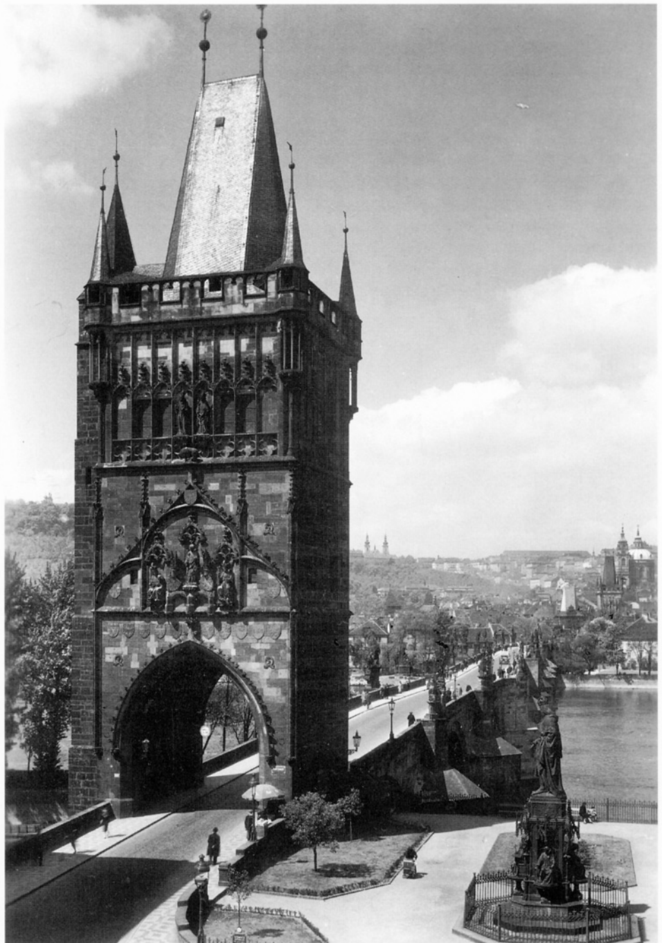
Obr. 1: Staroměstská mostecká věž, celkový pohled. Započata před rokem 1370, dokončena před r. 1395. Foto: A. Paul.
