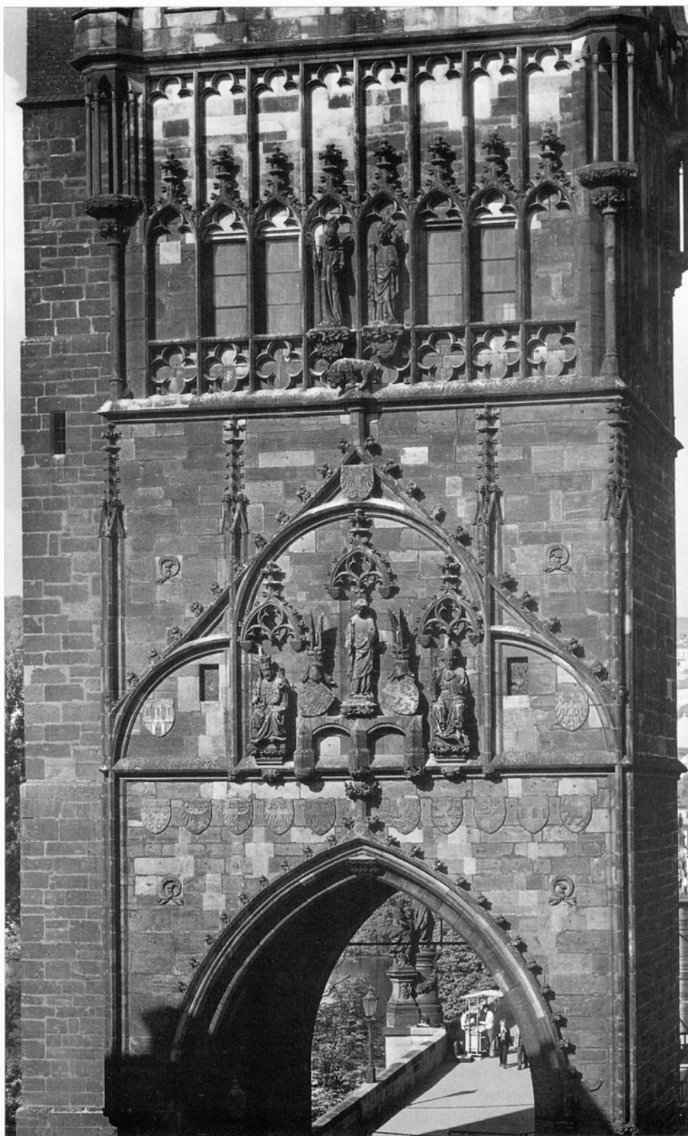
Obr. 3: Staroměstská mostecká věž, parlérovské členění a sochařská výzdoba východního průčelí. (Foto V. Uher.)
