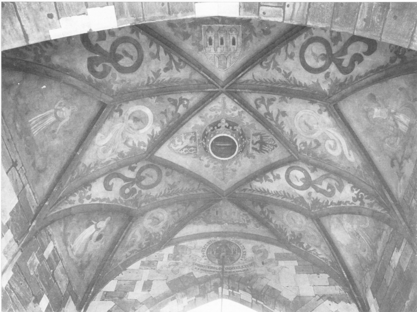
Obr. 16: Sítová klenba v příjezdu mostecké věže. Koleno r. 1380 (Foto V. Uher.)
