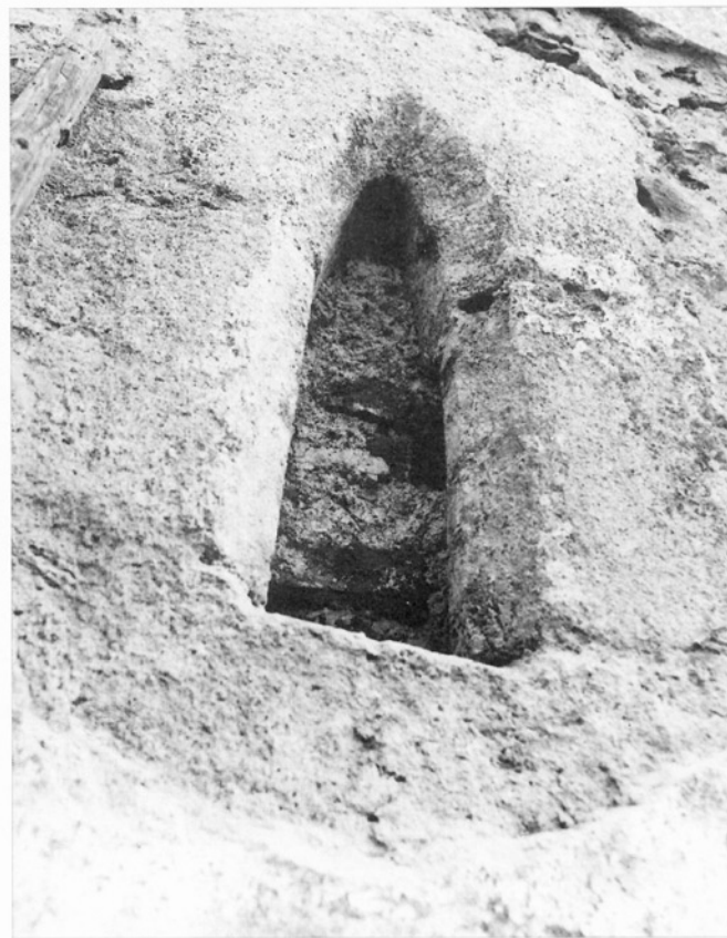
Obr. 10: Čečovice, zámek, gotické okénko v západním průčelí sýpky.
