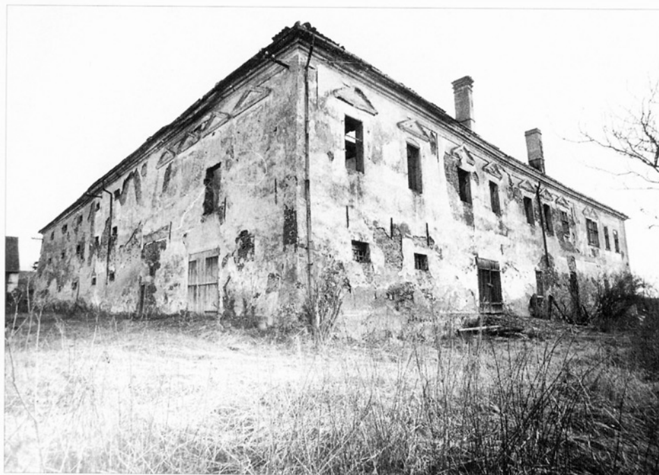
Obr. 13: Čechovice, zámek od jihozápadu. Stav r. 1991.
