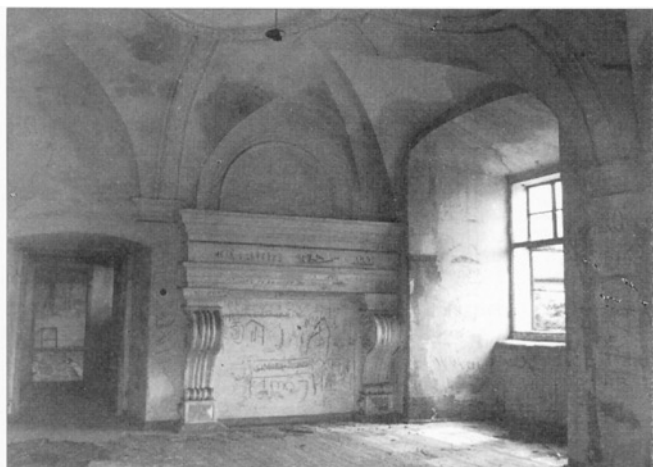
Obr. 17: Čechovice, zámek, místnost na jižním okraji jižního dílu patra východního křídla. Stav r. 1991.
