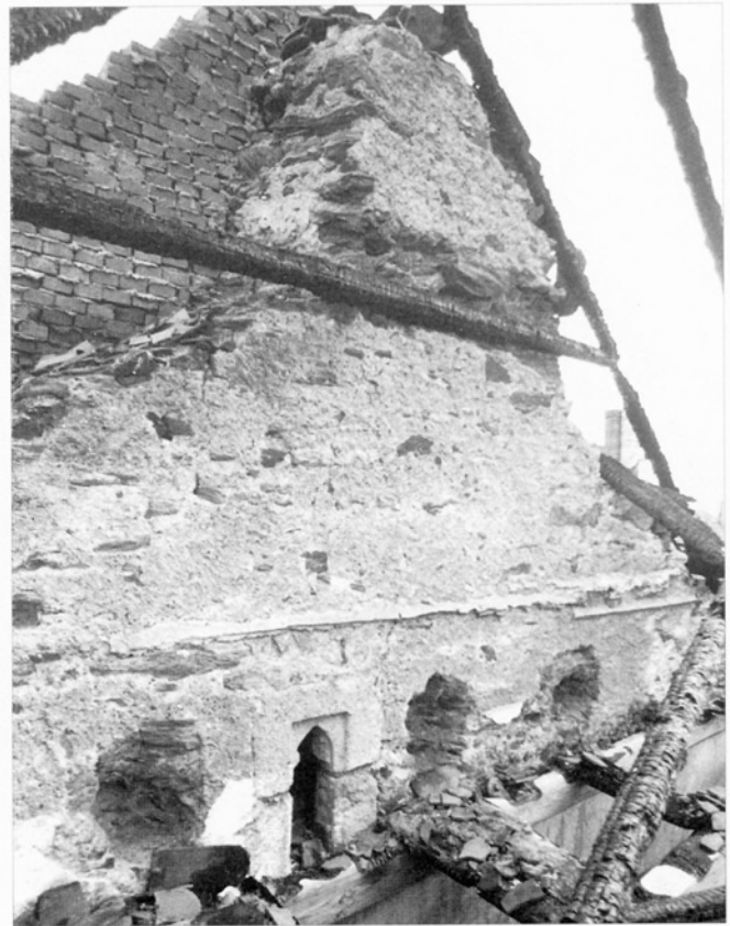
Obr. 12: Čečovice, zámek, gotické zdivo v jižním štítu sýpky, ve spodní části nad shořelým barokním stropem stopy renesančního stropu. Stav r. 1991.
