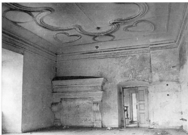
Obr. 18: Čechovice, zámek, místnost na severním okraji severního dílu patra východního křídla. Stav 1982.
