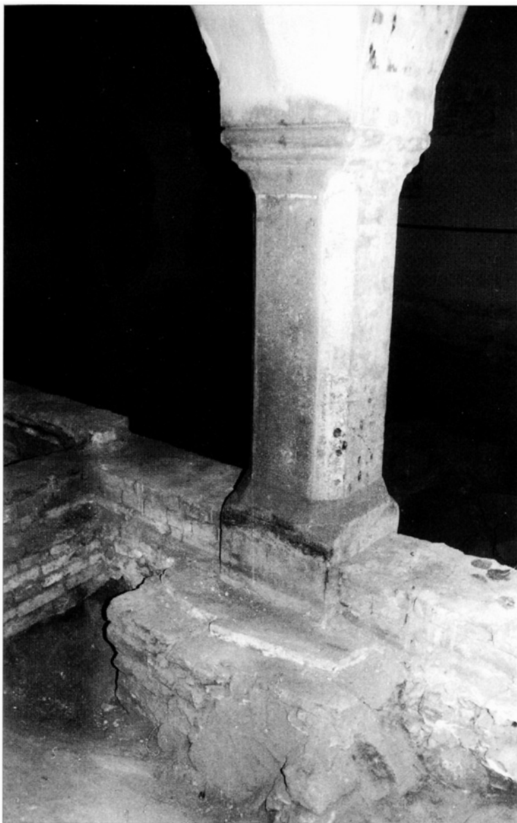
Obr. 8: Uvolněný střední sloupek mázhauzu se zachyceným fragmentem kamenné dlažby (stav 1993).
