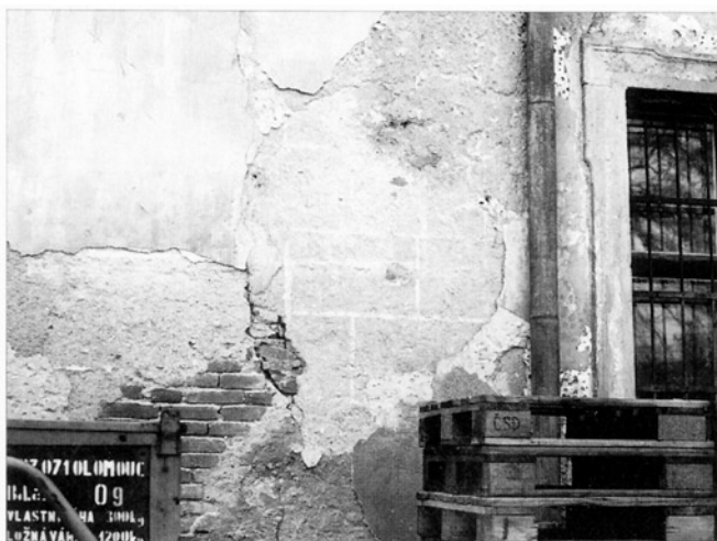
Obr. 4: Zásmyky, detail omítkového kvádrování na průčelí zámku, konec 14. stol.
