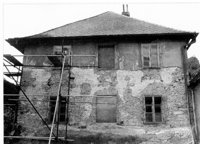
Obr. 8: Svatý Jan pod Skalou, zbytky středověkých omítek na východním průčelí budovy čp. 2. (Foto autor.)
