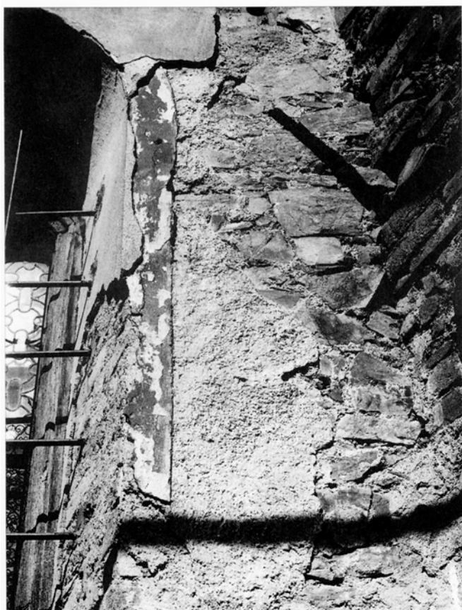
Obr. 13: Skřivany, kostel sv. Štěpána, detail pasparty a omítky na jižním průčelí, konec 16. stol. (Foto autor.)
