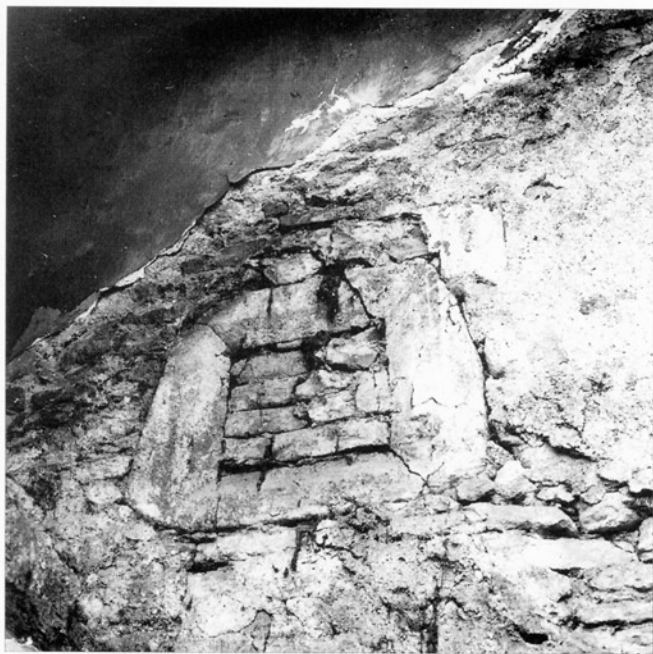
Obr. 10: Kutná Hora, dům čp. 136, detail okénka odhaleného na dvorním průčelí, kolem 1500. (Foto autor.)
