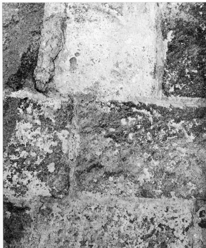
Obr. 1: Jesenice, kostel sv. Petra a Pavla, detail románského zdiva s mladším nátěrem se zvýrazněnými spárami. (Foto autor.)
