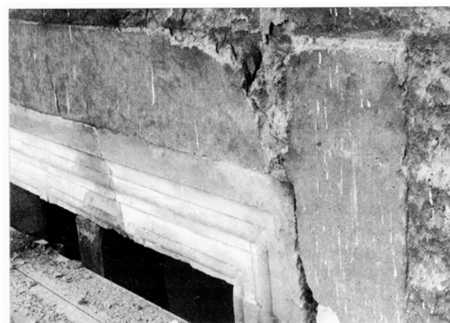
Obr. 9: Mladá Boleslav, hrad, detail pasparty a omítky u pozdněgotického okna na jižním průčelí hradu, kolem 1500. (Foto autor.)
