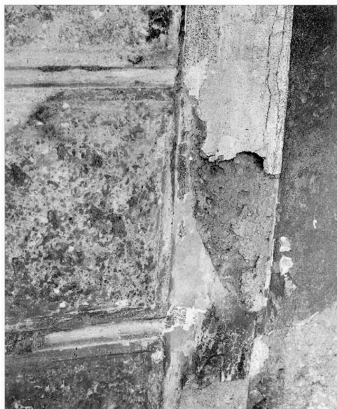
Obr. 22: Kluky, detail vypichované omítky na kvádrované leseně na průčelí zvonice, 2. pol. 18. stol. Vpravo lesenový rám červeně vybarvený. (Foto autor.)
