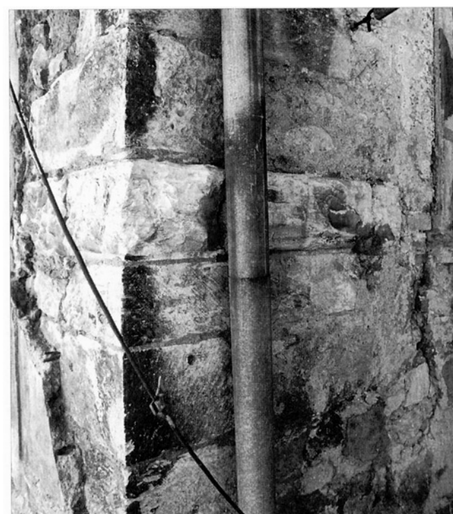
Obr. 4: Praha, dům č. p. 634/I. Kvádry jihozápadního nároží s osekanými zbytky kordonové římsy. (Foto Jan Sommer, 1994.)
