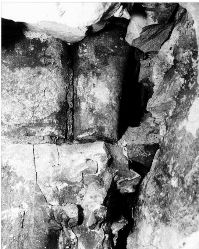
Obr. 5: Praha, dům č.p. 634/I. Detail ostění zaniklého gotického okna ve východní stěně prvního patra. Hlavice s výběhem kružby. (Foto Jan Sommer, 1994.)
