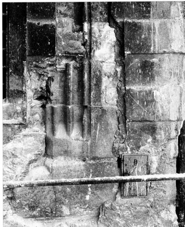
Obr. 3: Praha, dům č. p. 634/I. Detail ostění zaniklého gotického vjezdu v jižním průčelí. (Foto Jan Sommer, 1994.)
