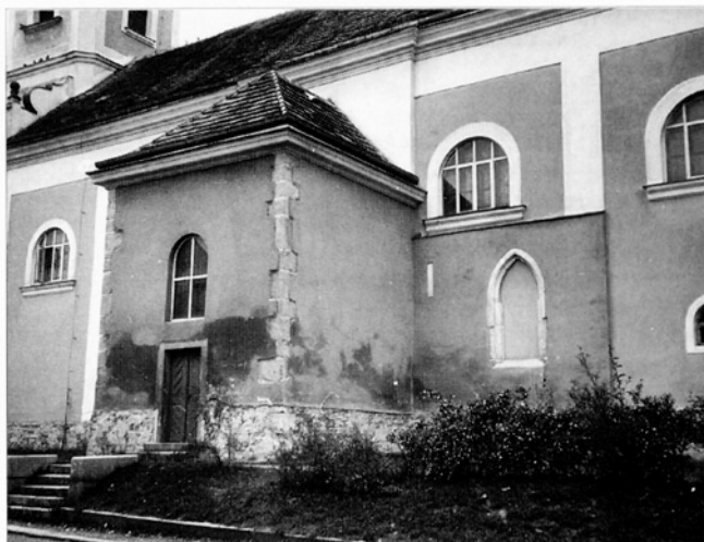
Obr. 1: Kostel sv. Petra a Pavla v Říčanech, jižní bok kostela s torzem bývalé gotické věže. (Foto P. Kroupa.)
