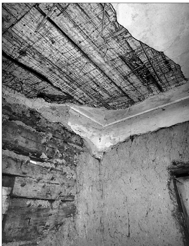
Obr. 7: Zbytky původní úpravy stěn a stropu v sakristii. Na stěně s kolicí hliněná mazanina, na fabionu a stropu omítka na rákosu, neseném drátem a hřebíky rákosníky.
