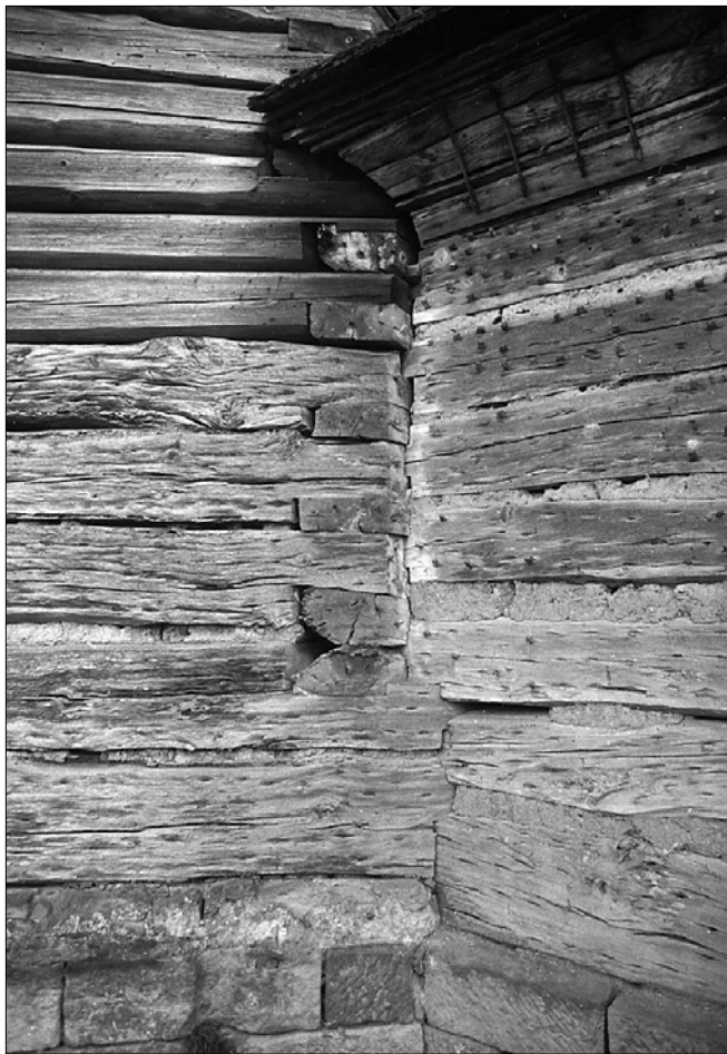
Obr. 5: Vazba roubených stěn lodi a předsíně v severozápadním koutu kostela. Dole podezdívka z kvádrů, na ní vlevo vyrovnávací vrstva z lomového zdiva. Na stěně předsíně vpravo jsou ještě původní vymazávky spar a kolyčky či stopy po jejich zatlučení, nahoře vyskládaný polotovár římsy s kolmými štěpinami. Hladké tenčí dřevo vlevo nahoře je z tesařské opravy kostela v roce 1934.
