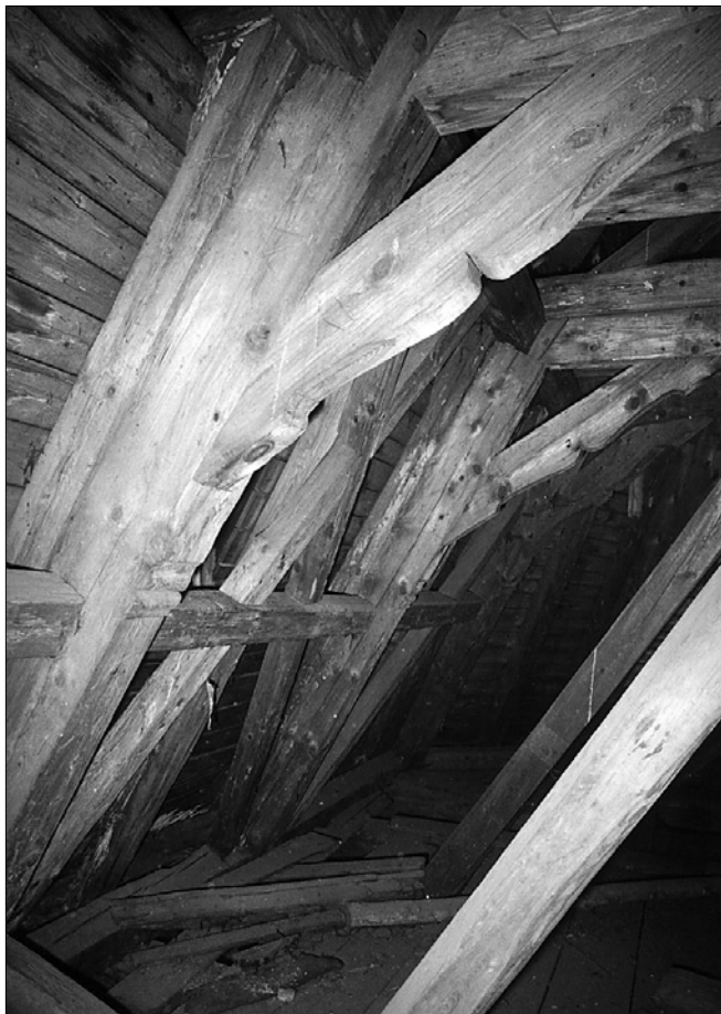
Obr. 8: Vazba jedné z ležatých stolic v krovu lodi kostela, s ozdobnou profilací a zavětrovacími ondřejskými kříži.
