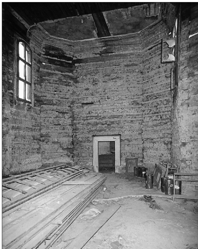
Obr. 6: Pohled do východní části lodi kostela, v ose s portálem do sakristie. Nahoře na bednění stropu jediný zbytek původní omítky interiéru.
