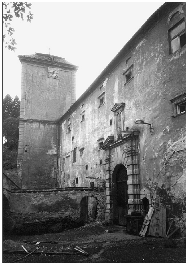
Obr. 18: Východní průčelí předhradí s renesančními portály a hranatou věží ukončující štítovou zeď.
