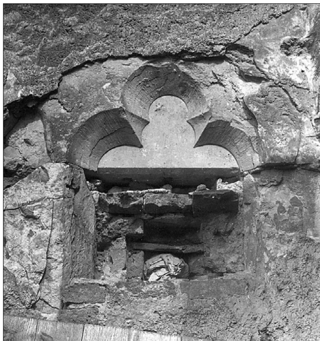
Obr. 6: Pětistá slepá kružba v nadpraží jihovýchodního okna v západním dílu přízemí. Stav v r. 1983.
