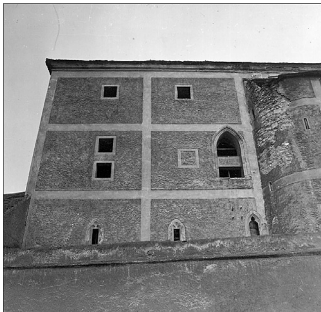
Obr. 10: Jižní fasáda s gotickými otvory v 1. a 2. patře.
