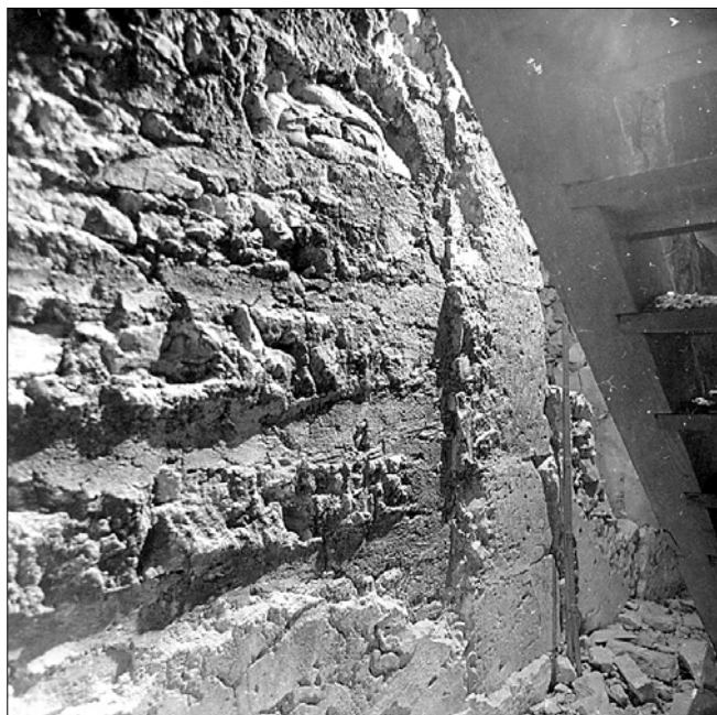
Obr. 17: Otisky kuláčů roubení u severozápadního rohu středověké obytné místnosti ve 2. patře. Patrná návaznost kuláčů na rohový sloupek, v pozadí hrana dveří na záchod.
