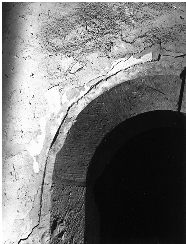
Obr. 9: Napojení gotické omítky na opukové ostění portálu na záchod v prvním patře.
