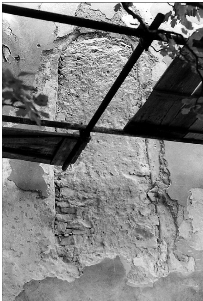
Obr. 7: Okno v levé části východního průčelí presbytáře zazděné při barokní přestavbě. Po obvodu patrna pozdně gotická omítka s malovanou červenou a následně šedou paspartou. (Foto autor.)
