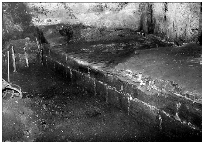
Obr. 2: Odkrytý západní líc pískovcového obkladu jižního zhlaví pilíře. Pohled od jihozápadu. (Foto K. Fink.)
