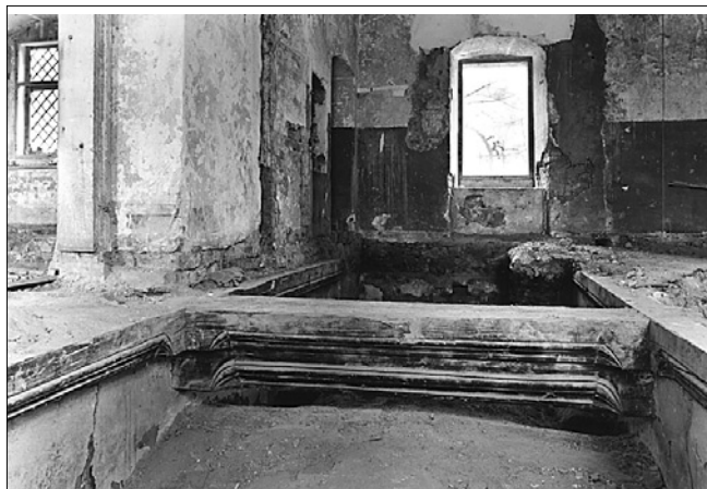
Obr. 3: Celková situace po odkrytí reliktů trámových konstrukcí (foto R. Kursa).
