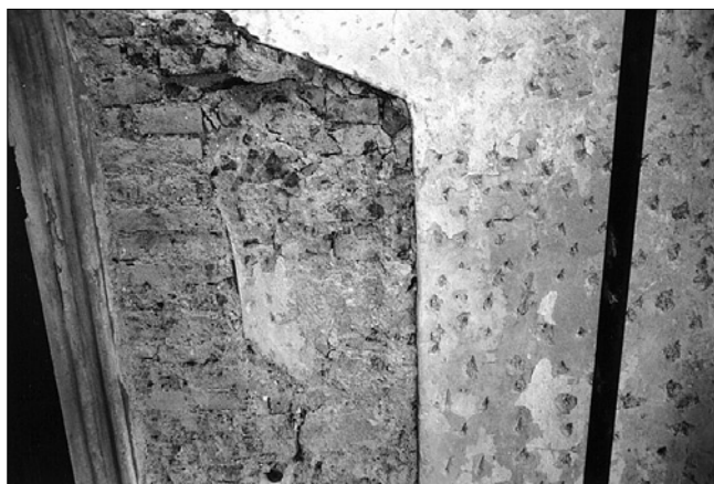
Obr. 8: Kostel Pozdvížení sv. Kříže v Pyšelicích, severní stěna lodě, torzo ostění gotického vstupu do přístavky, v zadržce náběh archivoly torza pozdně gotického okna. (Snímek P. Kroupa.)
