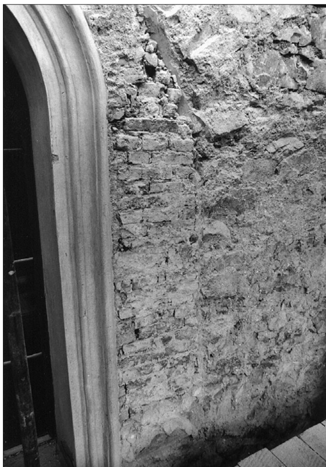
Obr. 6: Kostel Povýšení sv. Kříže v Pyšelicích, jižní stěna lodi, torzo ostění gotického špaletového okna. (Snímek P. Kroupa.)
