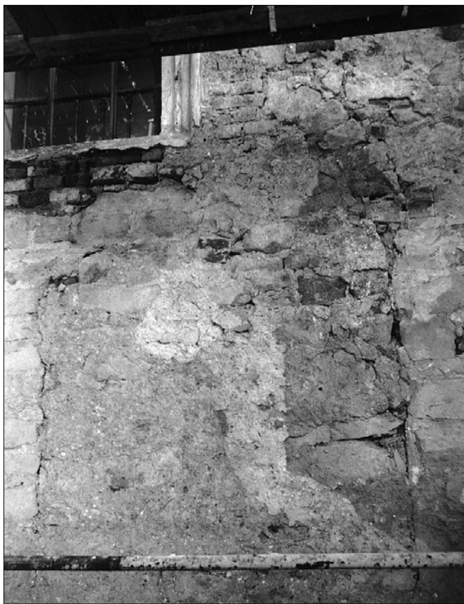
Obr. 9: Kostel Pozdvížení sv. Kříže v Pyšely, severní stěna lodi, pravděpodobně pozdně románský portál vylámaný v románském zdivu. (Snímek P. Kroupa.)
