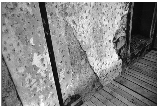
Obr. 3: Kostel Pozdvížení sv. Kříže v Pyšelic, severní stěna lodi, plochy gotických omítek s otisky po zaniklém přístavku se zachovanými hrubě hrozenými vnitřními gotickými omítkami. (Snímek P. Kroupa.)
