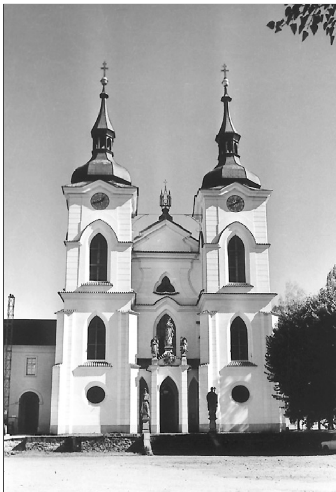
Obr. 5: Průčelí klášterního kostela Narození Panny Marie v Želivě dnes (Foto V. Martínek).
