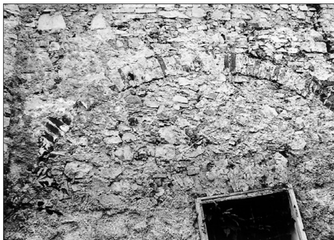
Obr. 12: Pyšely, objekt čp. 6, zahradní průčelí, záklenek renesanční brány. Snímek P. Kroupa.
