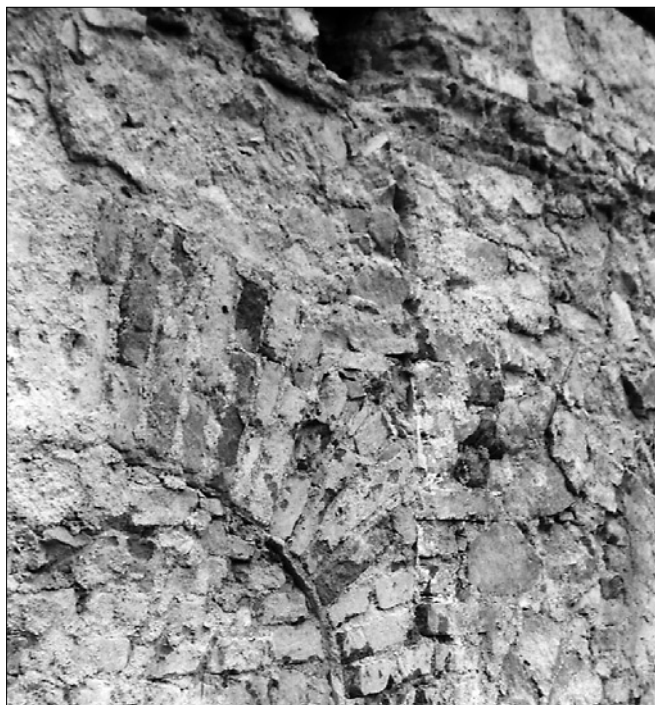
Obr. 19: Pyšely, zámek. Zachycená spára snad renesančního otvoru se zbytky omítky a dodatečně vloženým obloukem klasicistního okna ve střední ose severovýchodní fasády. Snímek E. Vyletová.
