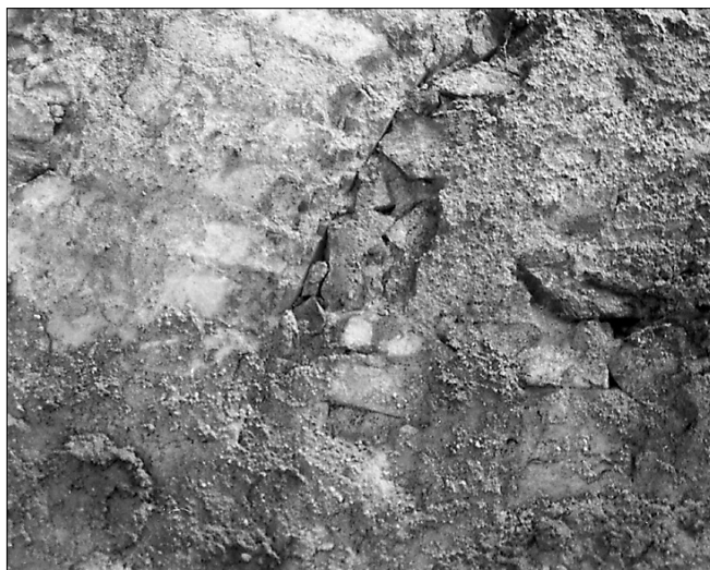
Obr. 10: Pyšely, objekt čp. 6, průčelí do náměstí, zachycený záklenek vjezdu renesanční brány. Snímek P. Kroupa.
