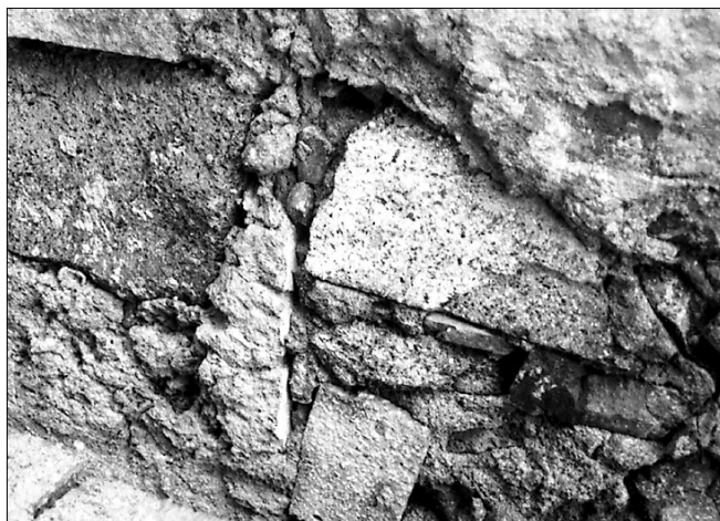
Obr. 9: Pyšely, objekt čp. 6, průčelí do náměstí, zachycená spára oddělující objekt renesanční brány od renesančního domu se zbytkem omítky původně vnějšího líce jihozápadní zdi brány. Snímek P. Kroupa
