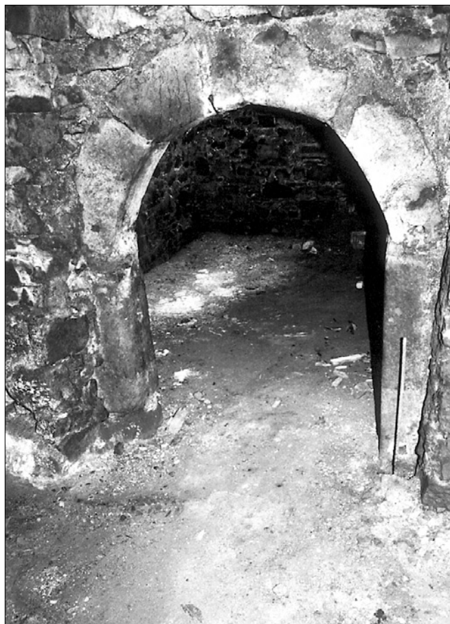
Obr. 3: Pyšely, objekt čp. 6, gotický portál ve sklepním prostoru. Foto P. Kroupa.
