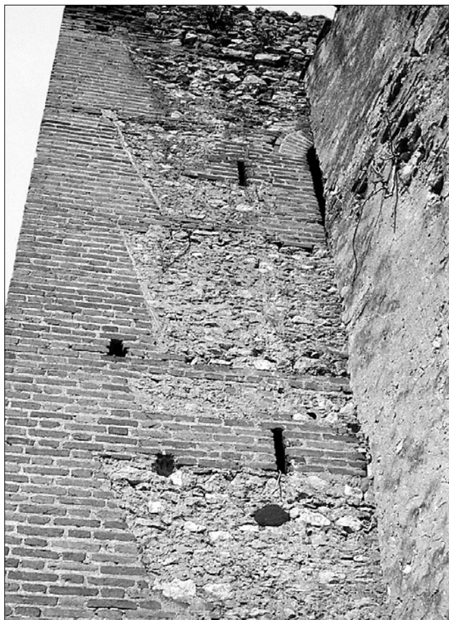
Obr. 7: Soave (Itálie). Věže městského opevnění byly stavěny samostatně a mezi ně byly na spáru vkládány hradební kurtiny. Společné omítky dokládají, že časová vzdálenost výstavby obou prvků byla minimální. Vnější líc kurtin se často tak těsně přibližuje k bočním střílnám věží, že se značně omezuje jejich použitelnost ke střelbě. Na snímku severozápadní nárožní věž po svém vychýlení v základech, těsně upravo od střílny vislý otisk líce kurtiny v její původní poloze. Foto autor 1993.
