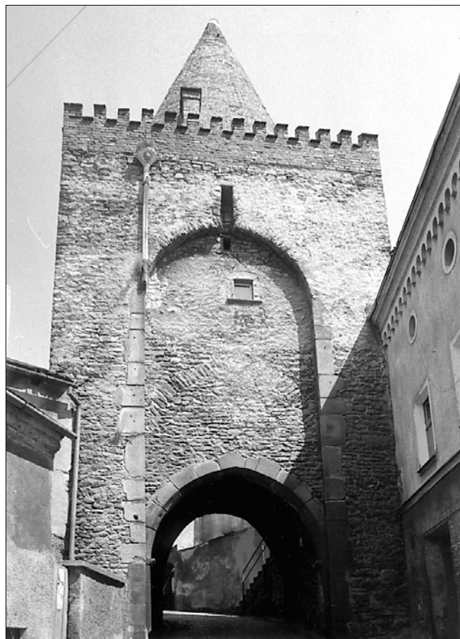
Obr. 5, 6: Bystrzyca Kłodzka (Polsko), věž bývalé Kladské brány (vlevo), která se typologicky nejspíše shodovala s branami ve Vysokém Mýtě, a odlišná, průjezdní brána Vodní (vpravo) patrně vznikly v rámci jedné stavební etapy kolem roku 1319. Foto autor 1995.
