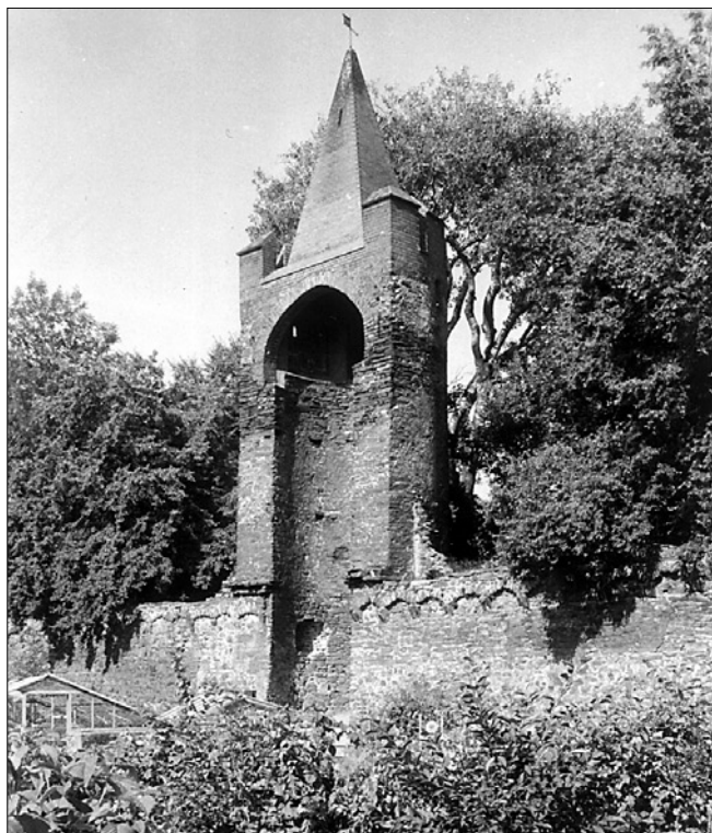
Obr. 3, 4: Paczków (Polsko), městská hradební zeď byla na jižní straně zakončena pultovou stříškou (vlevo - otisk na boční straně věže) a na severní straně vrcholila ochozem s cimbuřím (vpravo). Bez archeologického výzkumu, který by jednoznačně prokázal vznik obou částí opevnění v různých obdobích, je nutno počítat také s možností výstavby v jediném období, ale odlišnými staviteli. Foto autor 1995.
