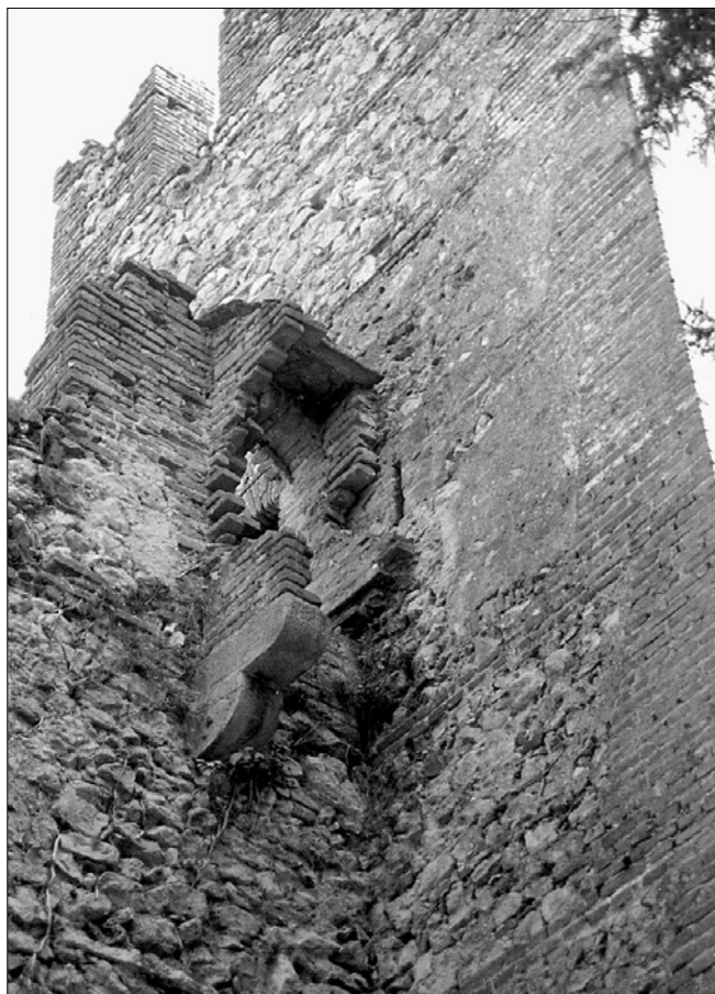
Obr. 8: Soave (Itálie). Prevět, připojený spolu s kurtinou na spáru k boční stěně věže, dokonce zakryl jednu ze stříln. Stav po částečné destrukci prevetu a opětném obnažení střílny. Foto autor 1993.
