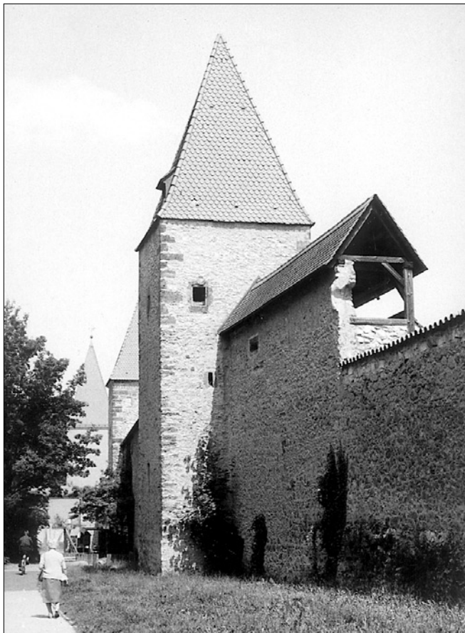
Obr. 9: Amberg (Německo). Hranolové hradební věže s nesystematicky rozmístěnými střelnými flankující kurtiny nejednotným způsobem (horní patro věží pozdně gotické). Foto autor 1995.
