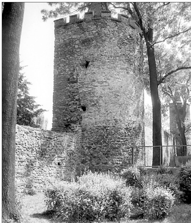
Obr. 3, 4: Paczków (Polsko), městská hradební zeď byla na jižní straně zakončena pultovou stříškou (vlevo - otisk na boční straně věže) a na severní straně vrcholila ochozem s cimbuřím (vpravo). Bez archeologického výzkumu, který by jednoznačně prokázal vznik obou částí opevnění v různých obdobích, je nutno počítat také s možností výstavby v jediném období, ale odlišnými staviteli. Foto autor 1995.
