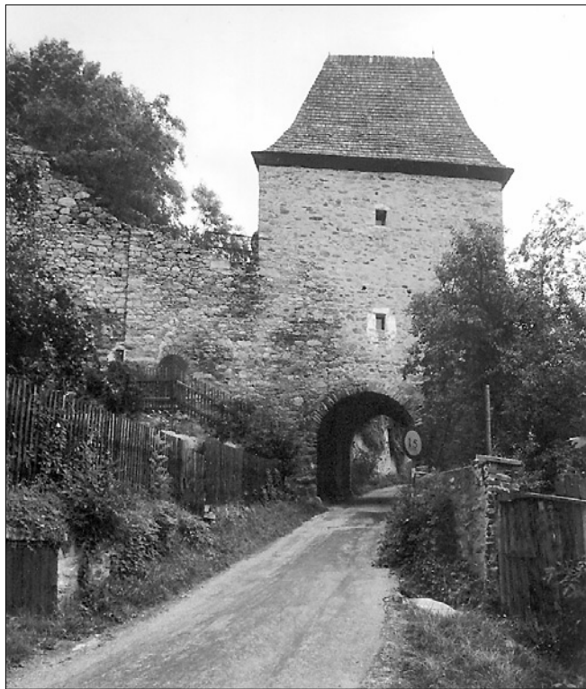
Obr. 10: Vimperk, brána městského opevnění pod hradem, vystavěná zároveň s úsekem hradební zdi vlevo. Další pokračování hradby odděleno svíslou spárou. Foto autor 1993.
