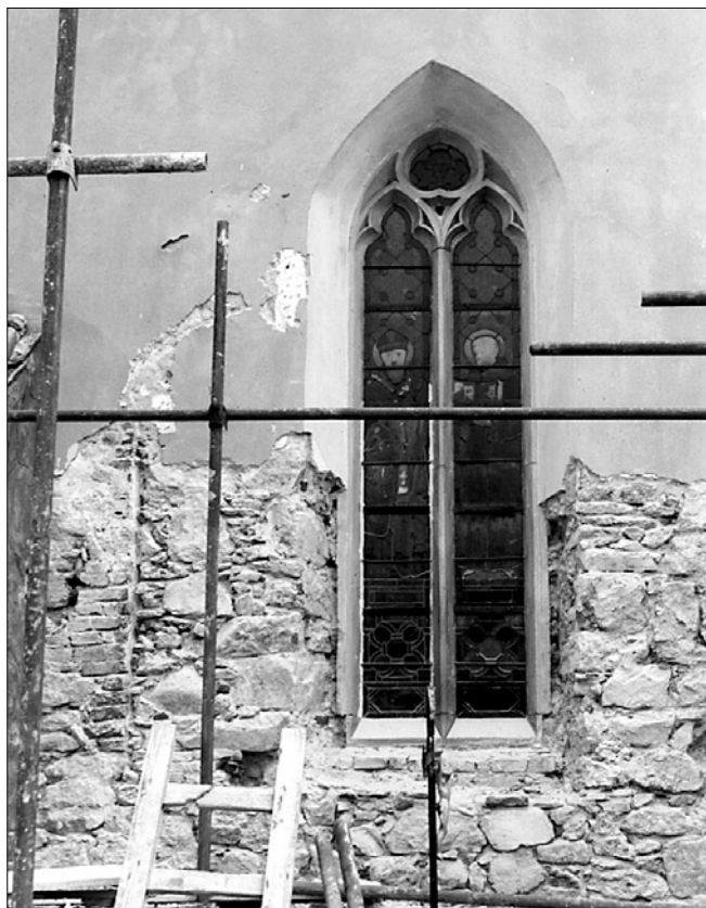
Obr. 8: Detail západní části jižního průčelí presbytáře, vlevo zazděné okno s cihelným ostěním a vrstvami středověkých omítek.
