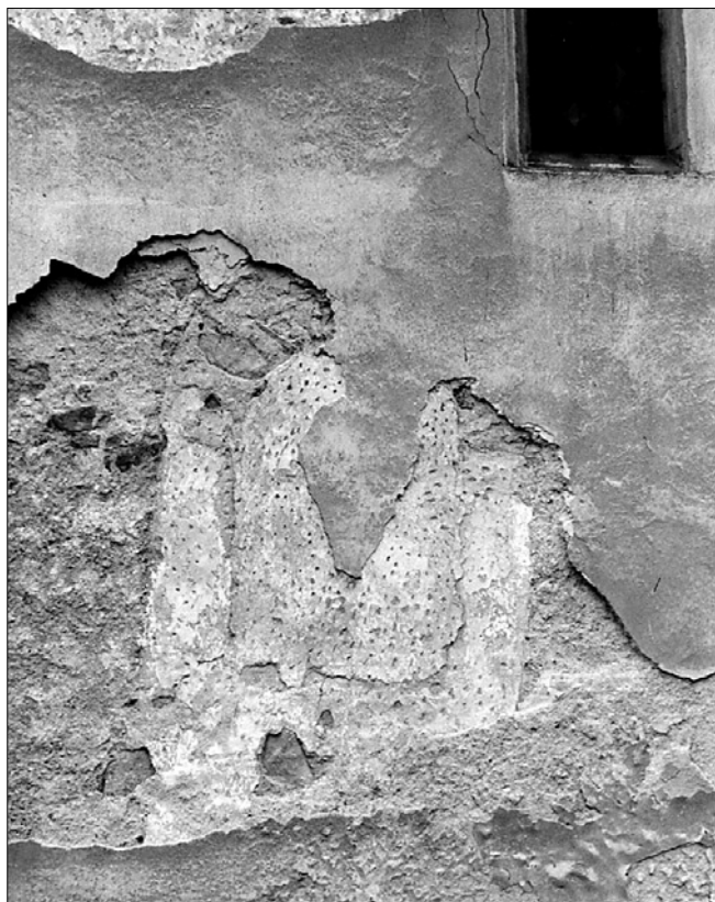
Obr. 5: Právě pozdně románské okno v severním průčelí před sejmutím omítek.
