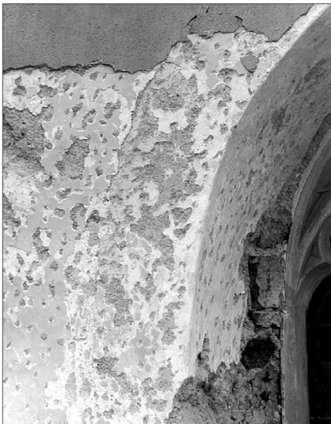
Obr. 9: Detail východního okna presbytáře se zbytky pasparty a dodatečně osazenou kružbou.
