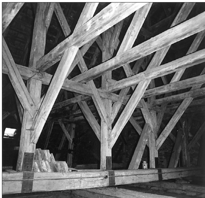
Obr. 17: Křivsoudov - kostel Narození Panny Marie, krov lodí. Foto: V. Razím.
