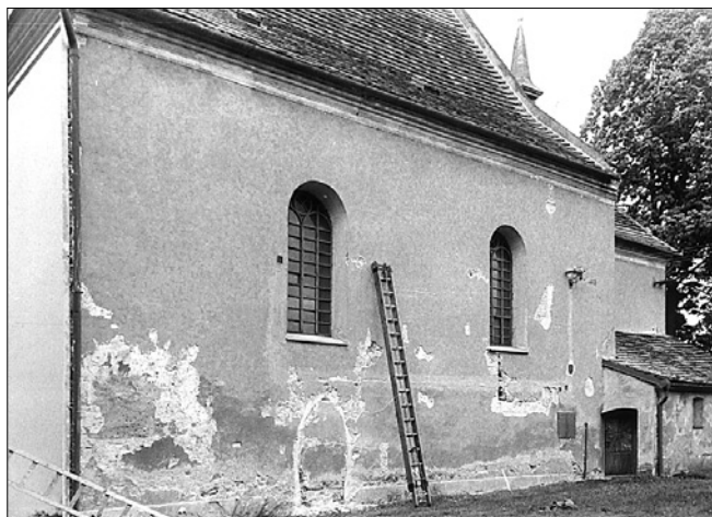
Obr. 5: Krivsoudov - kostel Narození Panny Marie, jižní průčelí lodi, stav z roku 1991. Foto autor.
