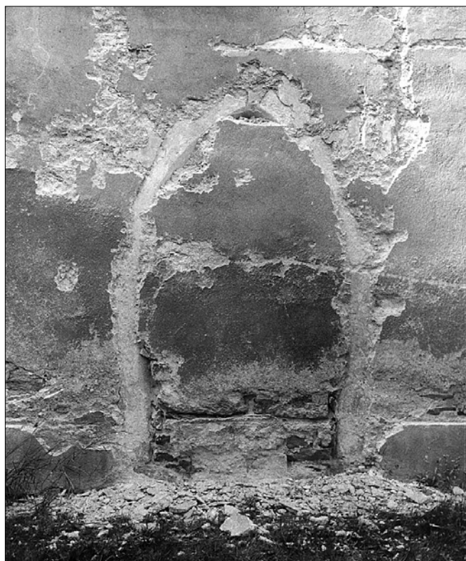
Obr. 4: Krivsoudov - kostel Narození Panny Marie, jižní průčelí lodi, odhalený gotický portál, vpravo část pozdně gotického paspartového rámu. Stav z roku 1991. Foto autor.
