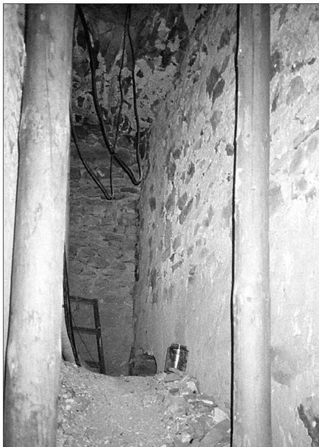
Obr. 7: Prostor někdejší hradební uličky, pohled k východu. Vpravo vnitřní líc jižní hradby, v popředí podpory schodiště. Foto autor.
