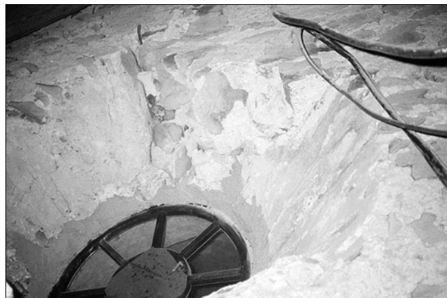
Obr. 9: Detail záklenku vnější špalety rozety. Foto autor.
