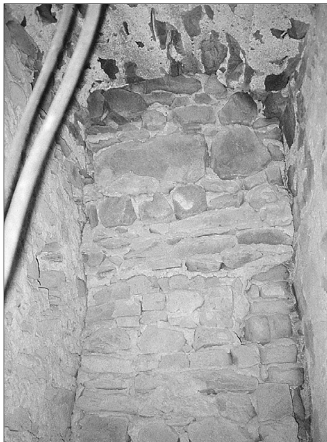
Obr. 11: Horní část dělicí zdi s čelem segmentové klenby. Foto autor.
