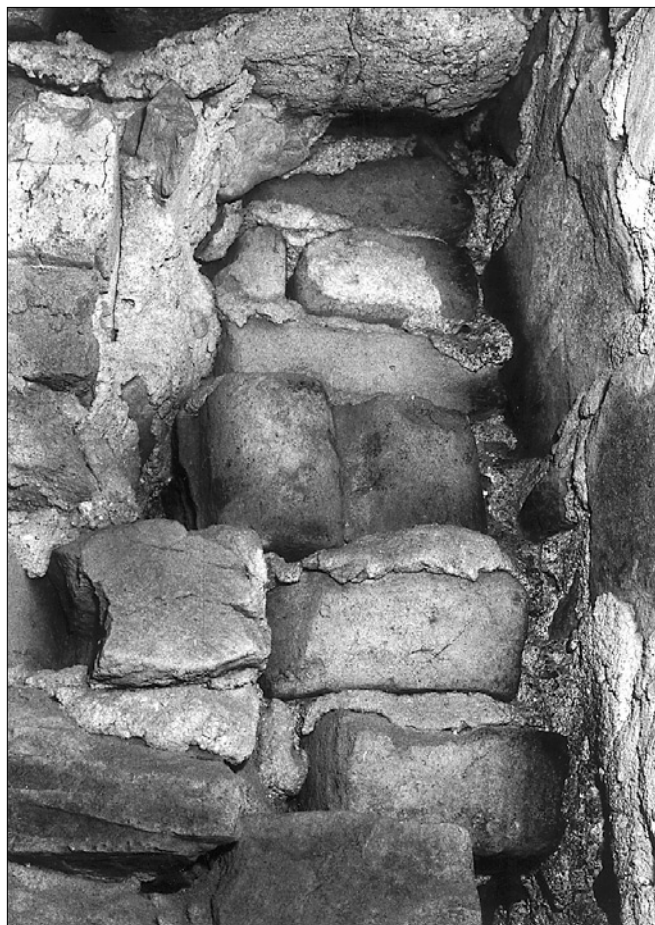
Obr. 12: Detail koutu mezi dělicí zdi a vnitřním lícem jižní hradby - cihlová zazdíčka s tvarovkou. Foto autor.
