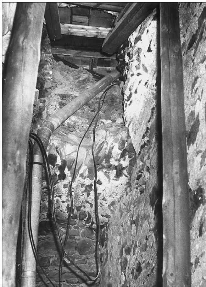
Obr. 13: Zbytky kleneb nad východní částí někdejší hradební uličky. Foto autor.
