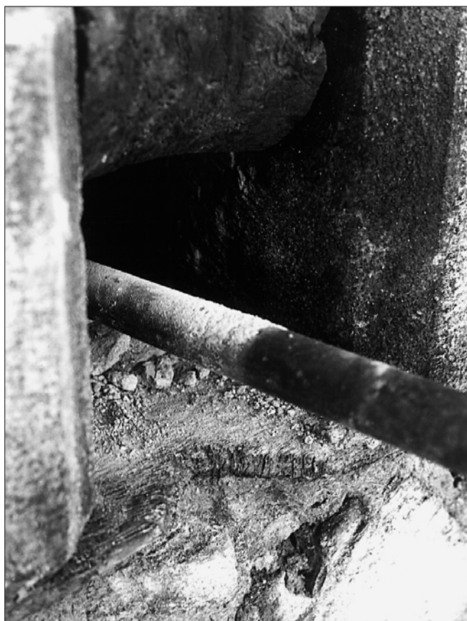
Obr. 5: Kadaň, Mikulovická brána, detail spodní části okénka s kladkou a výřezem v parapetním prkénku. Foto autor 1990.
