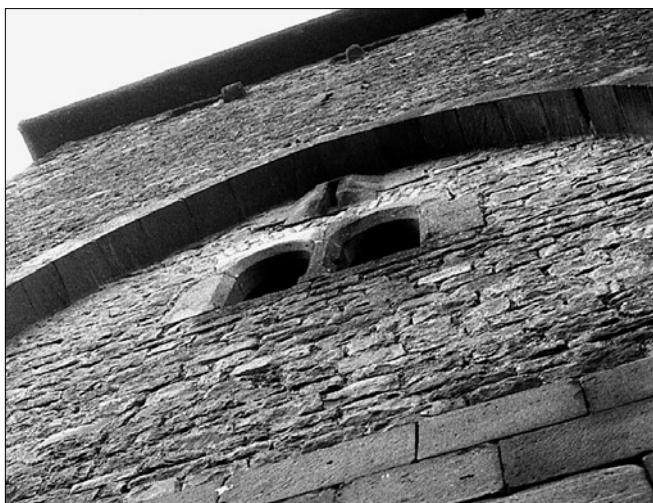
Obr. 8: Worms (Německo), detail upevnění kladky padací mříže s přesahem před líc zdiva. Foto autor 1990.
