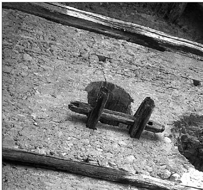
Obr. 10: Soave (Itálie), pohled do interiéru brány se zachovaným rumpálem, na nějž bylo navjeto lano padací mříže. Rumpál se otáčel pomocí vyjímátných pák umístěných na jeho koncích, jimiž se zároveň mohla nastavovat poloha mříže. Foto autor 1993.
