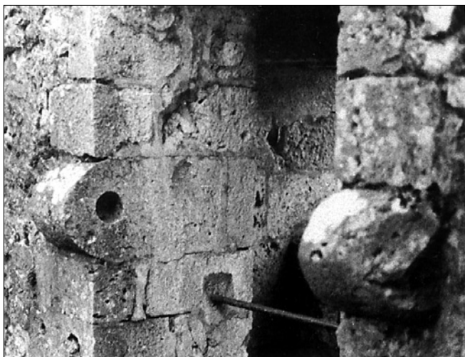
Obr. 7: Provins (Francie), detail upevnění kladky padací mříže s konzolovitě vyloženými lůžky hřídele. Reprofoto autor.
