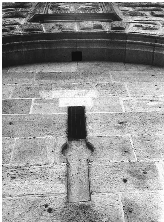
Obr. 11: Esslingen (Německo), lano padací mříže bylo vedeno otvorem v záklenku vpadliny na průčelí brány. Foto autor 1989.
