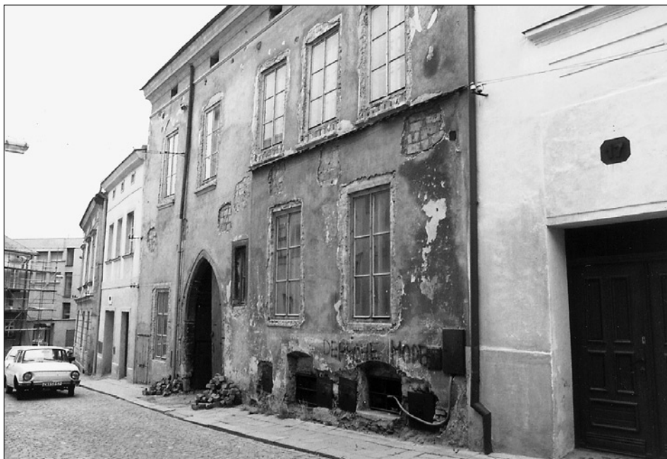
Obr. 1: Znojmo, hlavní uliční průčelí objektu v Zelenářské ulici čp. 15. (Foto autoři.)
