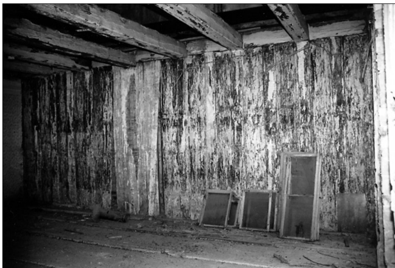
Obr. 15: Znojmo, dům čp. 15. Místnost s dřevěným obložením v patře (místnost č. 205), západní stěna (viz obr. 13). (Foto autoři.)
