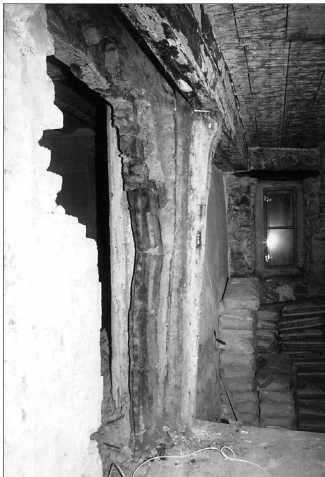
Obr. 18: Znojmo, dům čp. 15. Dřevěný sloupek na podestě peronu (místnost č. 104) po pravé straně vstupu do roubené obytné místnosti (viz obr. 7). (Foto autoři.)
