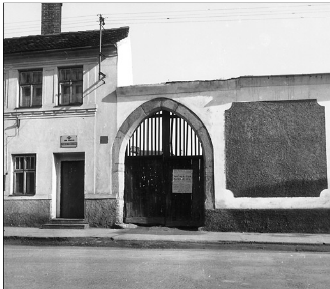
Obr. 3: Touškov, čp. 31 a 32, pohled na část zaniklého průčelí od západu s pozdně gotickým portálem. (Foto z archivu PÚ Plzeň, 1961.)
