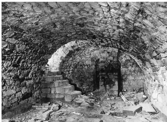
Obr. 16: Touškov, čp. 72, pohled do sklepa od čelní stěny, typický příklad sklepa touškovského městského domu. (Foto z archivu PÚ Plzeň, 1979.)
