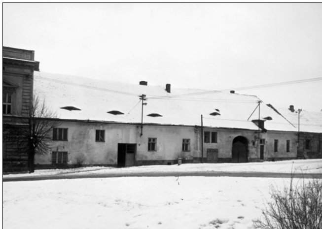
Obr. 2: Touškov, čp. 72 a 73, pohled od severu před demolicí čp. 73 (vpravo). (Foto z archivu PÚ Plzeň.)
