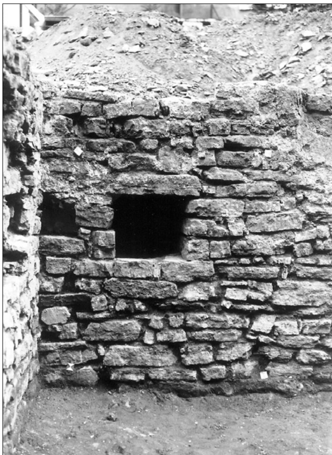
Obr. 5: Praha 1 - Staré Město, Rybná ul. čp. 682/I. Západní část severní stěny sklepa břidlicového domu s nikou a částí omítnuté spodní partie násypného otvoru. Pohled od jihu. (Foto F. Malý, 1992.)
