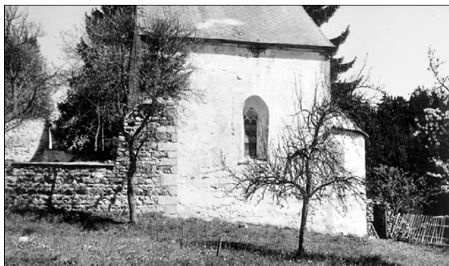
Obr. 11: Pomezí, kostel sv. Jana Křtitele, východní část, pohled od jihu. (Foto P. Břicháček, 1991.)
